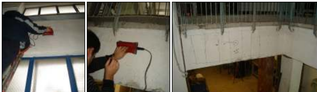
Εικόνα 13 Ταχείες Γραμμικές Σαρώσεις (α) Δοκός Δ1, (β) Δοκός Δ2, (γ) Αποτύπωση επί της Δοκού Δ2
