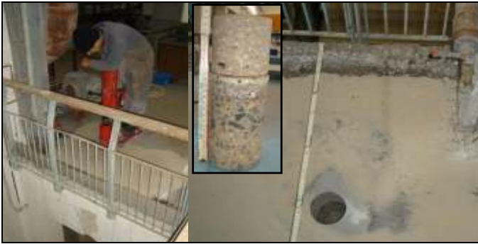
Εικόνα 8 Θέση πυρηνοληψίας πυρήνα Π1 στα όρια της πλάκας ισογείου στο κλιμακοστάσιο προς το Υπόγειο. Διακρίνεται η μερική διάτρηση της οπής της πλάκας.
