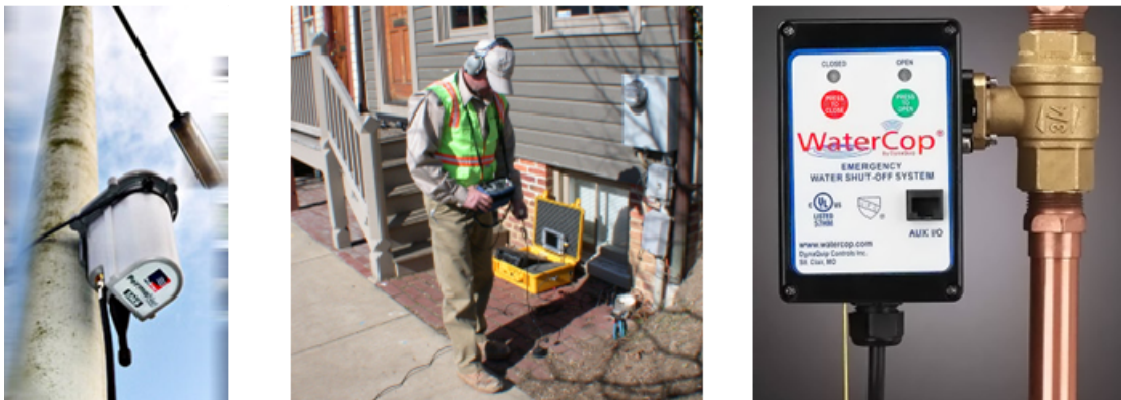
Εικόνα 2-10 Ασύρματη και χειροκίνητη ανίχνευση διαρροών σε δίκτυα (Πηγή www.linelocators.com και www.watercopdealer.com )
