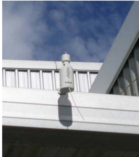
Εικόνα 2-15 Αισθητήρας βροχής στην οροφή κτιρίου με ενσύρματη σύνδεση (Πηγή www.toro.com.au )
