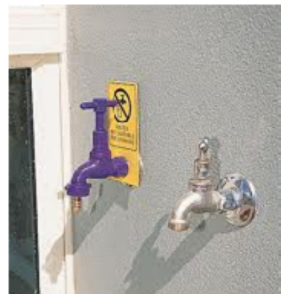
Εικόνα 2-3 Χρωματικός διαχωρισμός των δύο δικτύων (Πηγή www.limno.com )
