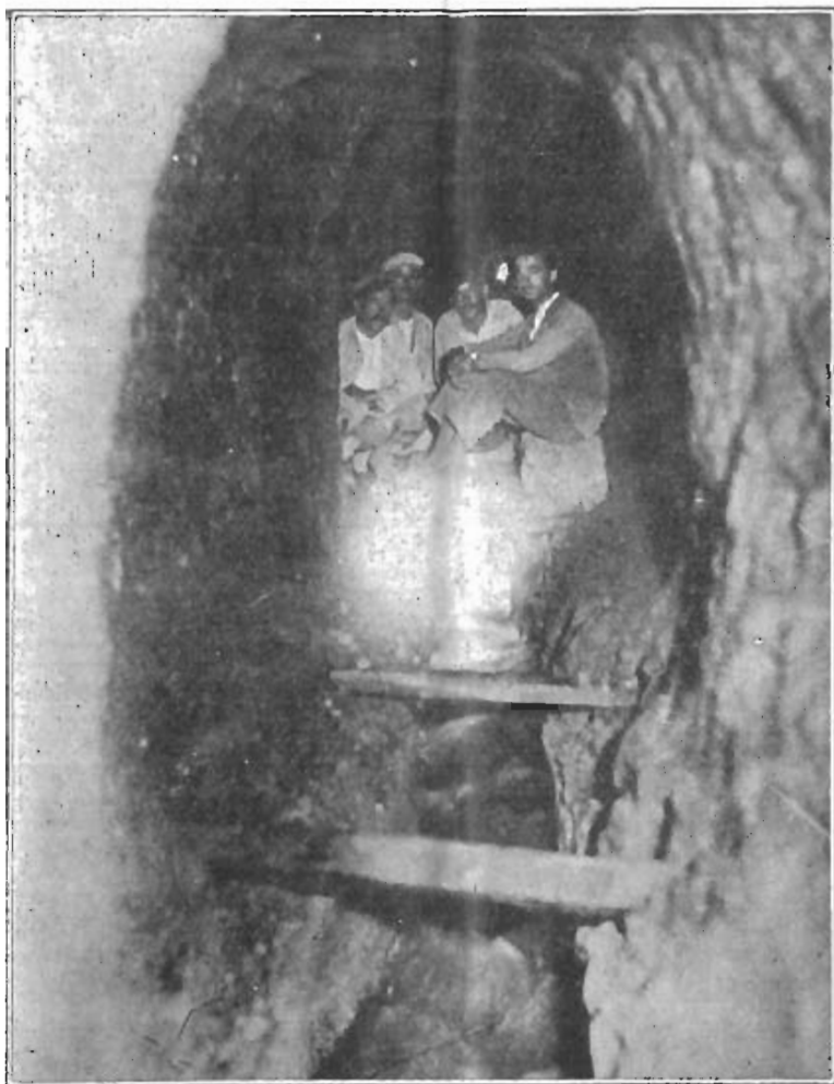
Ἐνασκειὺ ἑτέρου κατεστραμμένον τμήματος τοῦ Ἀδριανείου ἰδραγωγείου παρὰ τὸ Ἡράκλειον. (Βάθος 32 μέτρων)
