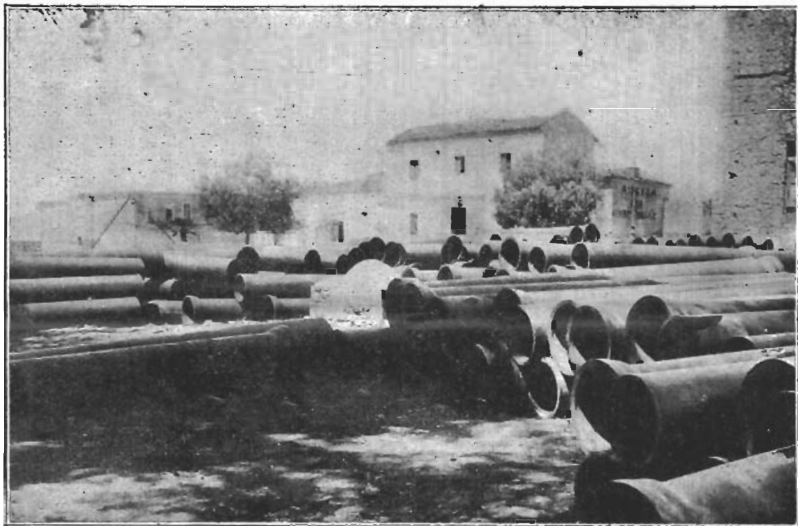
Ἀποθήκη αἰθροδωλῶν 60 ἑκατ. διαμέτρου διὰ τὴν ἀντικατάστασιν τοῦ Ἀδριανείου ὑδραγωγείου ἐν Ἀμπελοκήποις.
