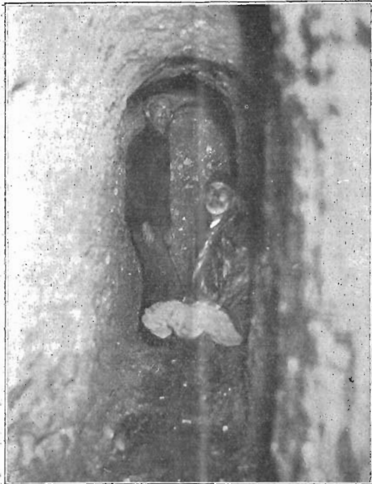
Νέαι υδροσυλλεκτήριοι υπόγειοι στοαί Πάργουθος. (Βάθος 34,00 μ.)
