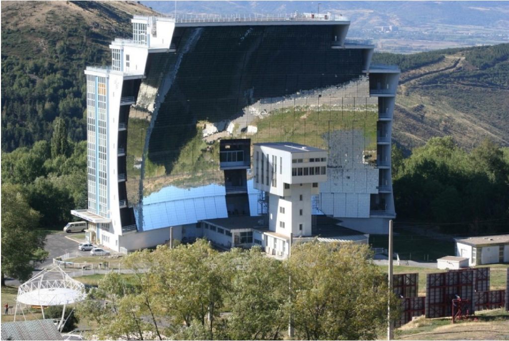
Εικόνα 4.18: Ο ηλιακός φούρνος του Odeillo – Font – Romeau στα Γαλλικά Πυρηναία. Ο παραβολικός ανακλαστήρας είναι ιδιαίτερα αποδοτικός στη συγκέντρωση των ηλιακών ακτίνων.
