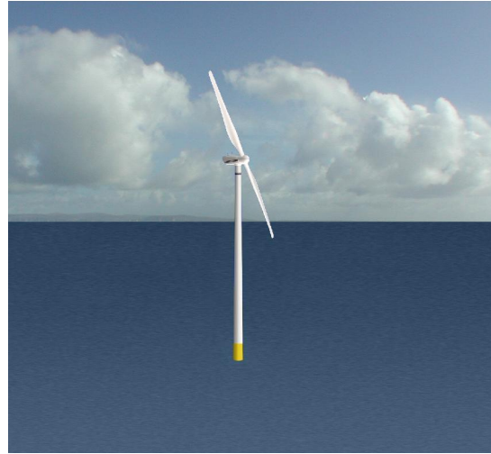
Εικόνα 4.10: Διπτέρυγες ανεμογεννήτριες οριζόντιου άξονα – λιγότερο συνήθεις αλλά μπορεί να είναι πιο αποδοτικές και ευκολότερες στη συντήρηση (Πηγή: Ιστοσελίδα Aquaret, 2012).
