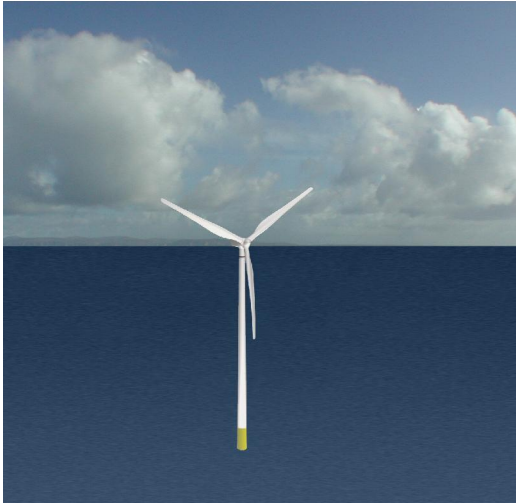
Εικόνα 4.9: Οι τριπτέρυγες ανεμογεννήτριες οριζόντιου άξονα είναι η πλέον δημοφιλής διάταξη. Η παραγόμενη ενέργεια σχετίζεται με την επιφάνεια σάρωσης του αέρα από τα πτερύγια (Πηγή: Ιστοσελίδα Aquaret, 2012).
