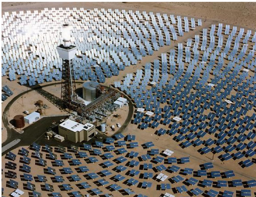
Εικόνα 4.15: Ηλιακός σταθμός παραγωγής ηλεκτρικού ρεύματος στο Barstow της Καλιφόρνια (ο πύργος κατεδαφίστηκε το 2009).
