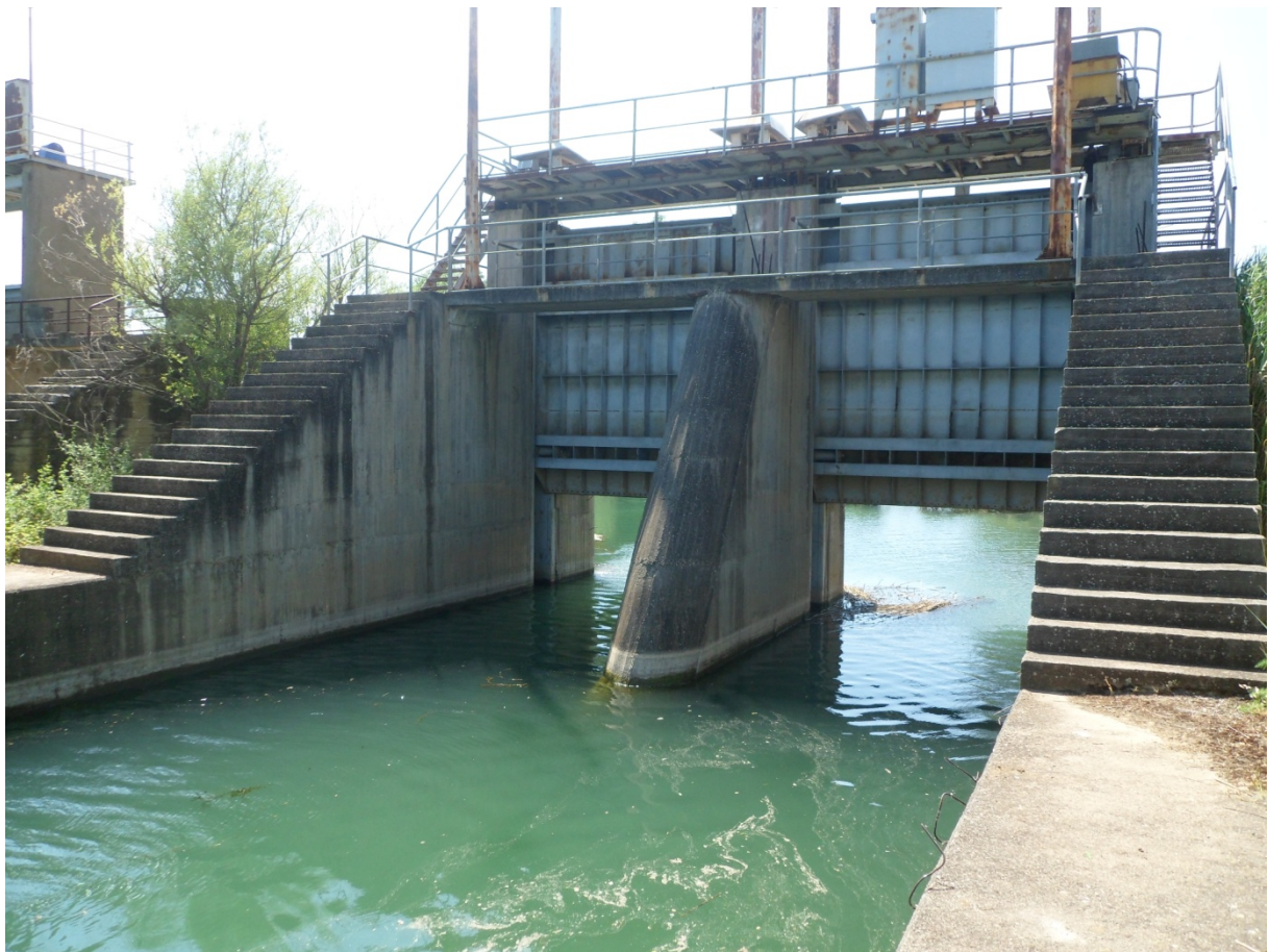
Εικόνα Α.14 Όψη μέρους του φράγματος BOOT.
