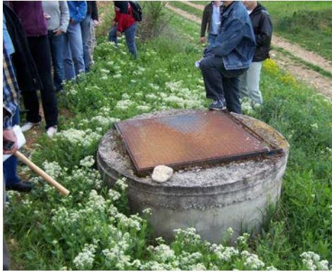
Εικόνα 2: Qanat στη Νέα Ζίχνη Σερρών. Αριστερά: Ένα πηγάδι του qanat (Φωτ. Βουδούρης, Κ.). Δεξιά: Η σήραγγα του qanat (Φωτ. Ανδρέου, Γ.). (A well and the tunnel of the qanat in Nea Zichni constructed in the 18 th century).
