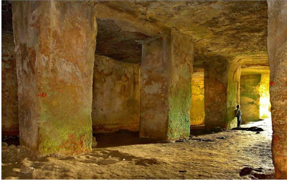
Εικόνα 2 Ελληνιστική στέρνα στην αρχαία πόλη της Ελεούθερνας, Ρέθυμνο. (Carved Hellenistic cistern in the ancient town of Eleftherna, Rethymnon, of about 1000 m 3 ).
