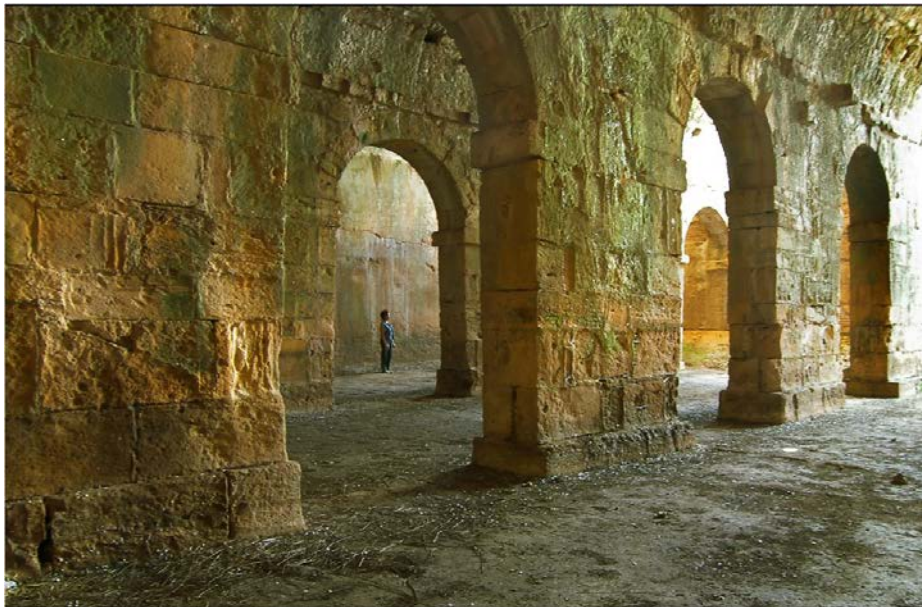
Εικόνα 3 Εσωτερικό Ρωμαϊκής στέρνας στην αρχαία πόλη της Απτερά, Χανιά. (Interior view of the three- aisled vaulted Roman cistern in the ancient town Aptaera, Chania of about 3000 m 3 ).
