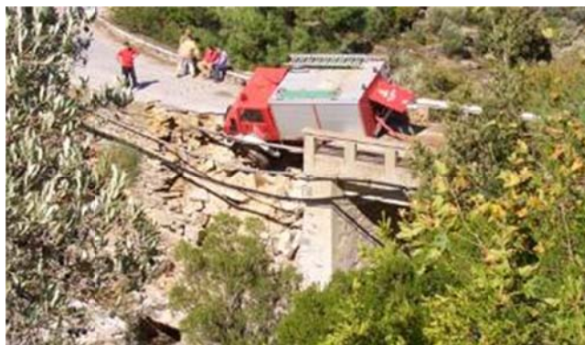
Εικόνα 5. 1 Κατάρρευση γέφυρας στον Αγ.Πολύκαρπο και το όχημα της Πυροσβεστικής που κινδύνευσε (πηγή: Ριζοσπάστης)
