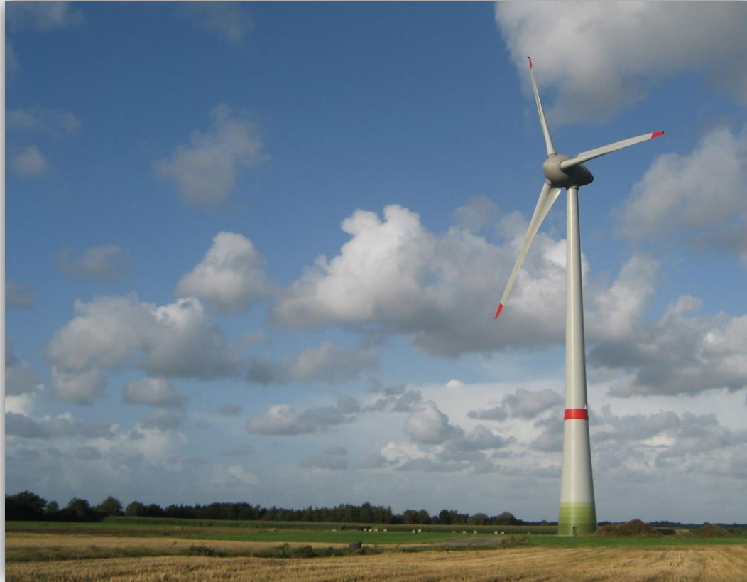
Εικόνα 6-5: Ανεμογεννήτρια E-126/7,5 MW/38 της Enercon
