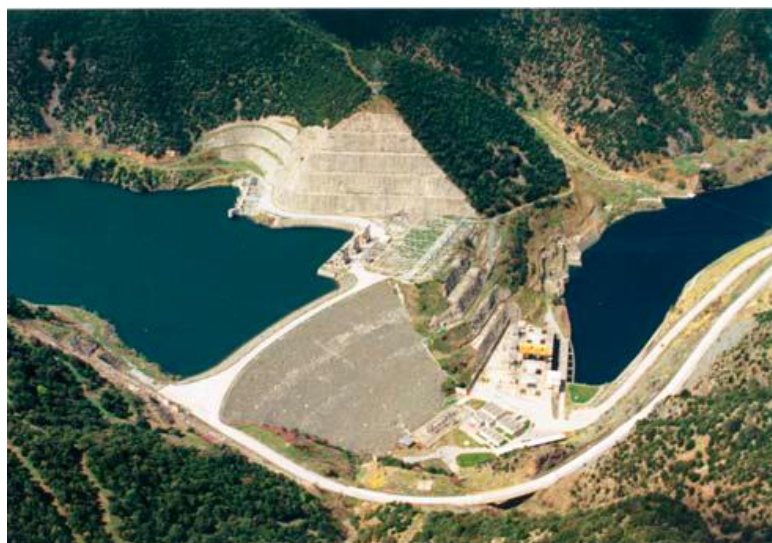
Εικόνα 4-9: Φράγμα ΥΗΕ Σφηκιάς.
