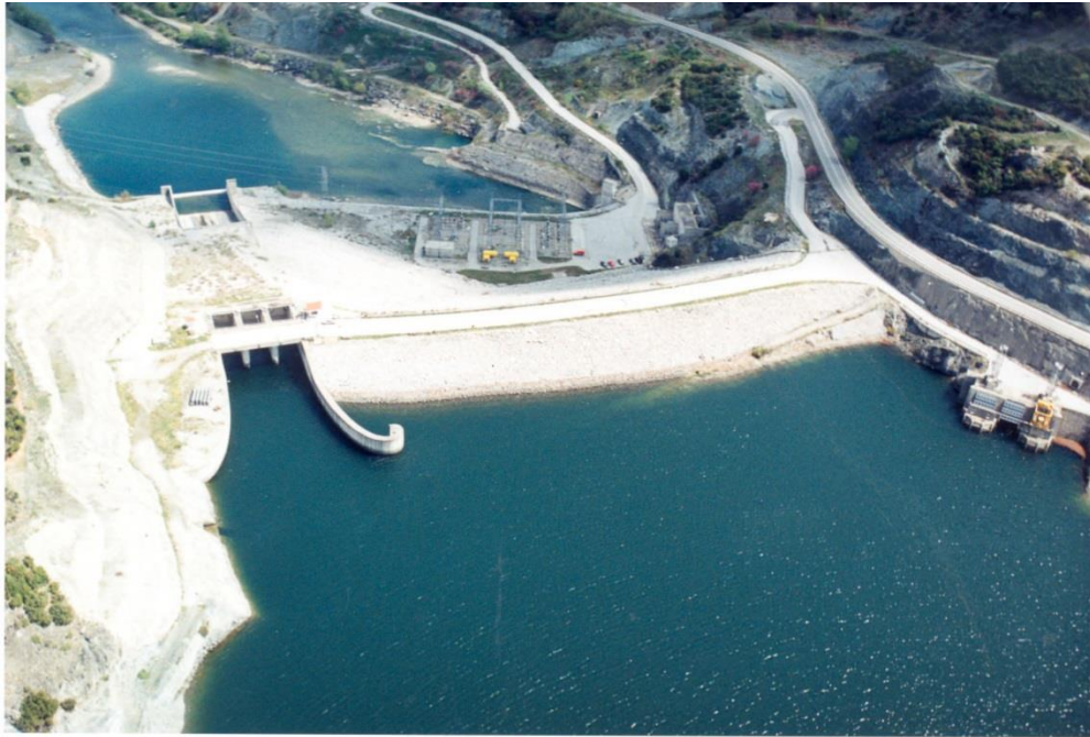
Εικόνα 4-10: Φράγμα ΥΗΕ Ασωμάτων.
