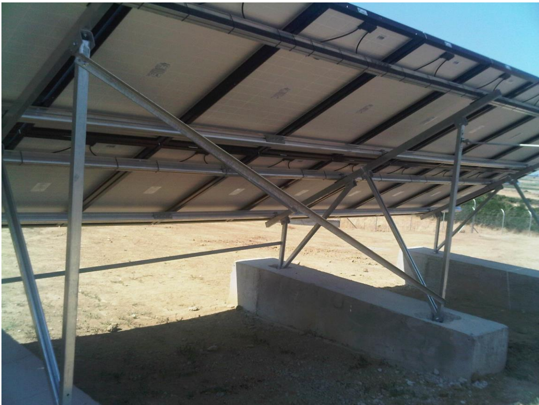
Εικόνα 2.33: Σταθερές βάσεις στήριξης συναρμολογημένες στο φ/β πάρκο
