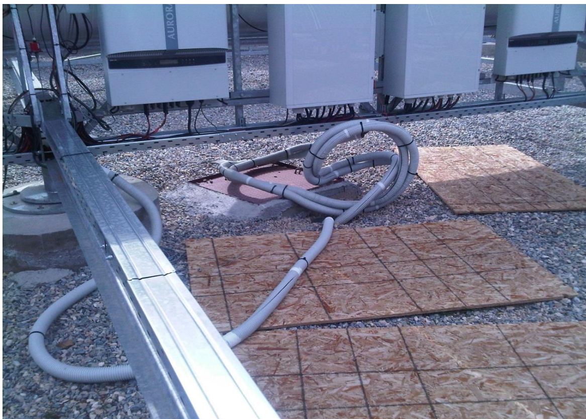
Εικόνα 2.15 : Υπόγεια καλωδιακή σύνδεση αντιστροφών με τον κεντρικό πίνακα.
