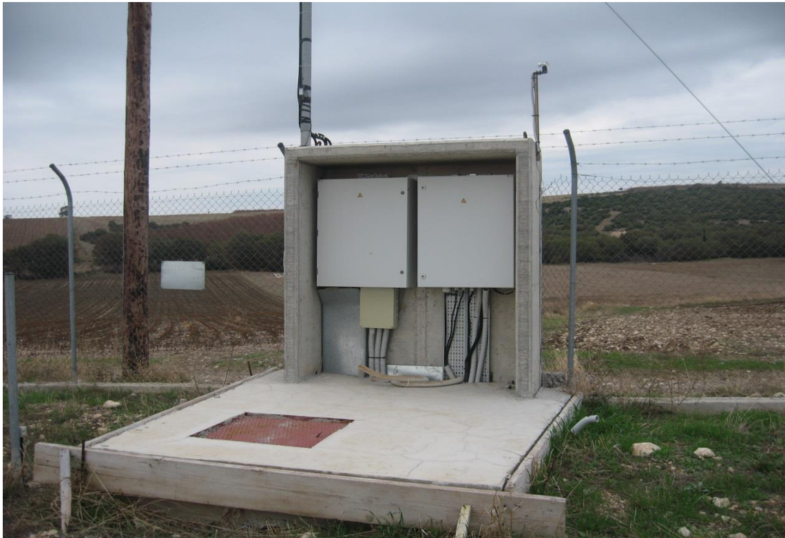
Εικόνα 2.7: Κεντρικός πίνακας παραγωγής
