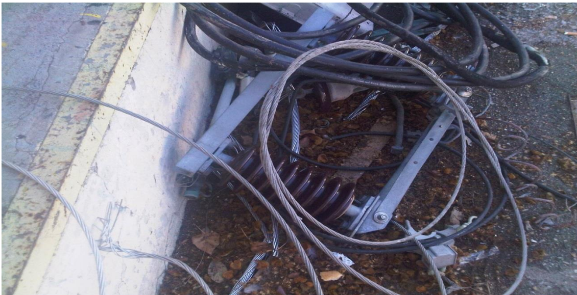
Εικόνα 2.37: Βλάβη στον μετασχηματιστή της Δ.Ε.Η.
