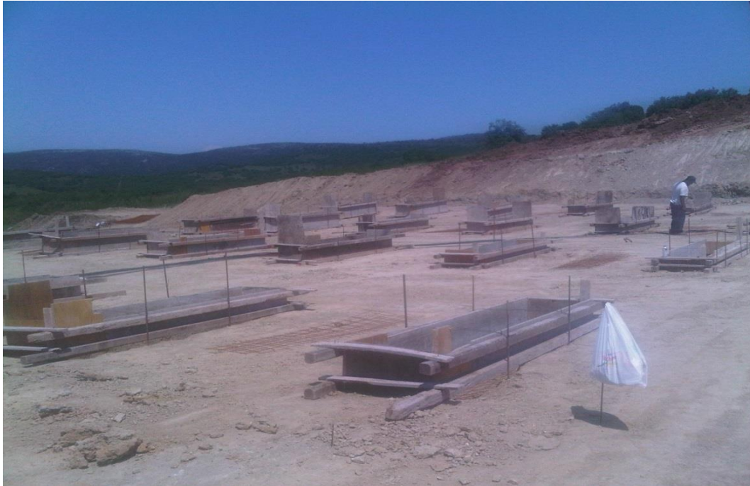
Εικόνα 2.26 : Αφού έχουν ολοκληρωθεί οι εκσκαφές των θεμελίων και έχουν τοποθετηθεί οι ξυλότυποι
