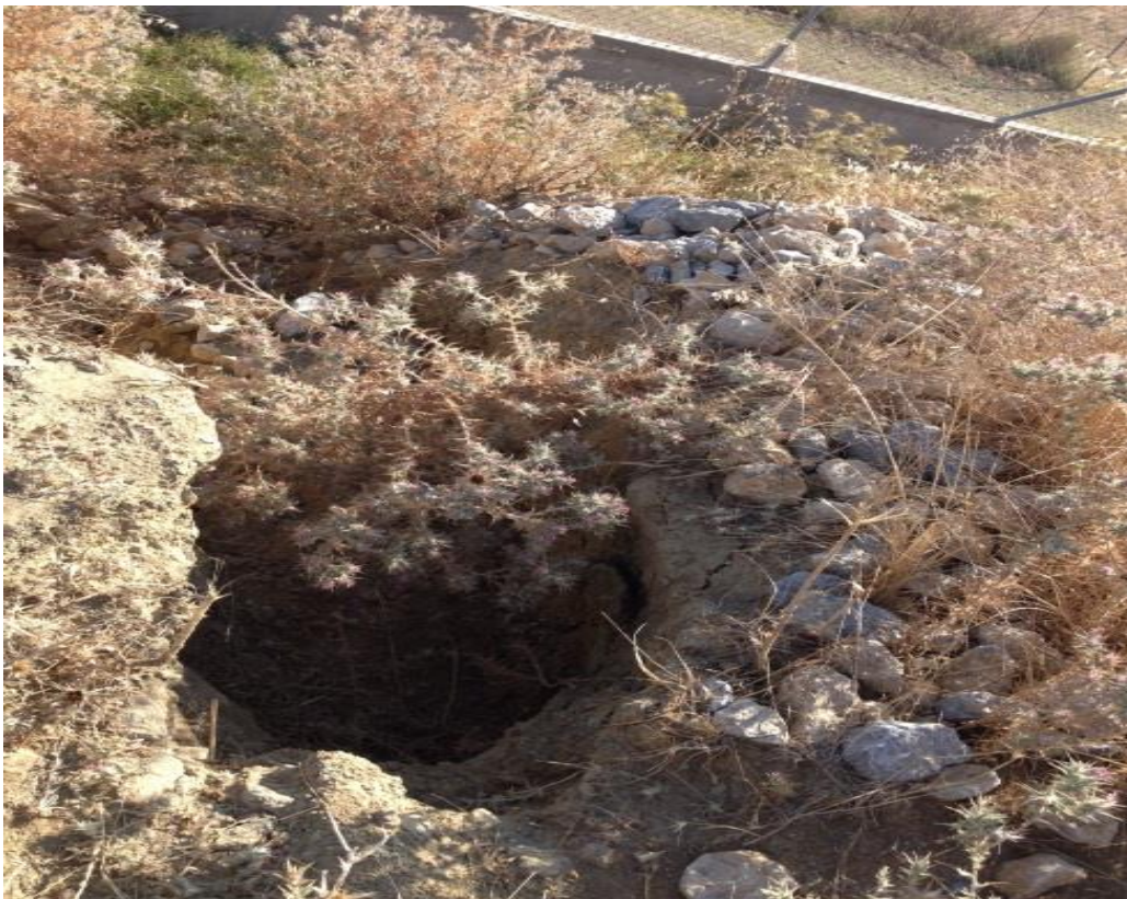
Εικόνα 2.38: Διάβρωση στο τεχνητό πρανές προς την περίφραξη του φ/β σταθμού
