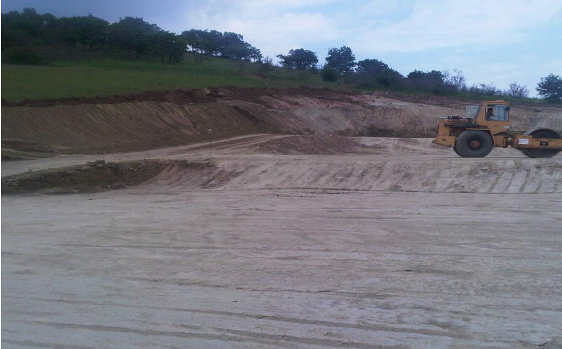
Εικόνα 2.25: Γήπεδο εγκατάστασης φωτοβολταϊκών μετά τη διαμόρφωση της κλίμακας επιπέδων
