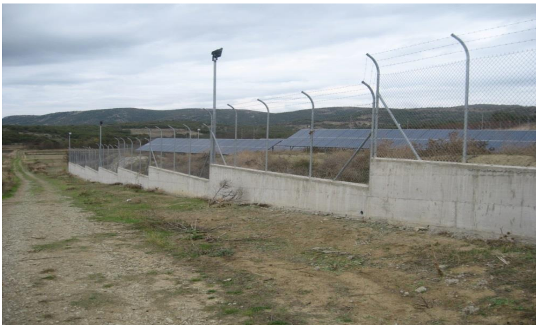
Εικόνα 2.28 : Περίφραξη και δίκτυο φωτισμού
