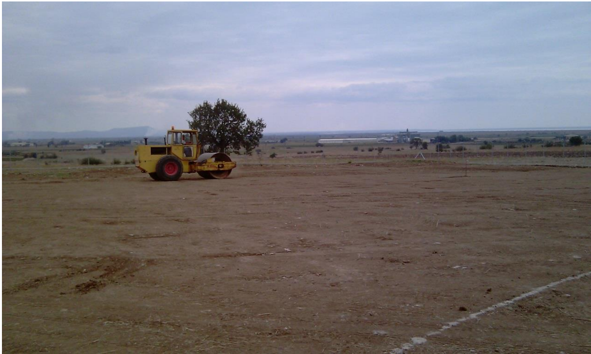
Εικόνα 2.5 : Ο οδοστρωτήρας κατά την ομαλοποίηση του εδάφους
