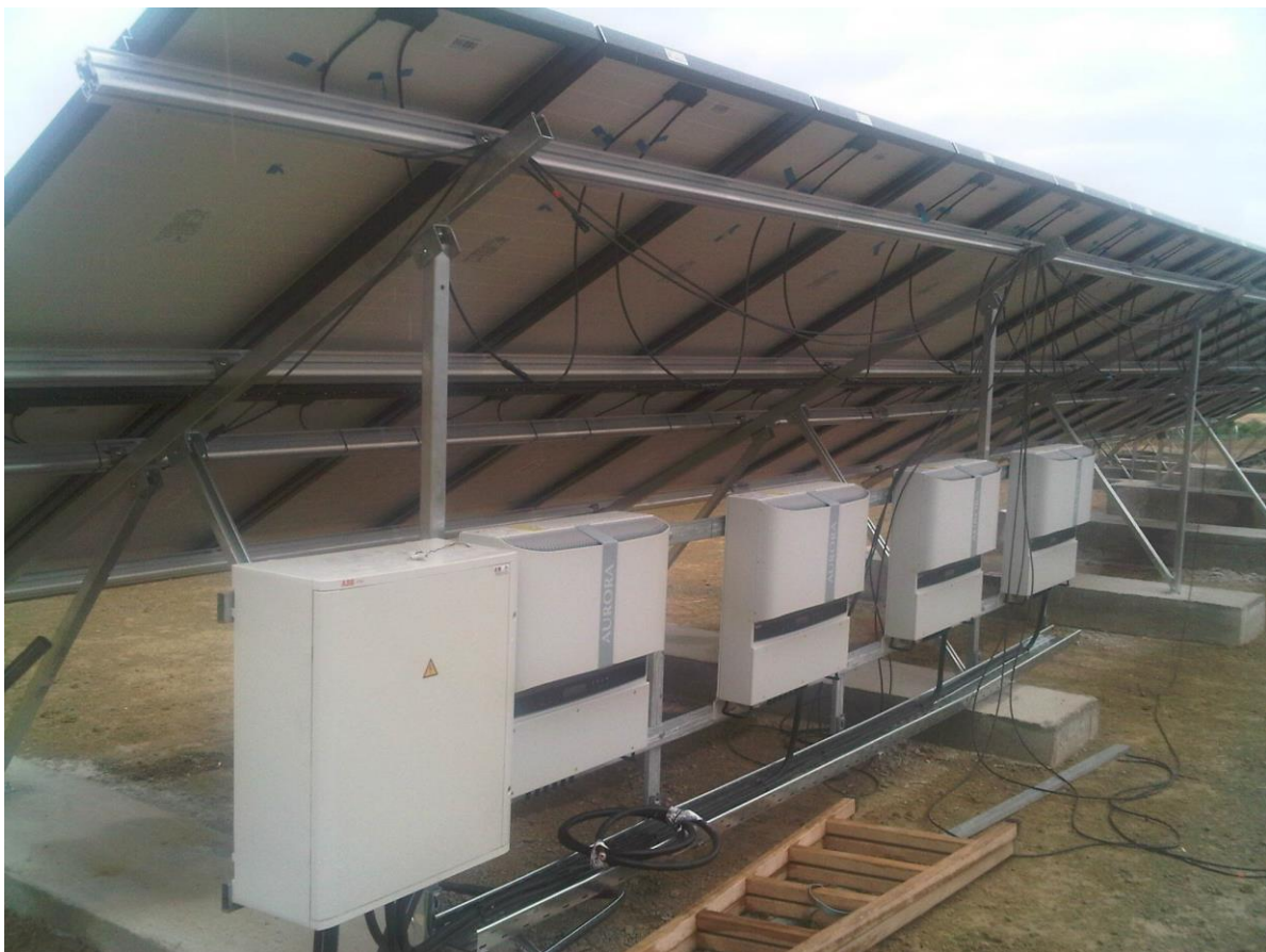
Εικόνα 2.29 : Αντιστροφείς ρεύματος , υποπίνακας AC και πίσω όψη φ/β πλαισίων
