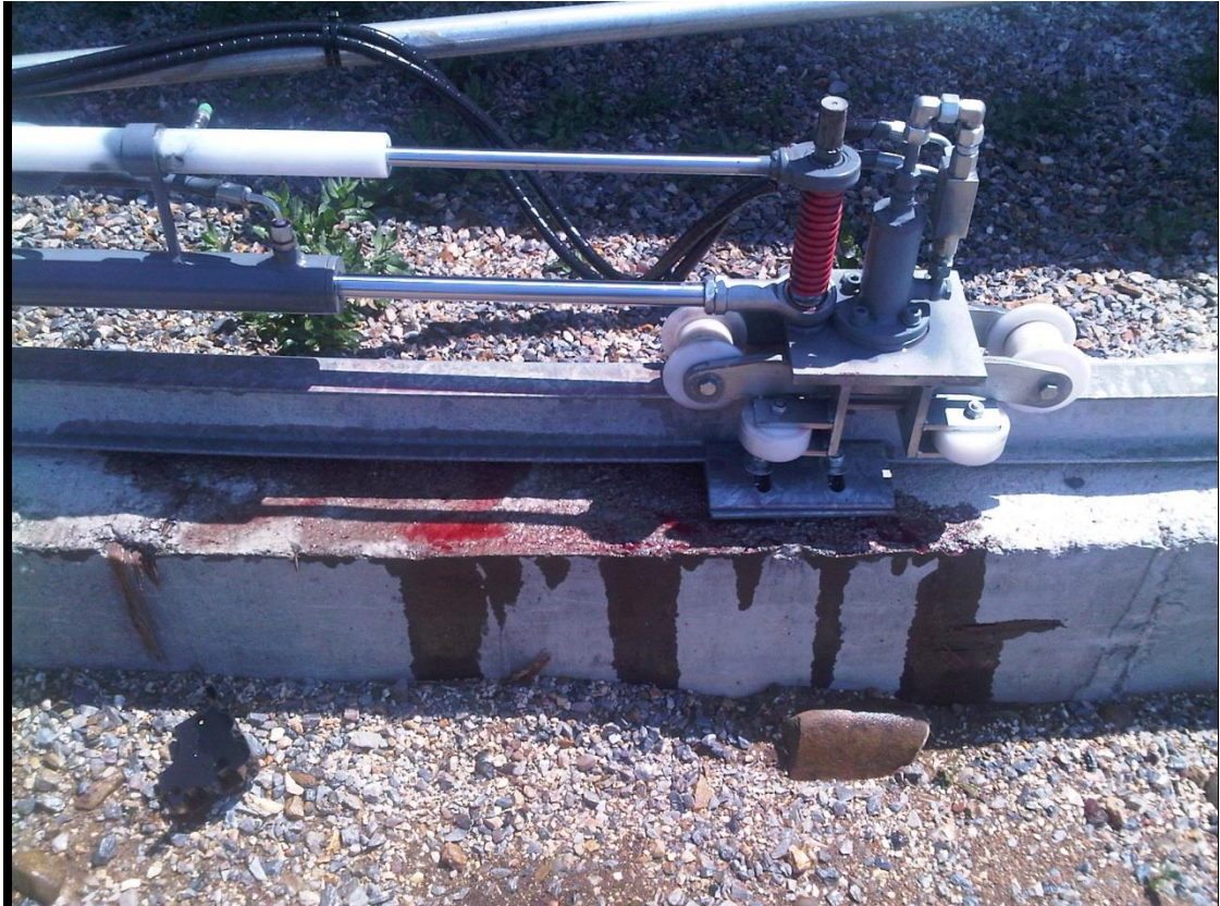
Εικόνα 2.36: Βλάβη στο υδραυλικό σύστημα κίνησης
