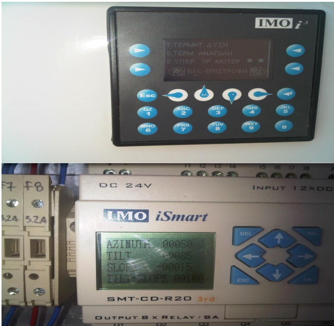
Εικόνα 2.22: Κεντρικός υπολογιστής (Master PLC)(πάνω), Βοηθητικός υπολογιστής (Slave PLC)(κάτω)
