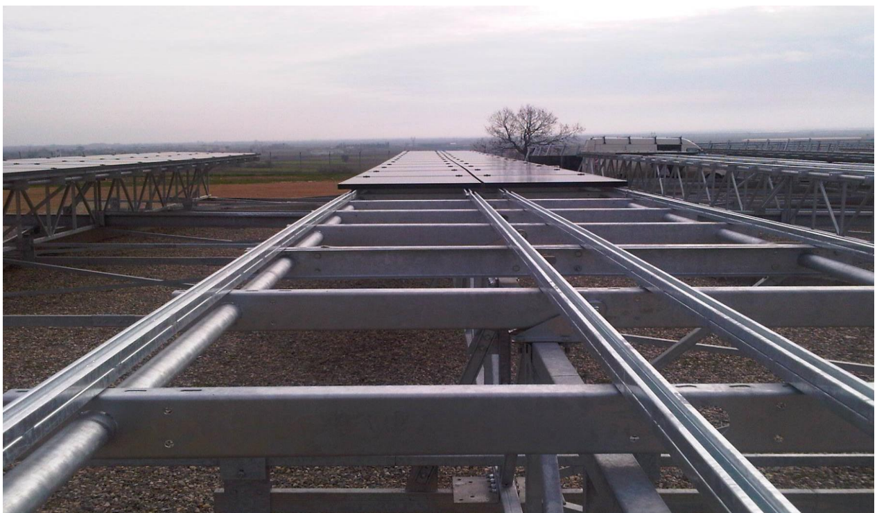
Εικόνα 2.13 : Τοποθέτηση φωτοβολταϊκών πλαισίων
