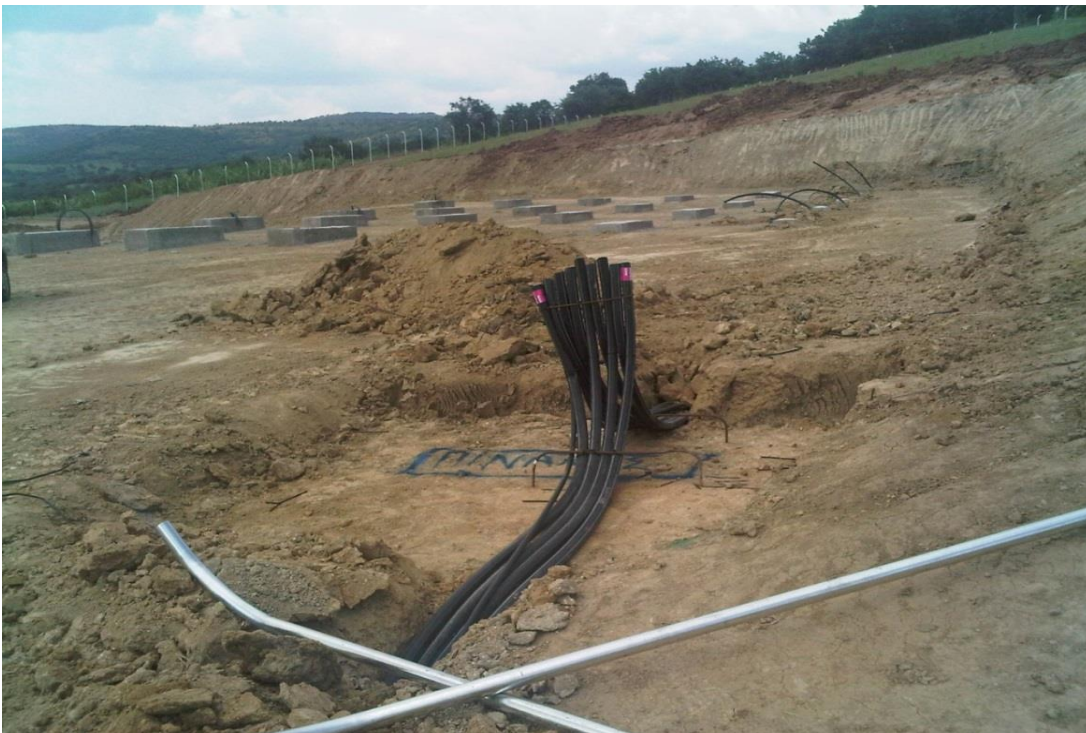
Εικόνα 2.27 : Σωλήνες όδευσης των καλωδίων προς τον κεντρικό πίνακα και προς τον μετρητή της Δ.Ε.Η.
