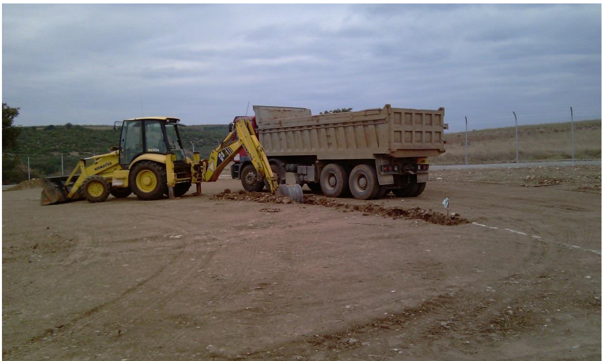
Εικόνα 2.6 : Εκσκαφή των θεμελίων για τις βάσεις στήριξης
