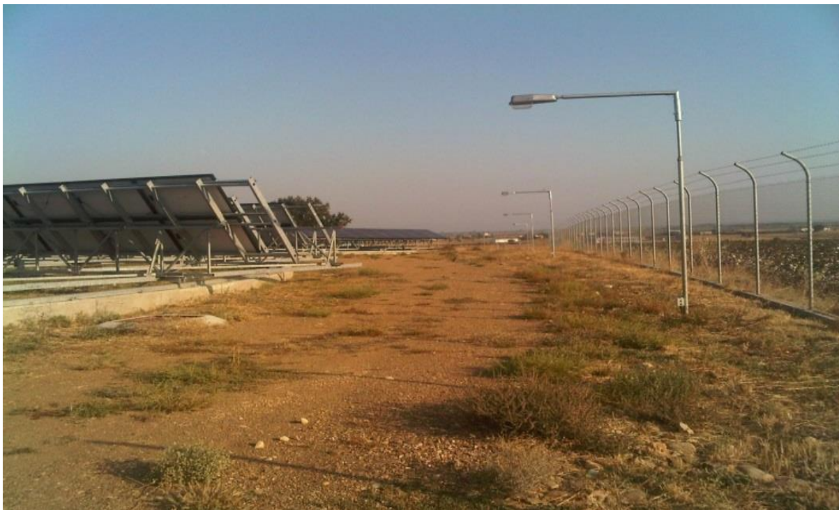
Εικόνα 2.8: Περίφραξη και σύλος φωτισμού
