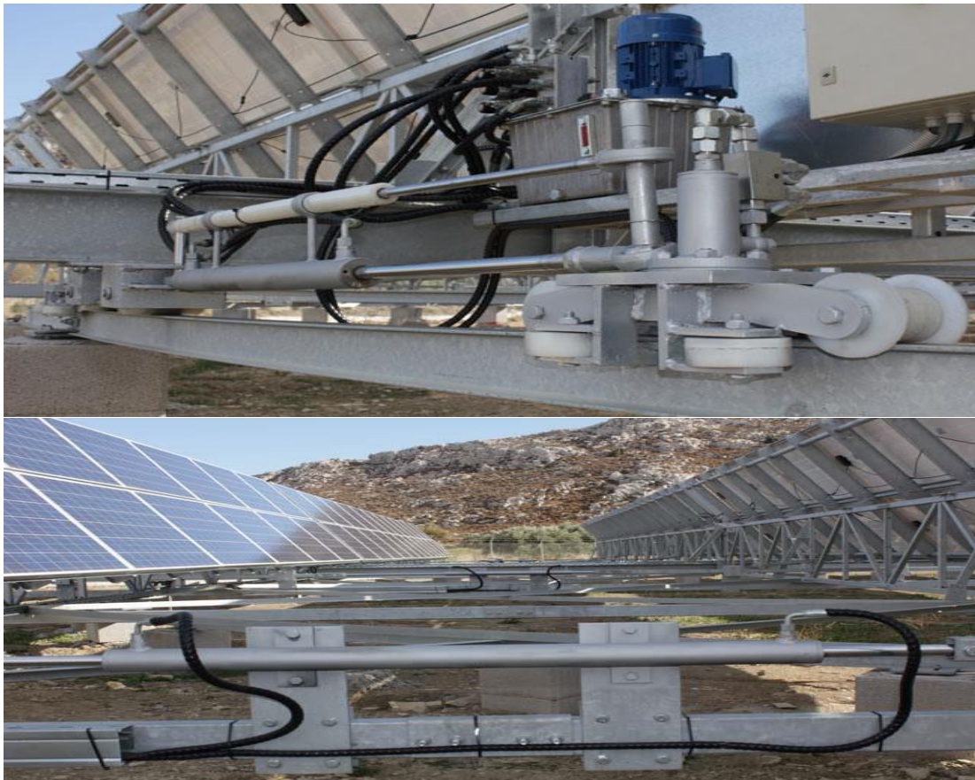
Εικόνες 2.21: Υδραυλικά έμβολα πρόωσης και κλίσης
