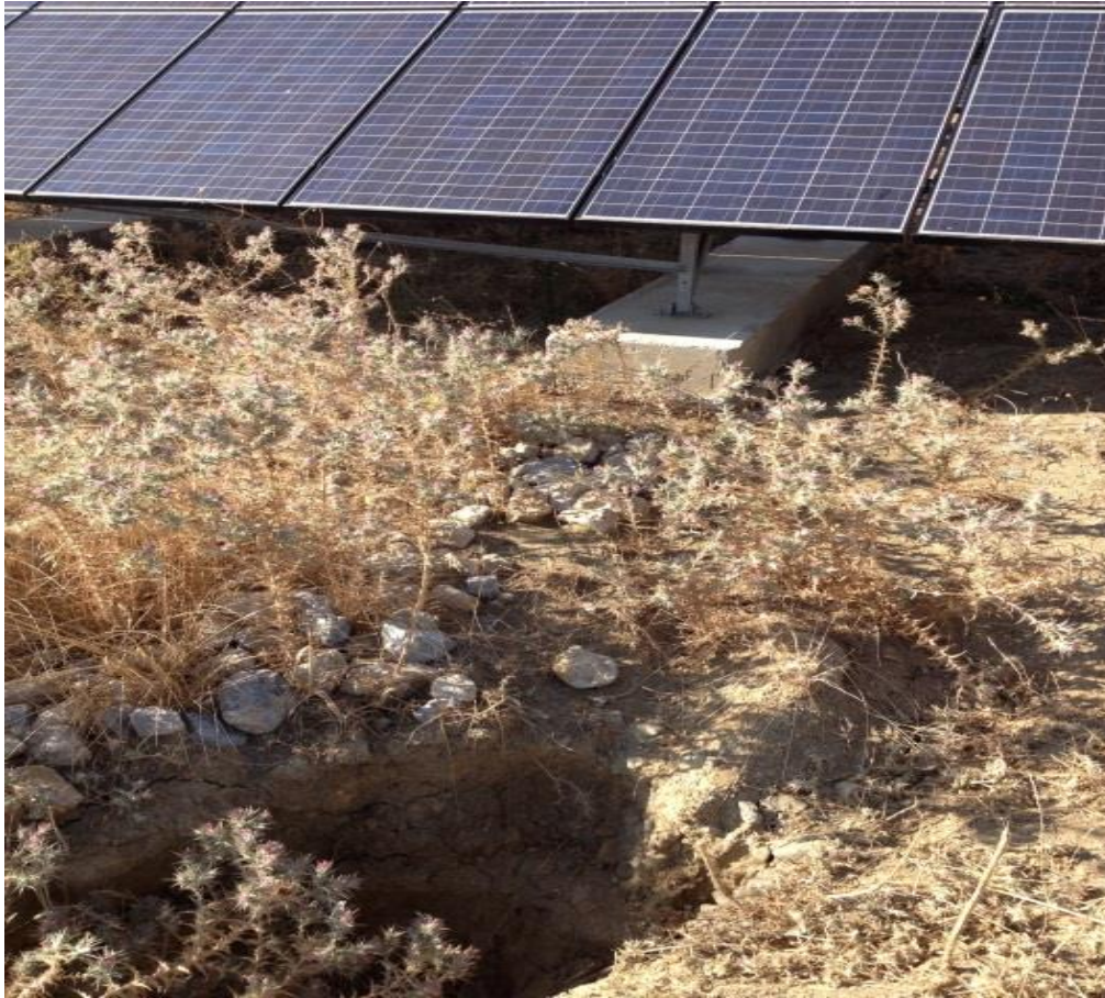
Εικόνα 2.37 : Διάβρωση του πρανούς προς το θεμέλιο των φωτοβολταϊκών
