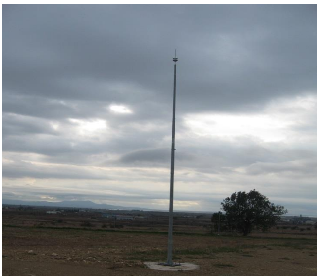
Εικόνα 2.35: Αλεξικέραυνο στο φ/β σταθμό Αγνάντιας
