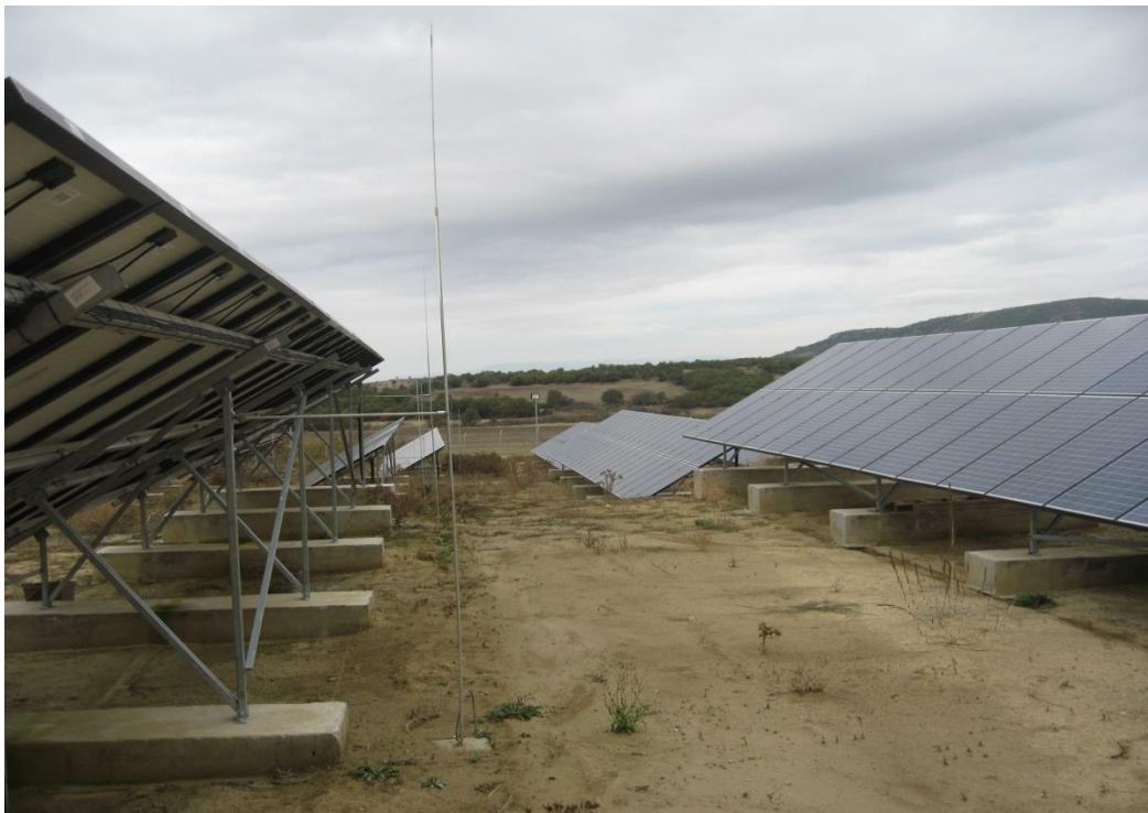
Εικόνα 2.34 : Ακίδες συλλογής για την αντικεραυνική προστασία στον φ/β σταθμό Μοναστηράκι
