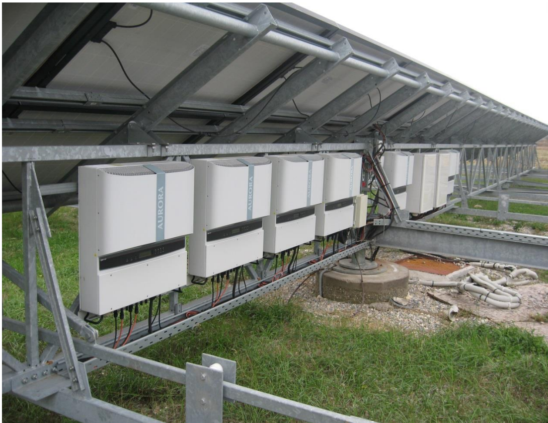
Εικόνα 2.14 : Αντιστροφεείς ρεύματος
