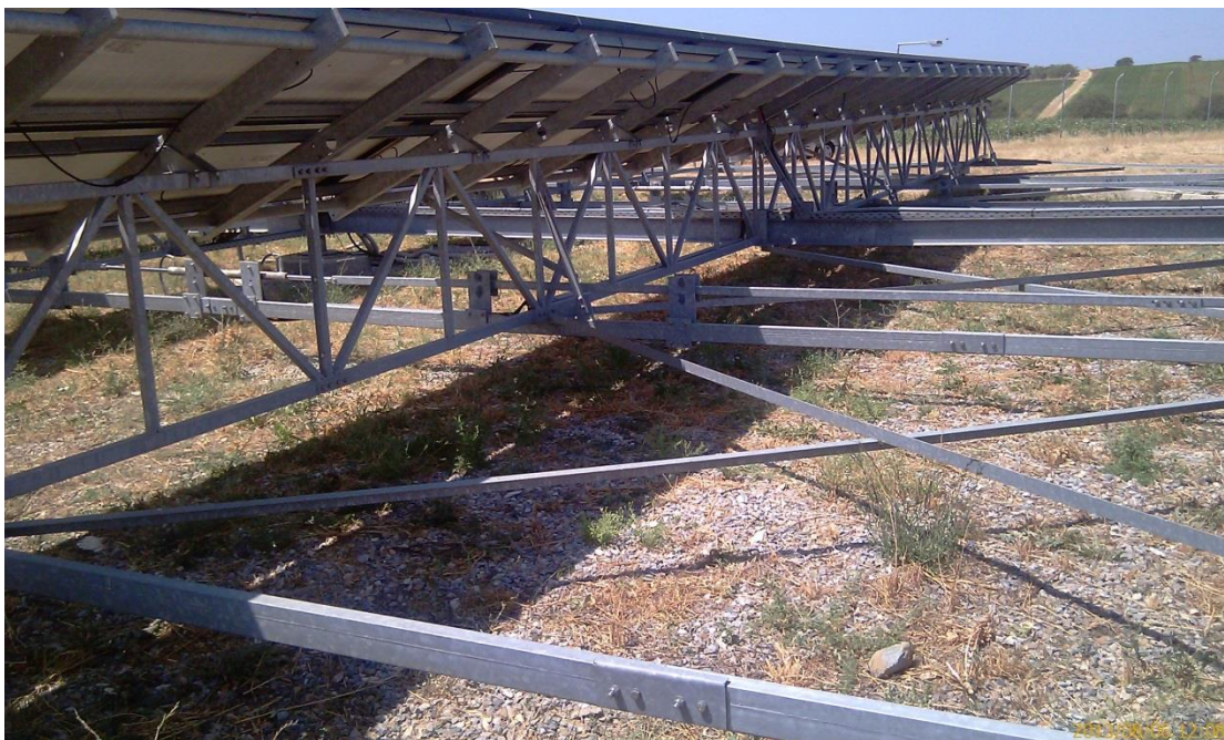
Εικόνες 2.19, 2.20 : Σιδηροτροχιά(1), IPE στήριξης σκελετού(2), Ζευκτά στήριξης(3), Παράπετα πλαισίων(4)
