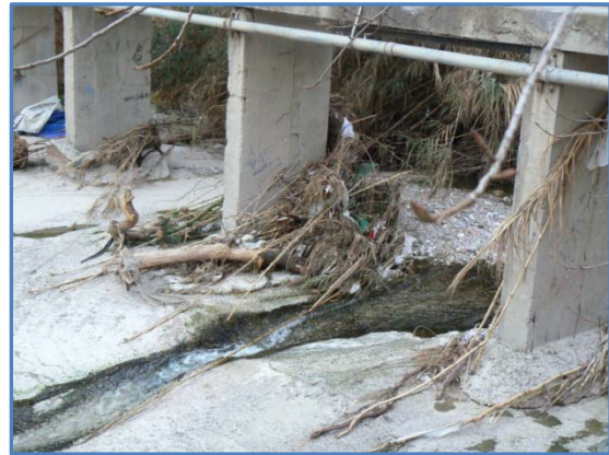
Εικόνες 24-25: Η πεζογέφυρα Κορύζη από κατάντη, με λεπτομέρεια από πιασμένα δέντρα και καλάμια στα μεσόβαθρα στήριξής της (1 χρόνο περίπου μετά το πλημμυρικό γεγονός της 22-02-2013) (Πηγή: ίδια).
