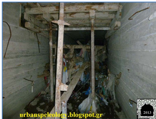
Εικόνα 11: Υπόγειο τμήμα του ρέματος, με εμπόδια από τη φάση κατασκευής του έργου, πάνω στα οποία έχουν συσσωρευτεί σκουπίδια (Πηγή: http://urbanspeleology.blogspot.gr ).
