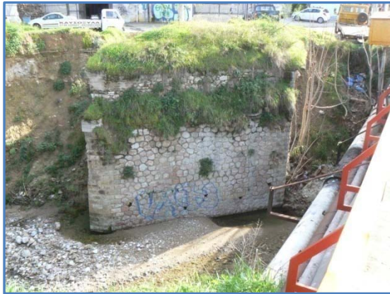
Εικόνες 50-51: Οδογέφυρα Αγ. Δημητρίου: τοίχος αντιστήριξης ανάντη και τα μεσόβαθρα στήριξής της (Πηγή: ίδια).
