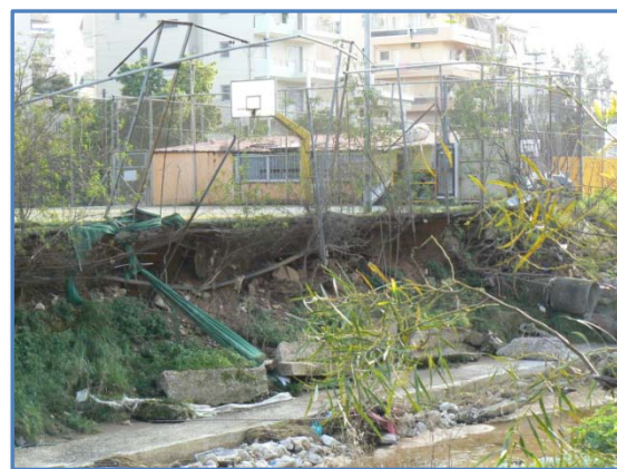
Εικόνες 34-35: Τα γήπεδα μπάσκετ ανάντη της πεζογέφυρας Περικλέους, που υπέστησαν σοβαρές καθιζήσεις από το επεισόδιο της 22/02/2013 (Πηγή: ίδια).
