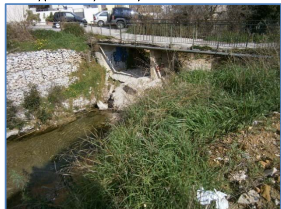
Εικόνες 58-59: Η πεζογέφυρα Ευρυτανίας, τα μεσόβαθρα στήριξής της και τα συρματοκιβώτια κατάντη (Πηγή: ίδια).
