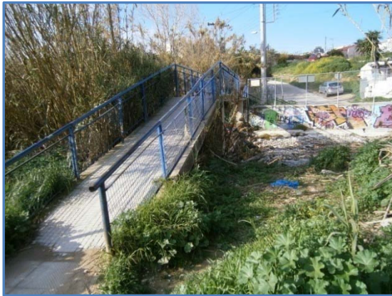
Εικόνες 44-45: Η πεζογέφυρα Ασυρμάτου με συγκέντρωση καλαμιών στα μεσόβαθρα στήριξής της (Πηγή: ίδια).
