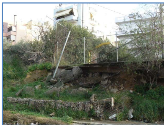
Εικόνες 34-35: Τα γήπεδα μπάσκετ ανάντη της πεζογέφυρας Περικλέους, που υπέστησαν σοβαρές καθιζήσεις από το επεισόδιο της 22/02/2013 (Πηγή: ίδια).
