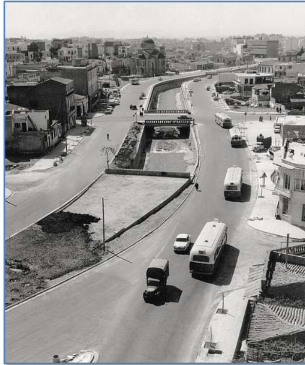
Εικόνα 6: Η οδός Καλλιρόης τη δεκαετία του 1960, πριν την ολοκληρωτική κάλυψη του Ιλισσού (Πηγή: www.flickr.com ).
