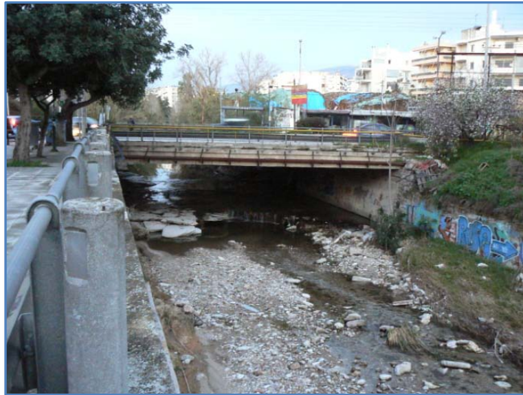
Εικόνα 28: Οι διαβρώσεις του πυθμένα κατάντη της Λεωφ. Αμφιθέας (Πηγή: ίδια).
