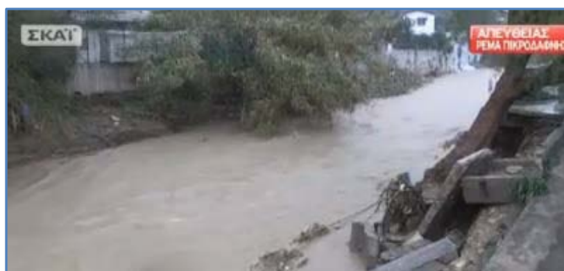
Εικόνα 17: Κατάρρευση πρανών στις όχθες του ρέματος (Πηγή: http://zeidoron.blogspot.gr )
