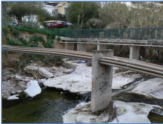
Εικόνες 24-25: Η πεζογέφυρα Κορύζη από κατάντη, με λεπτομέρεια από πιασμένα δέντρα και καλάμια στα μεσόβαθρα στήριξής της (1 χρόνο περίπου μετά το πλημμυρικό γεγονός της 22-02-2013) (Πηγή: ίδια).
