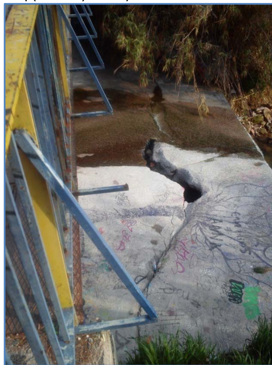
Εικόνες 39-40: Η οδογέφυρα Κουντουριώτη και οι διαβρώσεις του πυθμένα του ρέματος κατάντη (Πηγή: ίδια).
