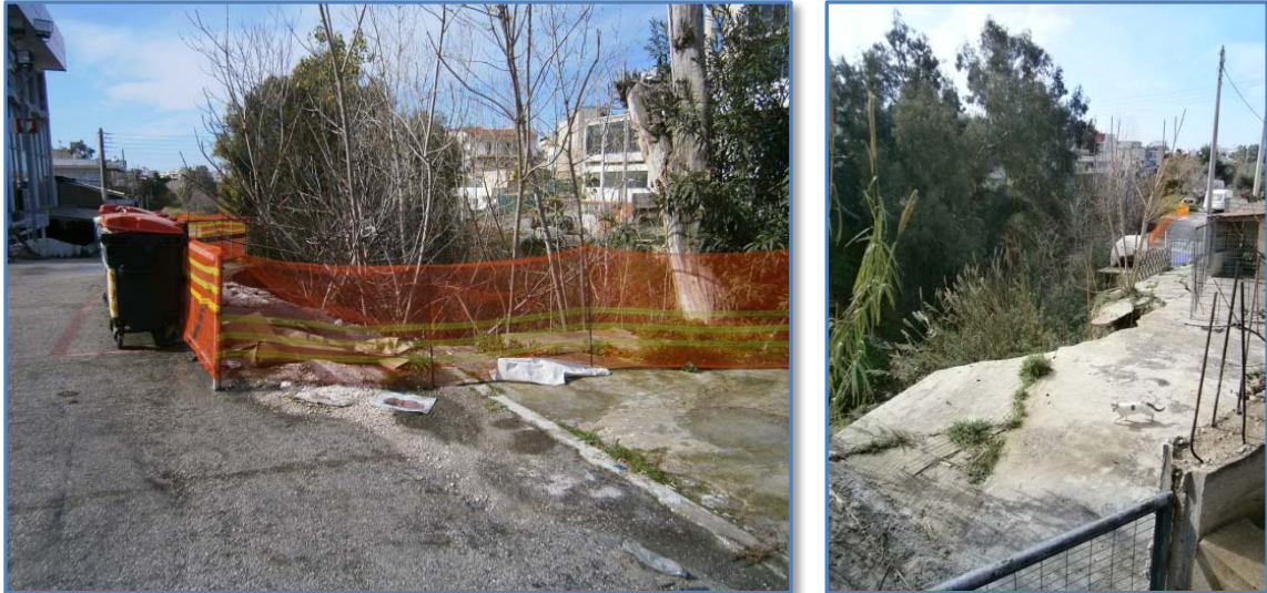
Εικόνες 70-71:Κατολίσθηση πρανούς κατάντη της Λεωφ. Βουλιαγμένης (αριστερά και δεξιά) (Πηγή: ίδια).
