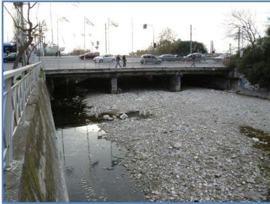
Εικόνες 22-23: Το ρέμα ανάντη της Λεωφ. Ποσειδώνος και τα μεσόβαθρα στήριξης (Πηγή: ίδια).
