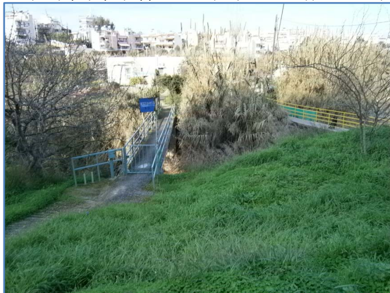
Εικόνα 43: Οι ιδιωτικές μεταλλικές πεζογέφυρες Αρματολών (Πηγή: ίδια).
