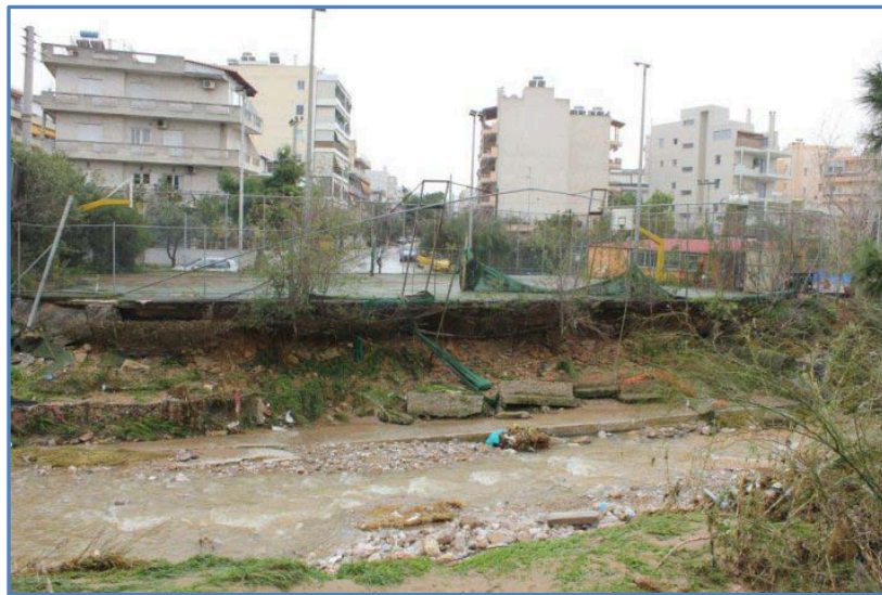
Εικόνα 20: Η καθίζηση του γηπέδου μπάσκετ, μετά το πλημμυρικό επεισόδιο (Πηγή: http://geitoniamou.gr )
