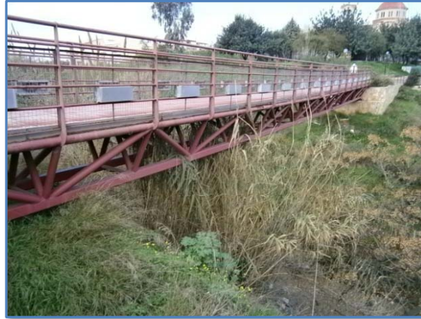
Εικόνα 64: Η μεταλλική πεζογέφυρα Διαγόρα από ανάντη (Πηγή: ίδια).
