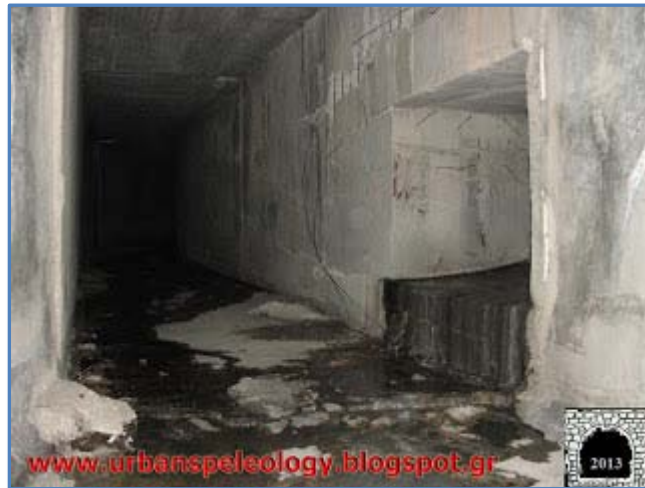
Εικόνα 10: Υπόγειο τμήμα του ρέματος, διευθετημένο σε κλειστό αγωγό (Πηγή: http://urbanspeleology.blogspot.gr ).
