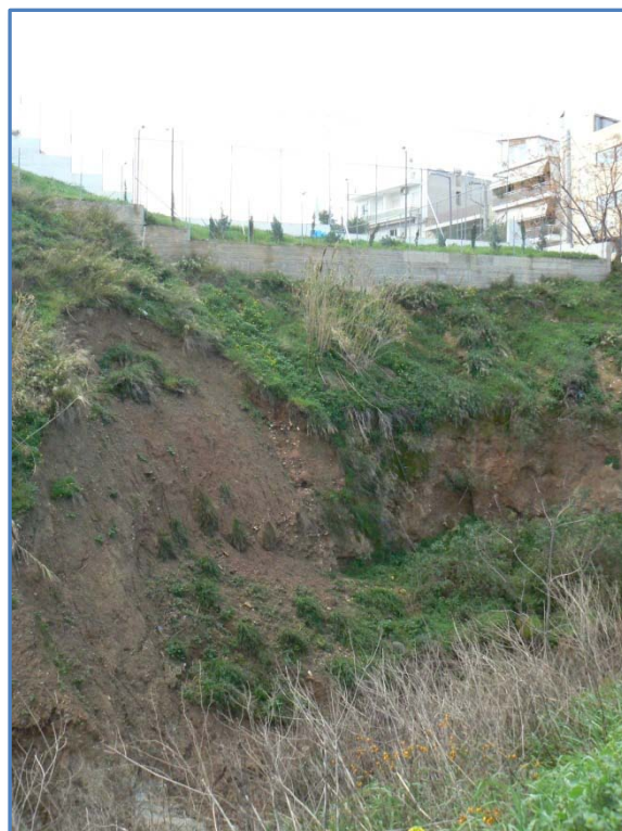
Εικόνα 69: Το μεγαλύτερο ύψος πρηνούς (20m) στη ΧΘ 4300 (ακριβώς πάνω σε αυτό βρίσκεται χτισμένο σχολικό συγκρότημα) (Πηγή: ίδια).
