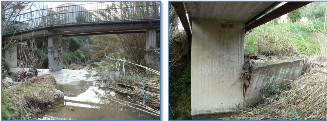
Εικόνες 65-66: Η πεζογέφυρα Αιγαίου από ανάντη προς κατόντη και ο ασταθής τοίχος αντιστήριξης στα δεξιά (Πηγή: ίδια).
