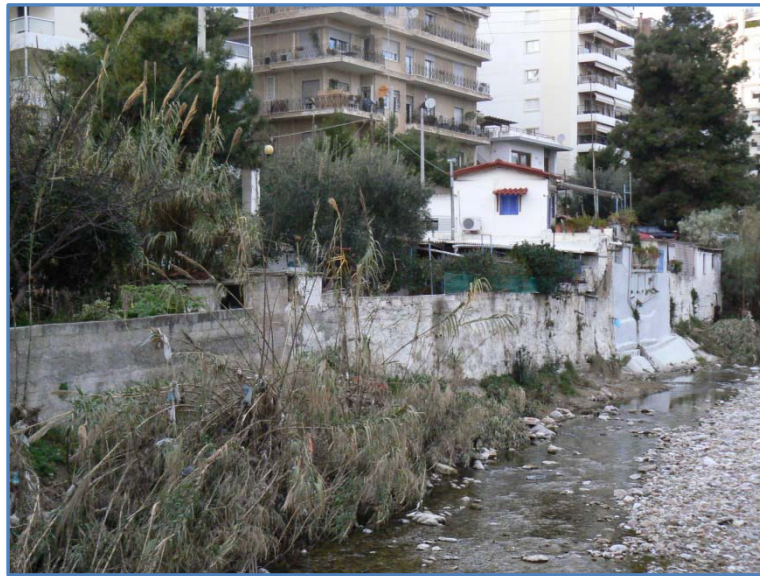
Εικόνα 33: Οι αυθαίρετες κατασκευές κατάντη δεξιά της πεζογέφυρας Κορούζη (Πηγή: ίδια).
