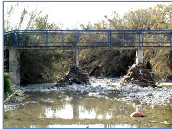
Εικόνες 44-45: Η πεζογέφυρα Ασυρμάτου με συγκέντρωση καλαμιών στα μεσόβαθρα στήριξής της (Πηγή: ίδια).
