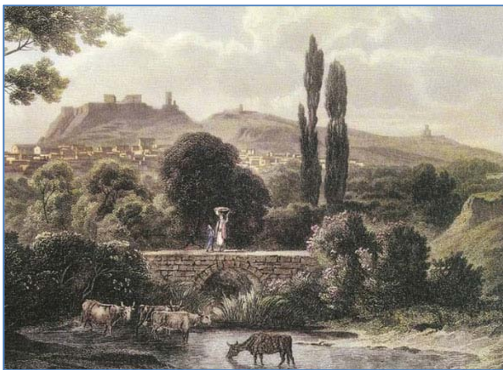
Εικόνα 9: Γέφυρα επί του ρέματος του Κυκλοβόρου στη θέση της σημερινής πλατείας Μεταξουργείου, A. Loeffler, 1871. (Πηγή: http://picasaweb.google.com ).
