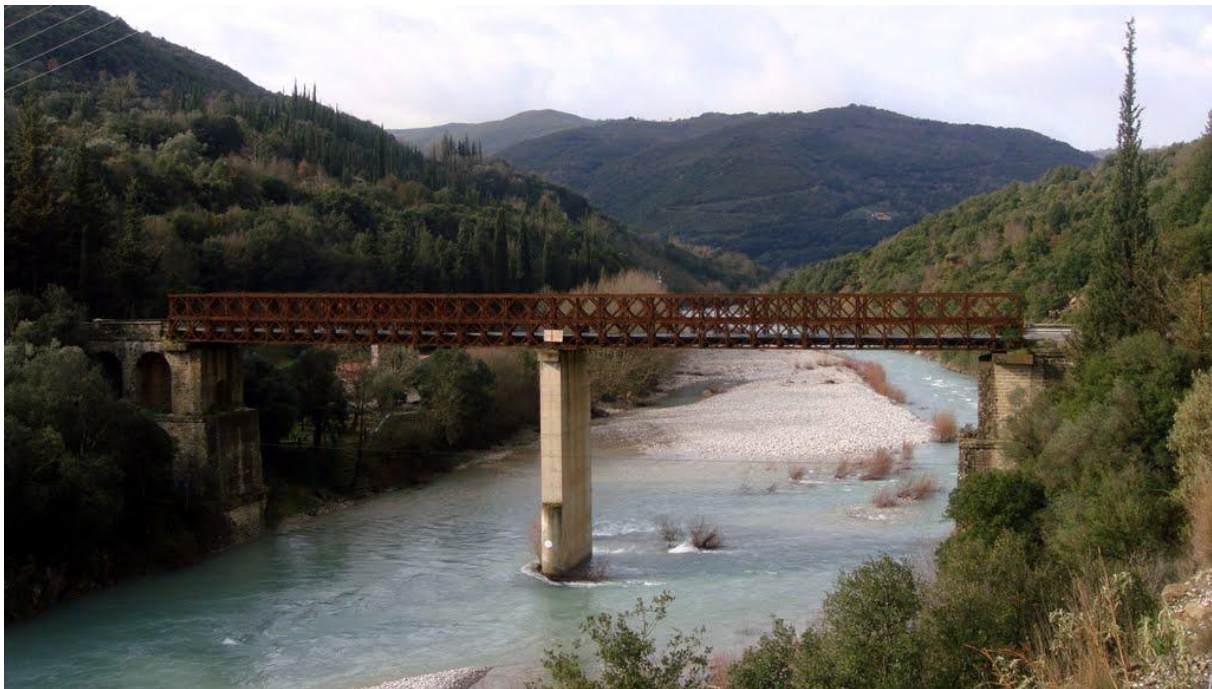
Σχήμα 5.7: Γέφυρα Μπανιά (Πηγή:www.panoramio.com).
