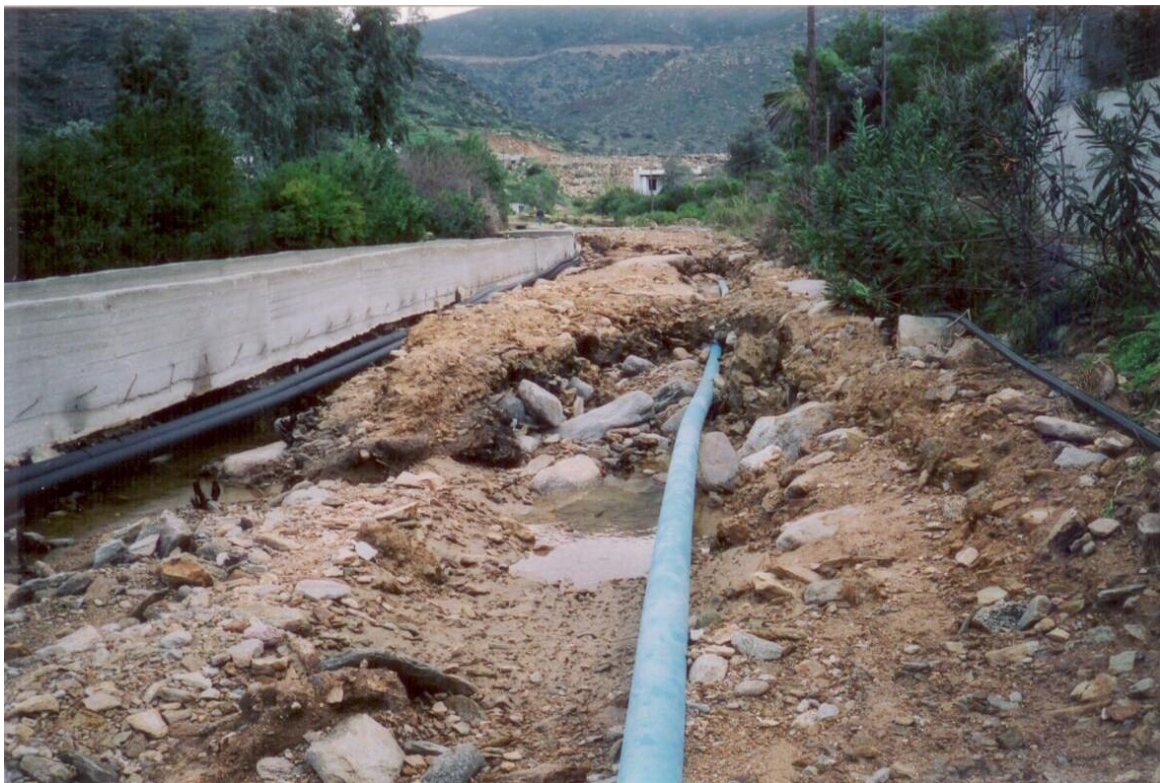
Σχήμα 5 : Διάβρωση στην οδό παραλίας-έργου, 29-01-2003 [8]
