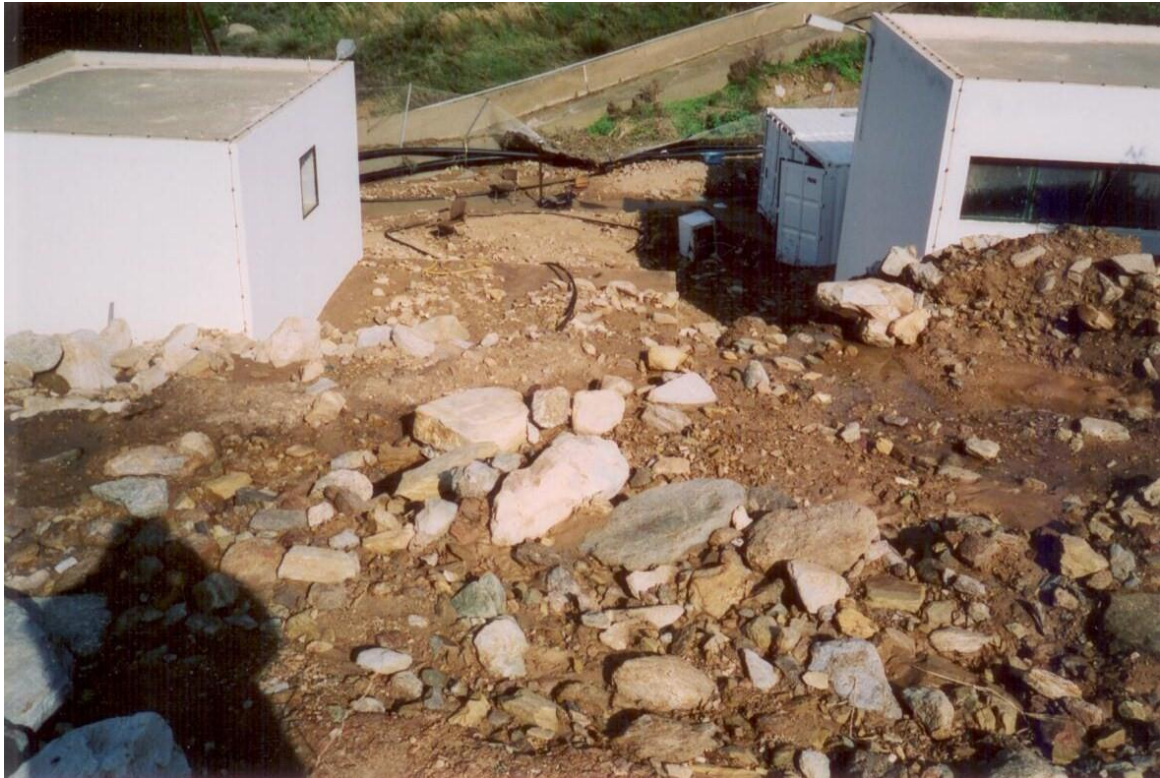
Σχήμα 4 : Επιχωματώσεις στην περιοχή γύρω από το θάλαμο των δικλίδων, 29-01-2003 [8]
