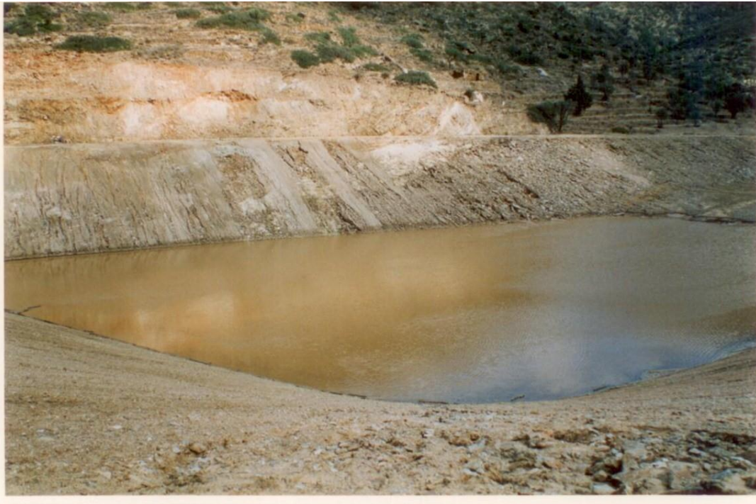
Σχήμα 34 : Διάβρωση υποστρώματος μεμβράνης στη φάση κατασκευής λόγω αστοχίας του συστήματος εκτροπής [24]
