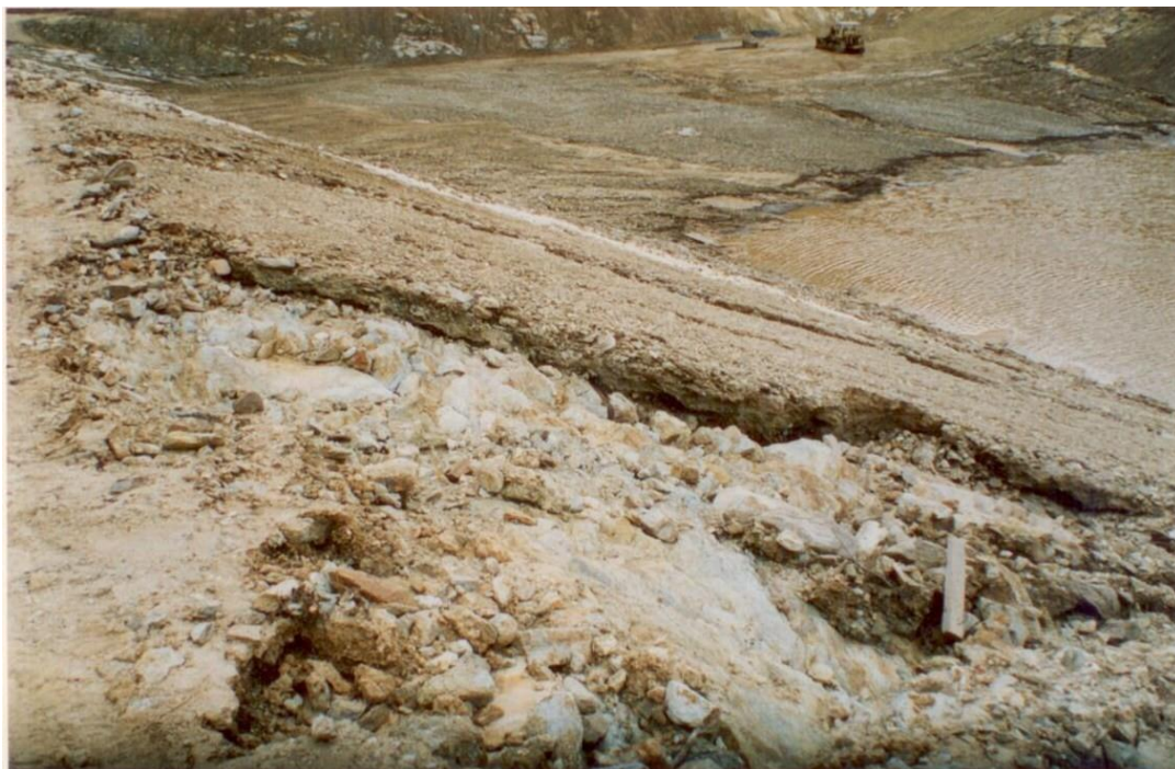
Σχήμα 35 : Διάβρωση υποστρώματος μεμβράνης στη φάση κατασκευής λόγω αστοχίας του συστήματος εκτροπής [24]
