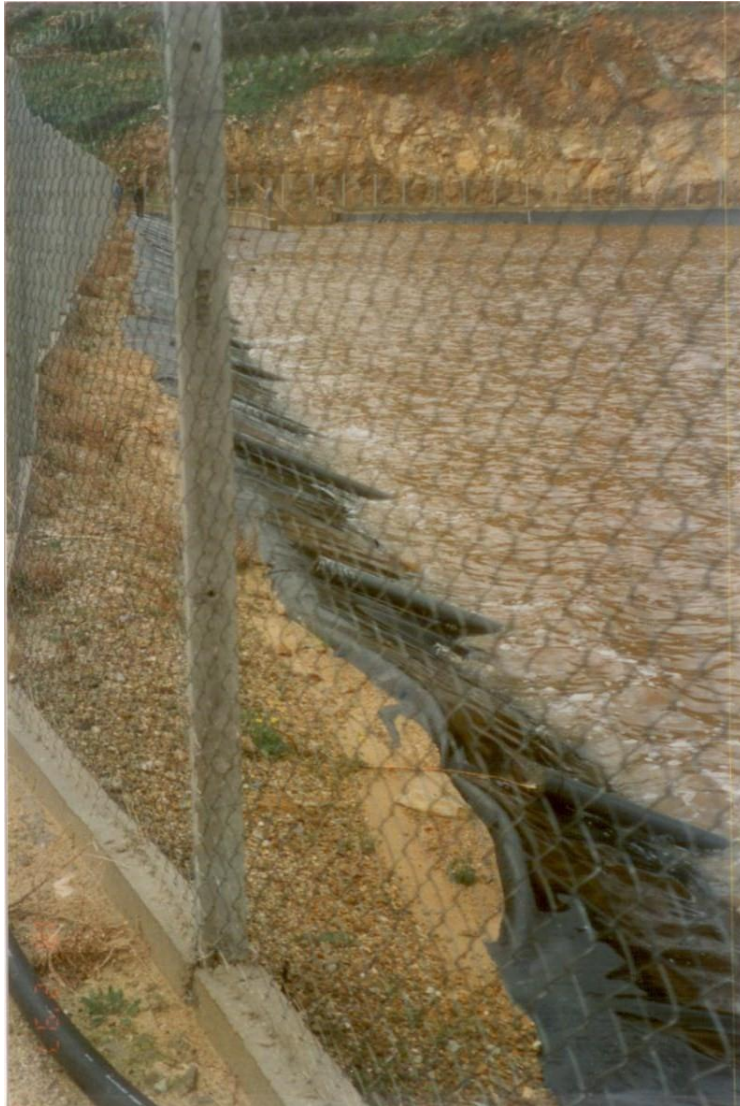
Σχήμα 30 : Λειτουργία του ταμιευτήρα με τη στάθμη του νερού ελάχιστα πιο χαμηλά από τη στέψη του φράγματος στις 18-02-1997 [24]
