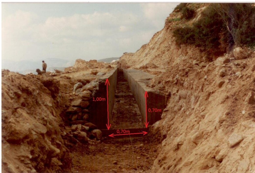
Σχήμα 31 : Διώρυγα εκτροπής δεξιού χείμαρρου - φάση κατασκευής - Δεκέμβριος 1993 [24]
