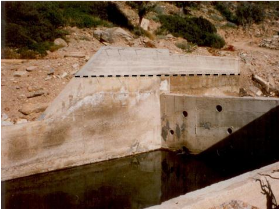
Σχήμα 36 : Αύξηση ύψους πλευρικών τοιχίων στη χαλικοπαγίδα του δεξιού χειμάρρου [24]
