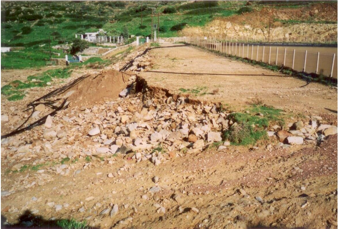
Σχήμα 2 : Αποψη στέψης του φράγματος, 29-01-2003 [8]
