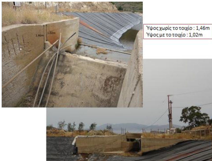
Σχήμα 13 : Μετρήσεις πάνω στο δεξί καθοδηγητικό τοιχίο του υπερχειλιστή / Άποψη του υπερχειλιστή από τα ανάντη
