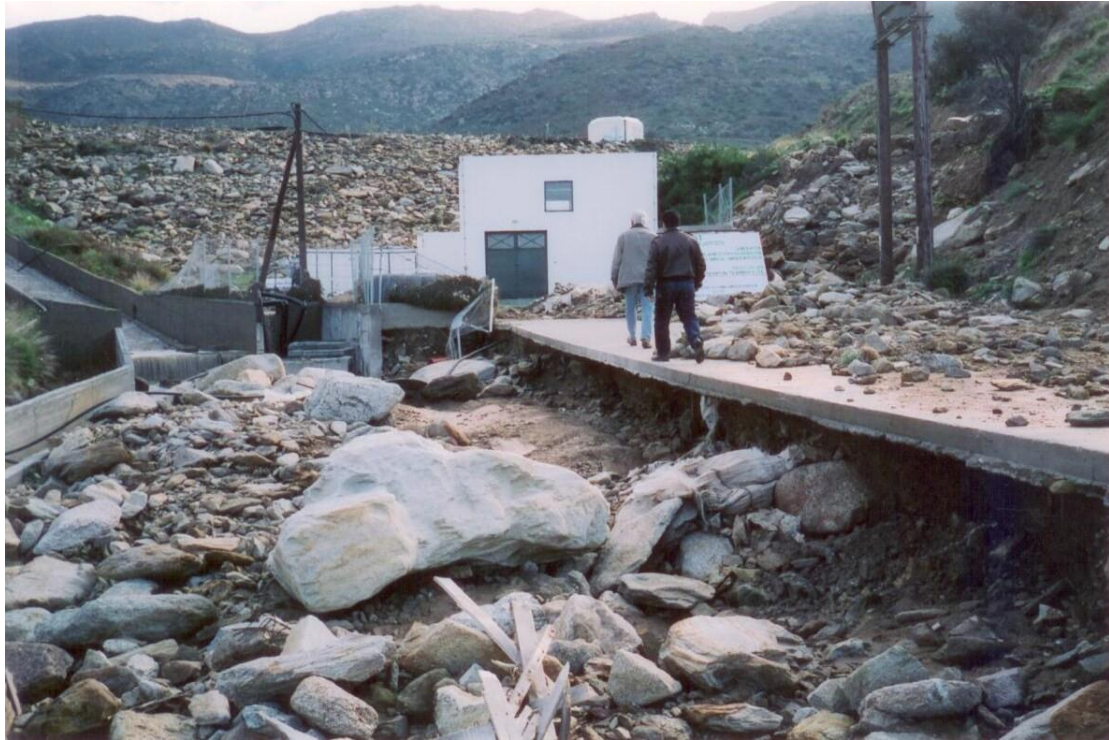
Σχήμα 6 : Διάβρωση θεμελίωσης οδού που οδηγεί στο θάλαμο δικλίδων, 29-01-2003 [8]
