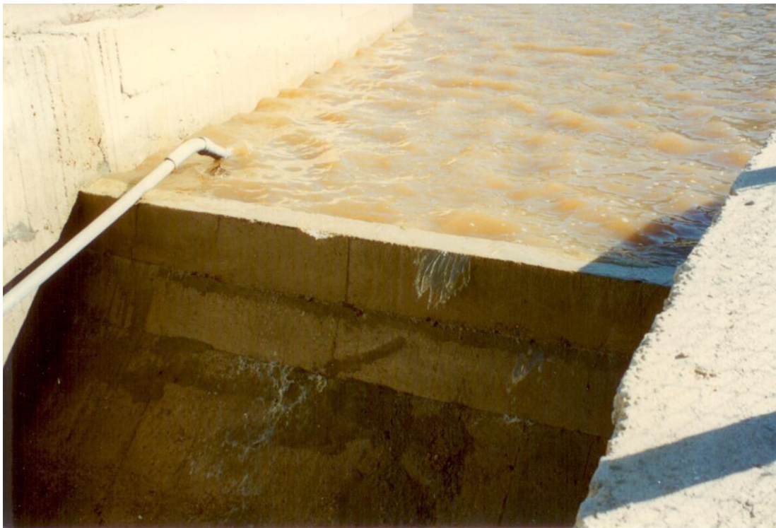
Σχήμα 28 : Τοιχίο πάνω στη στέψη του υπερχειλιστή [24]
