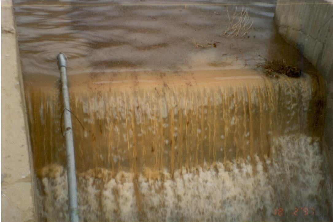
Σχήμα 29 : Λειτουργία του υπερχειλιστή μαζί με το πρόσθετο τοίχιο στις 18-02-1997 [24]
