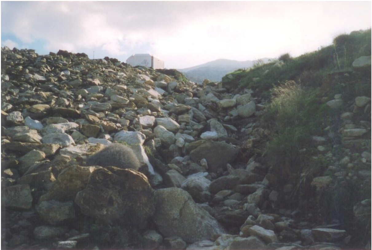
Σχήμα 3 : Διάβρωση στην επαφή του αριστερού αντερείσματος, 29-01-2003 [8]
