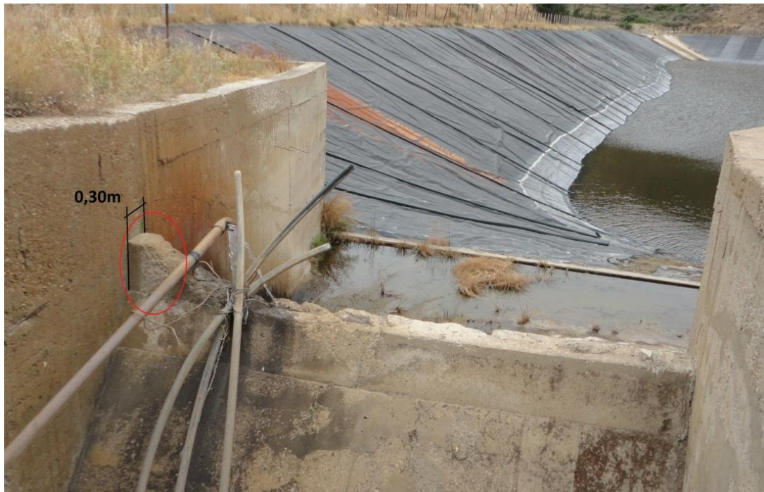
Σχήμα 27 : Στέψη του υπερχειλιστή (έτος 2014)
