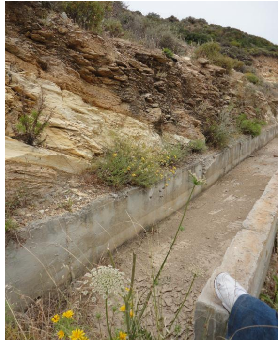
Σχήμα 33 : Διώρυγα εκτροπής αριστερού χειμάρρου - Μάιος 2014 [24]
