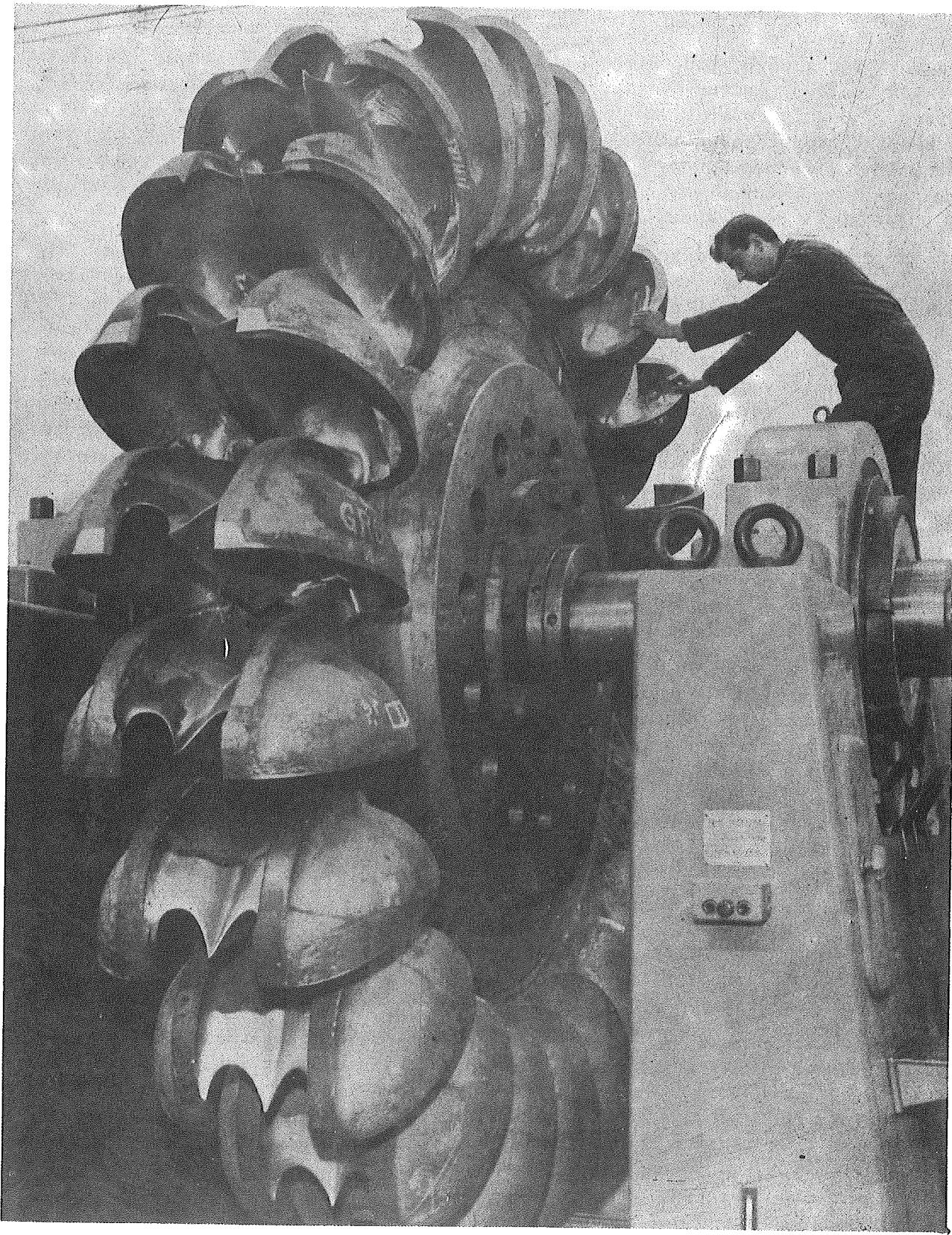
**Σχ. 6-14** Δρομεύς δρασεως (τύπου Pelton), μετά κατακορύφου άτρακτου κατ' 4 άκροφυσιών, της ύδροδυναμικής έγκαταστάσεως Grossio στην Ιταλία, έγκατεστημένης το σχήματος 144.000 HP,  $H = 600 \text{ m}$ ,  $Q = 20,35 \text{ m}^3/\text{sec}$ ,  $n = 333,3 \text{ rpm}$  κατ' έτους 1963.
