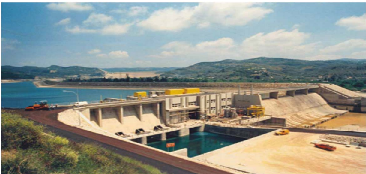
Σχήμα 2.6: Φράγμα Πουρναρίου II
