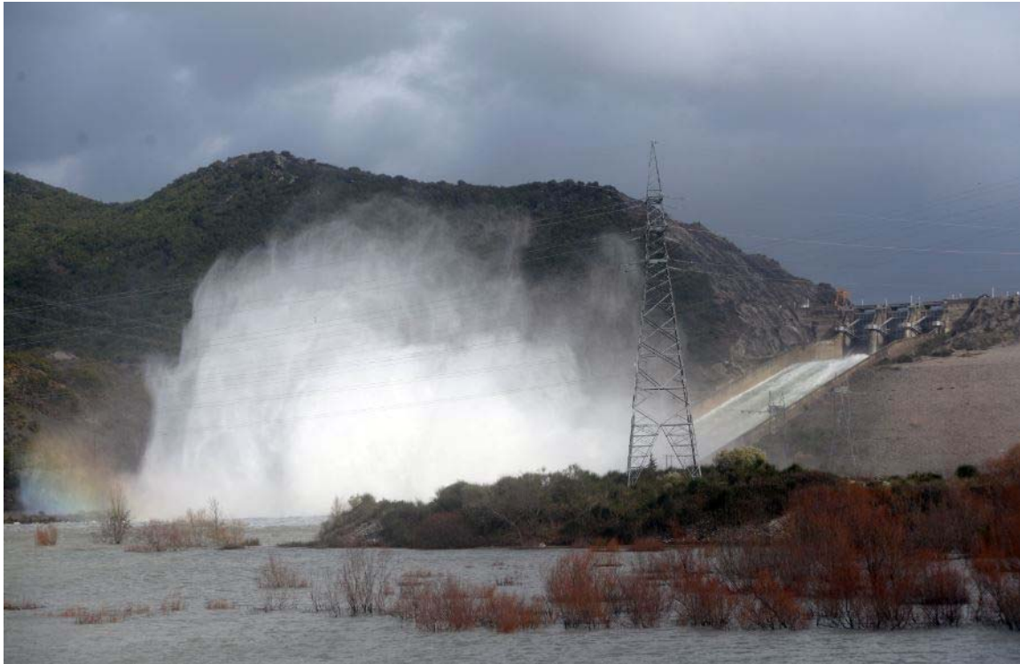
Σχήμα 6.6: Εκροή από τον εκχειλιστή του φράγματος (Πηγή: http://www.parapolitika.gr/parapolitikablog )
