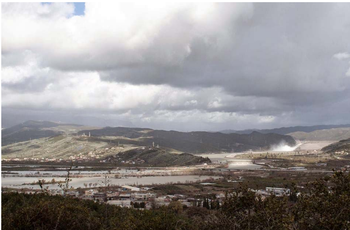
Σχήμα 6.5: Εκροή από τον εκχειλιστή του φράγματος (Πηγή: http://www.radiogamma.gr )
