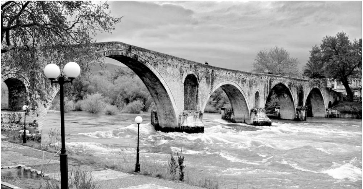
Σχήμα 2.3: Ροή του Αράχθου στο σημείο της Γέφυρας της Άρτας
