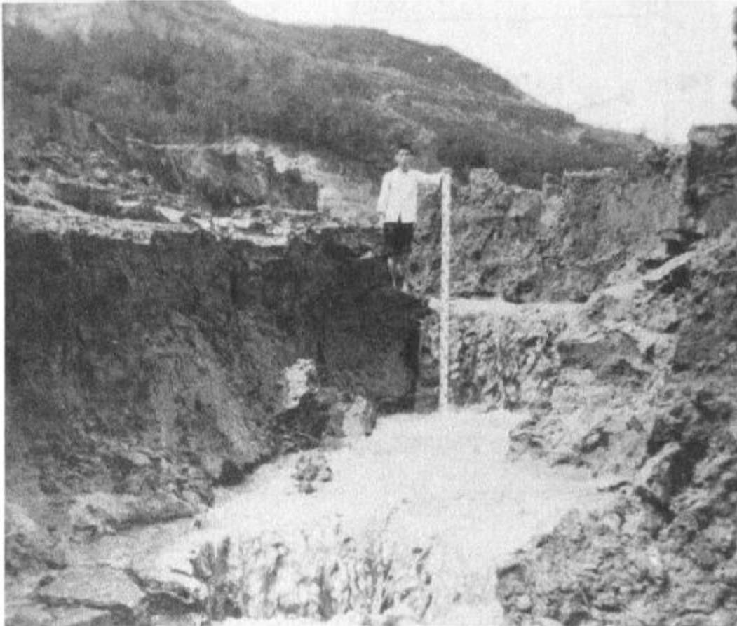
Εικόνα 3.14 Σημείο απότομης αλλαγής κλίσης παλινδρομικής διάβρωσης, ταμιευτήρας Heisonglin, της Κίνας (Morris and Fan, 1998).
