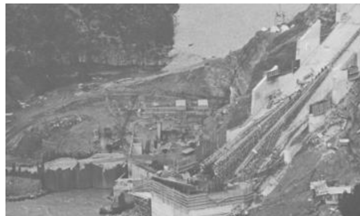
Φράγμα Κρεμαστών: Κατάκλυση του σταθμού παραγωγής λόγω υπερπήδησης του κατάντη προφράγματος (Νοέ. 1964) και αποκατάσταση με πασσαλοσανίδες (Μουτάφης, 2008)
