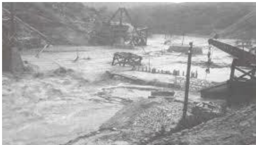
Φράγμα Μαραθώνα: Υπερπήδηση προφράγματος και κατάκλυση περιοχής θεμελίωσης φράγματος (αρχείο ΕΥΔΑΠ)
