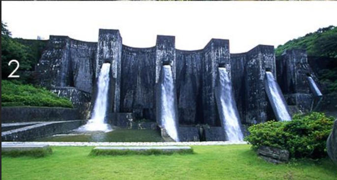
2 Όνομα: Hōnen'ike Χώρα: Ιαπωνία Τύπος: Αντηριδωτό φράγμα Ύψος: 32 Έτος ολοκλήρωσης: 1930
