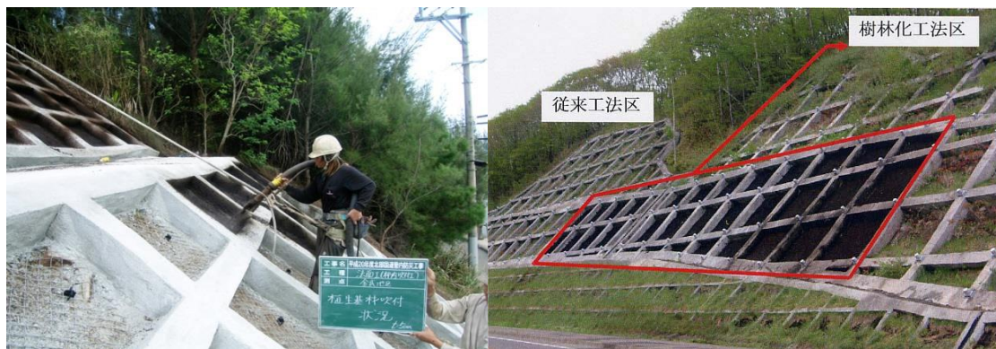
Εικόνα 4.21 Φωτογραφίες από τη διαδικασία πλήρωσης και το τελικό αποτέλεσμα.
