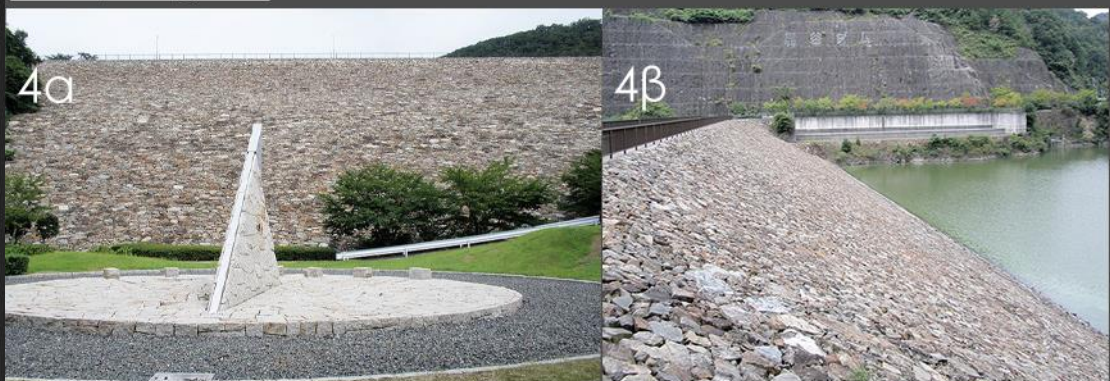
Όνομα: Κυροτανί, Χώρα: Ιαπωνία, Τύπος: Λιθόρριπτο φράγμα, Ύψος: 43,6m, Έτος ολοκλήρωσης: 1990
