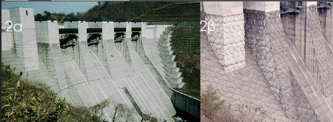
2α Όνομα: Μίχαρι, Χώρα: Ιαπωνία, Τύπος: Φράγμα βαρύτητας σκυροδέματος, Ύψος: 65m, Έτος ολοκλήρωσης: 1997
