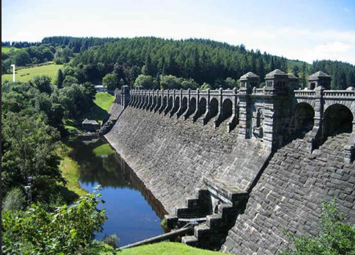
Όνομα: Υγνιwy Χώρα: Wales Τύπος: Φράγμα λιθοδομής Ύψος: 44m Έτος ολοκλήρωσης: 1888
