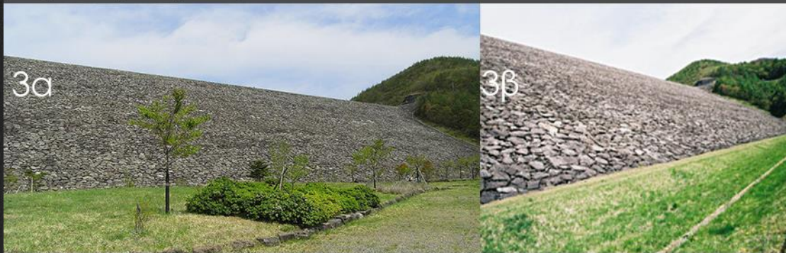
Όνομα: Κυρίγιαμα, Χώρα: Ιαπωνία, Τύπος: Λιθόρριπτο φράγμα, Ύψος: 97,5m, Έτος ολοκλήρωσης: 1985
