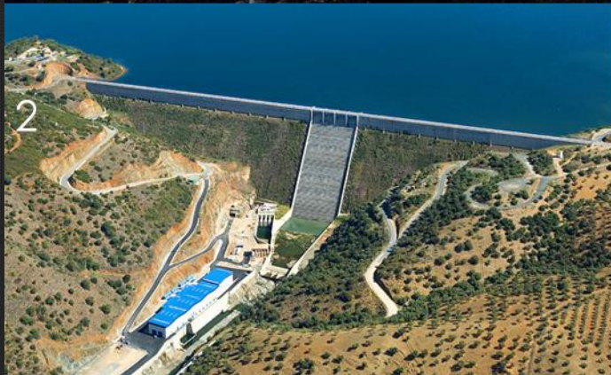
Όνομα: La Breña II Χώρα: Ισπανία Τύπος: Φράγμα βαρύτητας RCC Ύψος: 119m Έτος ολοκλήρωσης: 2007
