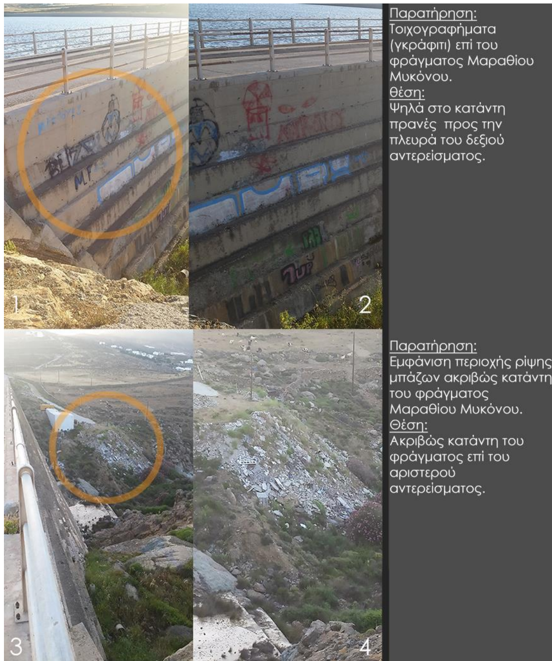
Εικόνα 6.3 Φωτογραφίες σχετικές με τις παρατηρήσεις για την αισθητική εικόνα του φράγματος Μαραθίου Μυκόνου (πηγές φωτογραφιών: φωτογραφίες του συντάκτη της εργασίας).
