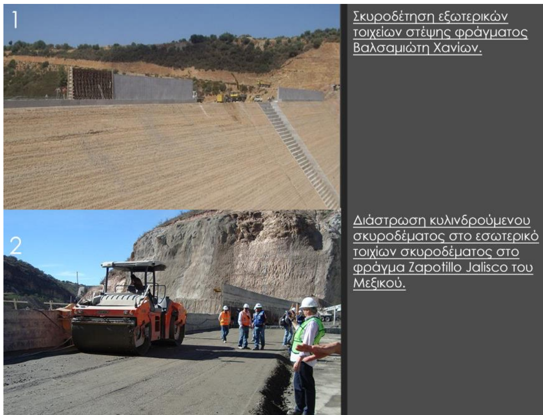
Εικόνα 11.28 Φωτογραφίες από την κατασκευή της στέψης φραγμάτων ΑΚΣΕ και RCC με τοίχια οπλισμένου σκυροδέματος (πηγές φωτογραφιών κατά σειρά: (Ζαχαρόπουλος, 2014), www. blog.360gradosenconcreto.com ) .
