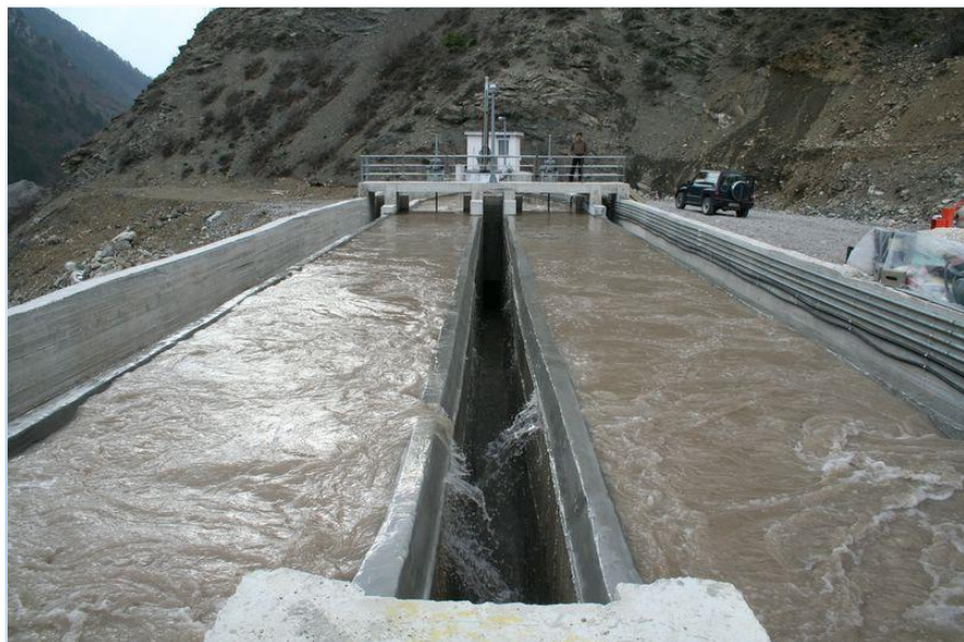
Εικόνα 2.5 Δεξαμενές εξάμμοσης (Πηγή: Μαμάσης κ.α., Μικρά Υδροηλεκτρικά Έργα, 2015)
