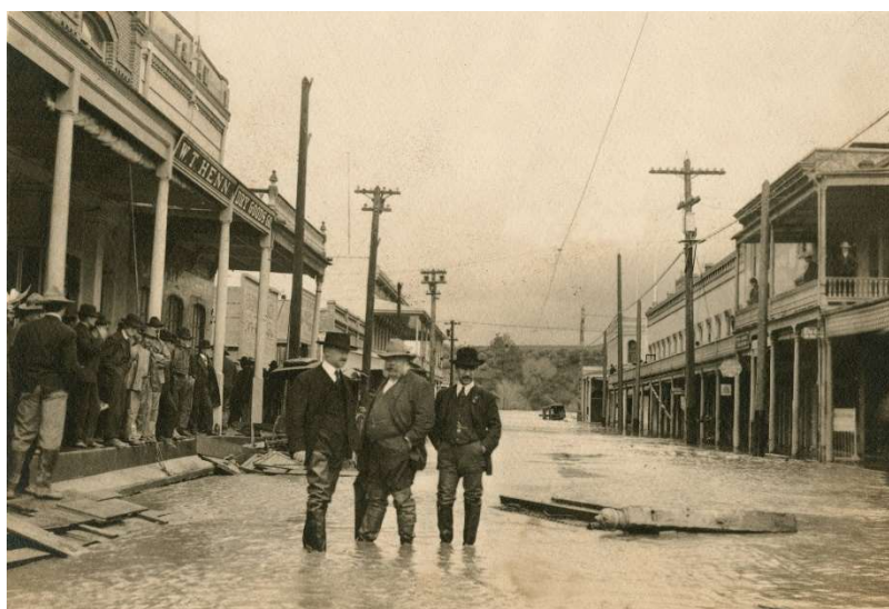
Εικόνα 1. Ζημιές στην πόλη του Oroville μετά την πλημμύρα του Μάρτιου 1907.
