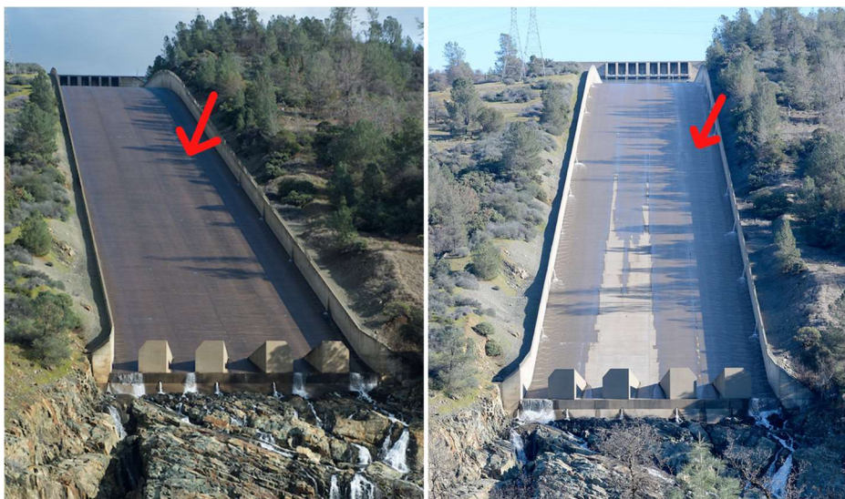
Εικόνα 8. Φωτογραφίες του αγωγού του κύριου υπερχειλιστή του φράγματος Oroville. Η αριστερή λήφθηκε 11 Ιανουαρίου και η δεξιά 27 Ιανουαρίου. Δεξιά φαίνονται οι πρώτες ενδείξεις της ανασήκωσης των πλακών του πυθμένα.
