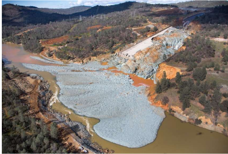
Εικόνα 7. Φεβρουάριος 27, 2017. Ζημιές στον κύριο υπερχειλιστή του φράγματος Oroville.
