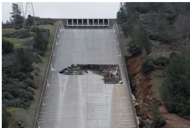
Εικόνα 3. Φεβρουάριος 6, 2017. Πρώτες ζημιές στον αγωγό του κύριου υπερχειλιστή.
