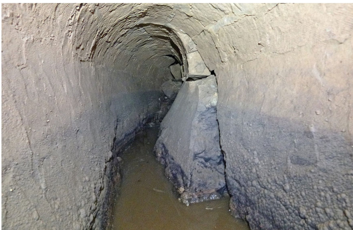
Εικόνα 9. Η διατομή της ανακατασκευασμένης σήραγγας και η πλευρική αστοχία της επένδυσης
