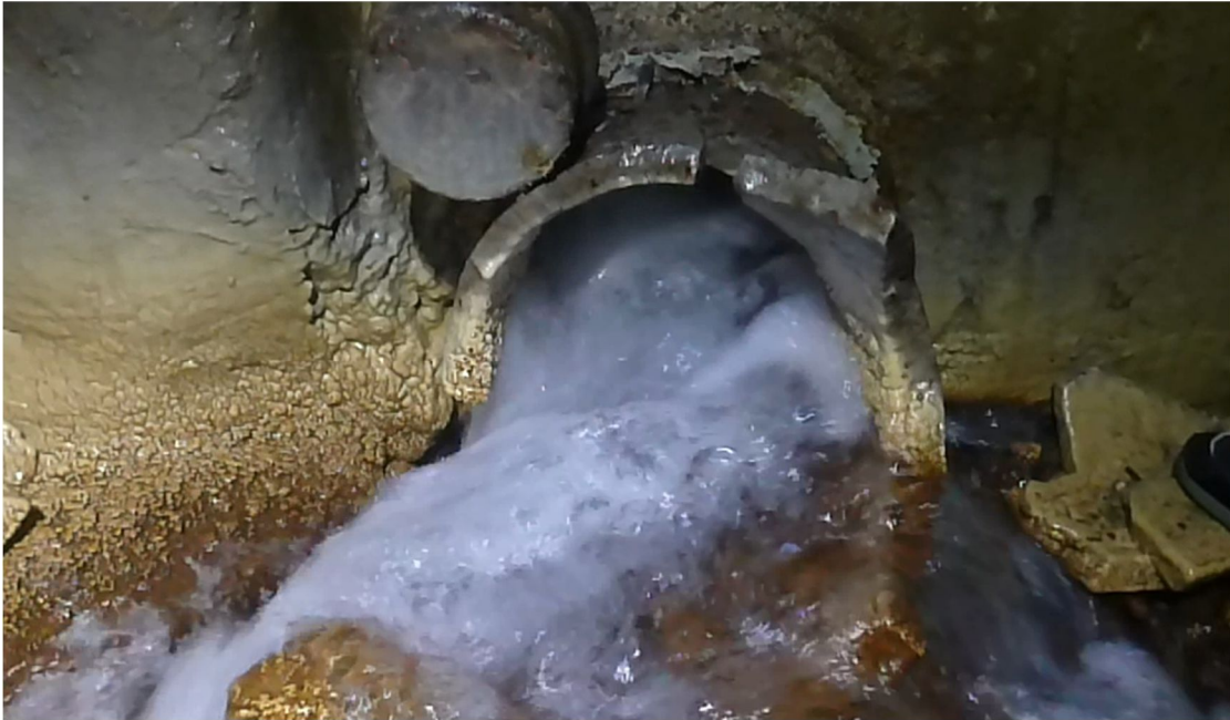
Εικόνα 12. Ο αγωγός Ø300 της Γλόκωνος σχεδόν πλήρης με 100% παροχή νερού από το Αδριάνειο
