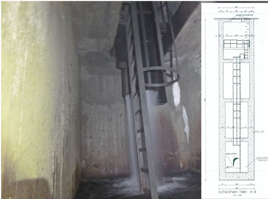
Εικόνα 11. Ο πυθμένας του φρέατος #18N κατάντη της σήραγγας Πανόρμου & αντίστοιχο σχέδιο (NAMA)
