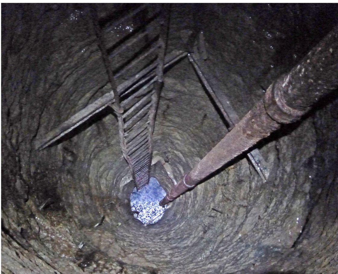
Εικόνα 27. Το φρέαρ #32 εντός υπογείου θαλάμου, το οποίο τροφοδοτούσε το Νοσοκομείο “Σωτηρία”
