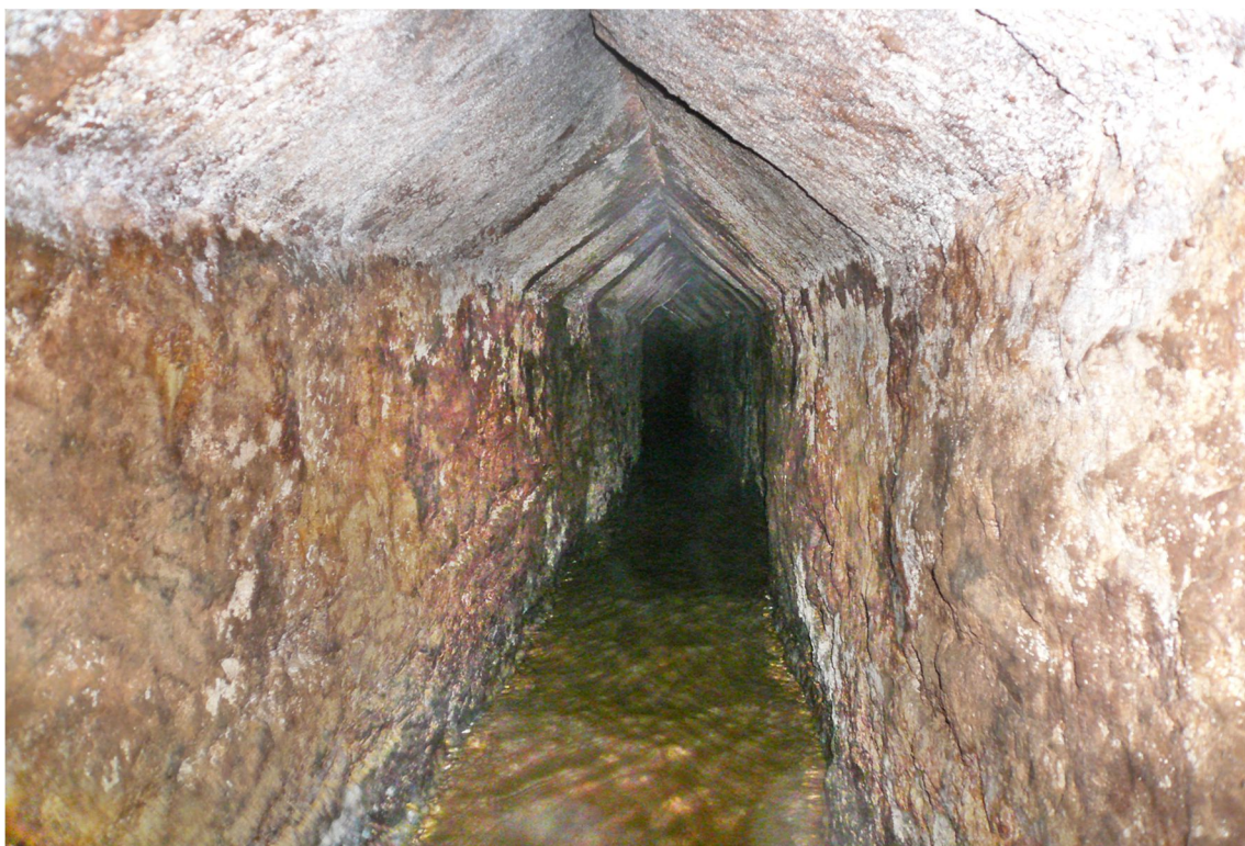
Εικόνα 24. Χαρακτηριστική διατομή (0.50 x 1.40 m) (φρέαρ #239) με κεραμικές πλάκες στην οροφή
