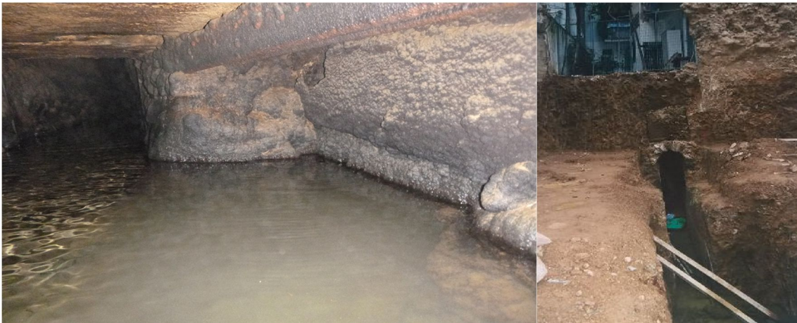
Εικόνα 28. Το κλειστό θυρόφραγμα στο φρέαρ #6 προς το υδραγωγείο εκκένωσης “Πυρρή” (στα δεξιά)
