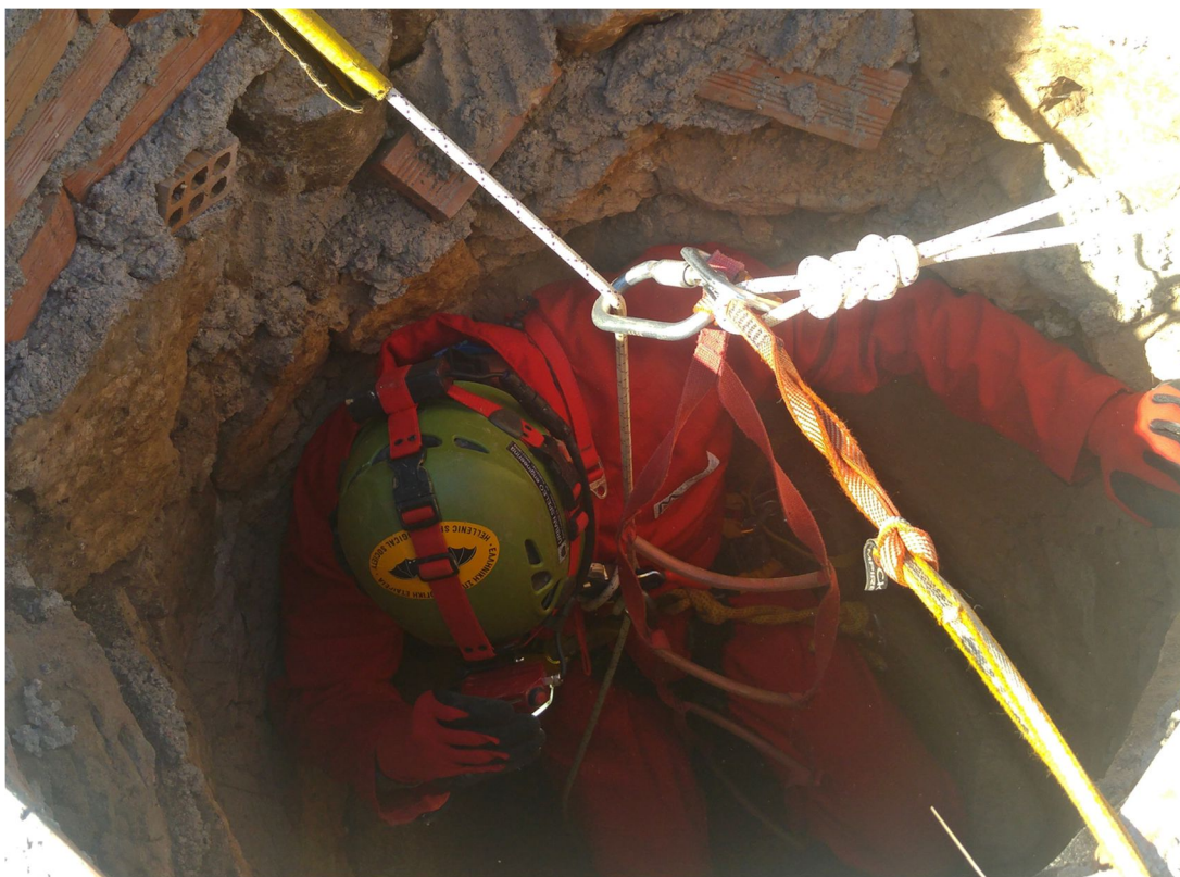
Εικόνα 2. Κατάβαση στο φρέαρ #235 σύμφωνα με τα απαιτούμενα μέτρα και εξοπλισμό ασφαλείας
