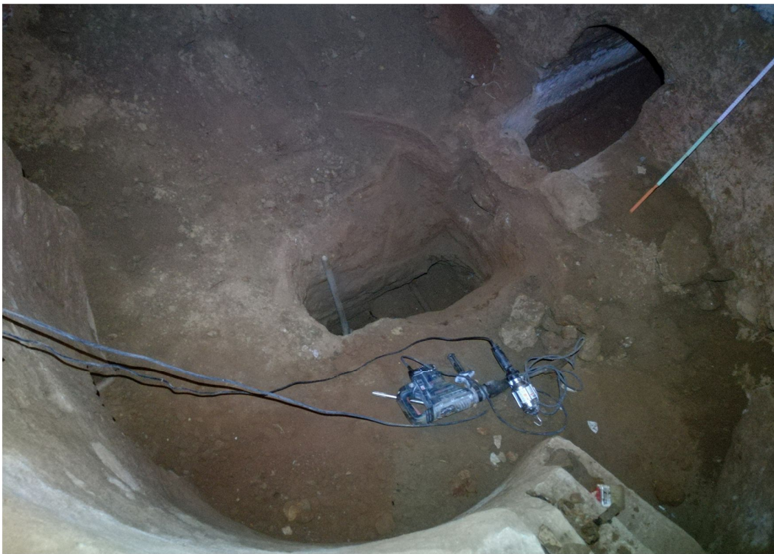
Εικόνα 15. Εσωτερικό θαλάμου, τομή στα φερτά της δεξαμενής, κλίμακα καθόδου, σήραγγες
