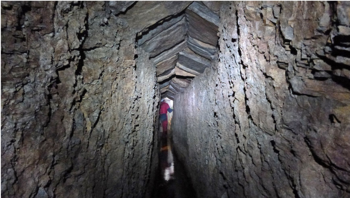
Εικόνα 5. Η σήραγγα του υδραγωγείου Π. Κυριακού κάτω από την Πανόρμου (διασταύρωση με Λ. Αλεξάνδρας)
