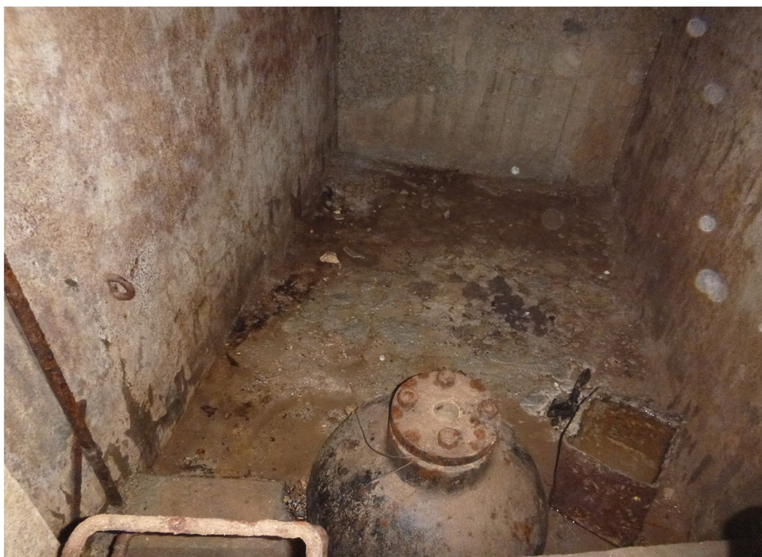
Εικόνα 8. Θάλαμος χειρισμού της κόφτρας προς το υδραγωγείο εκκένωσης (“Πυρρή”) στο φρέαρ #6
