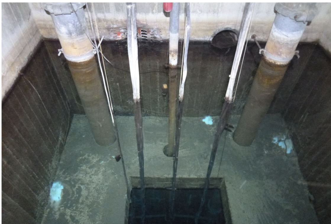
Εικόνα 14. Στάθμη ύδατος (βάθους 11.5 m, ΑΥΣ=154 m) στο φρέαρ #18AN, σε λειτουργία υπερχειλίσης
