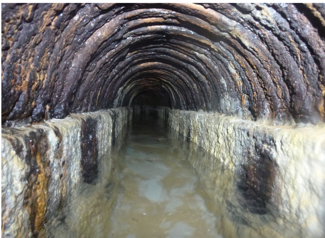
Εικόνα 22. Χαρακτηριστική διατομή (κτιστά τοιχώματα, τριμερές κεραμικό τόξο) μεταξύ φρεάτων #113-117
