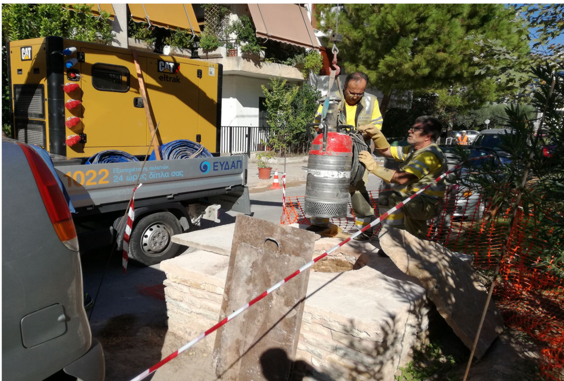
Εικόνα 18. Προετοιμασία άντλησης υδάτων (φρέαρ #103)
