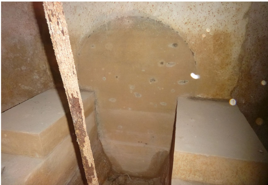
Εικόνα 29. Η κλειστή σύνδεση της σήραγγας.
