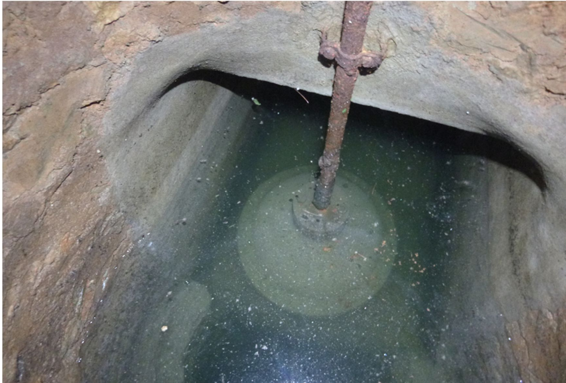
Εικόνα 19. Θάλαμος και κόφτρα στον πυθμένα του φρέατος #103Α (το κλειδί έφτανε μέχρι την επιφάνεια)
