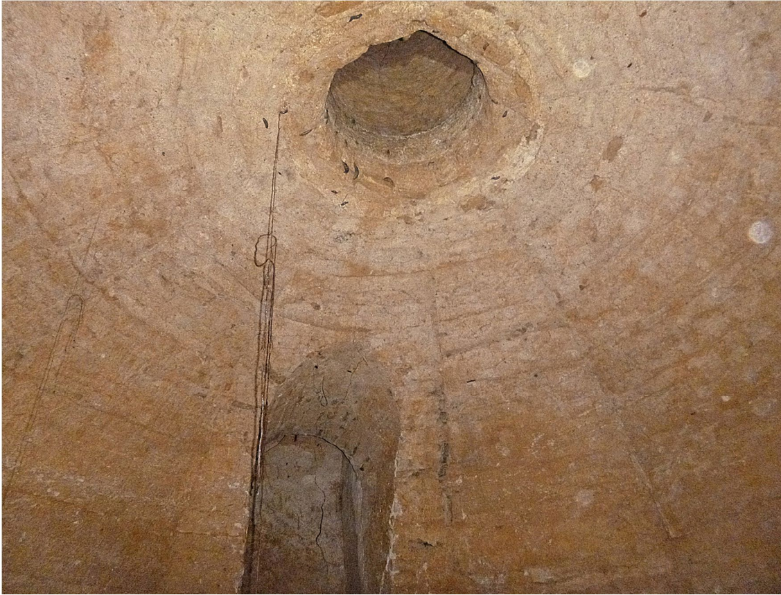
Εικόνα 16. Η κτιστή διαιρούμενη θόλος της αίθουσας, το στόμιο υδροληψίας και η είσοδος
