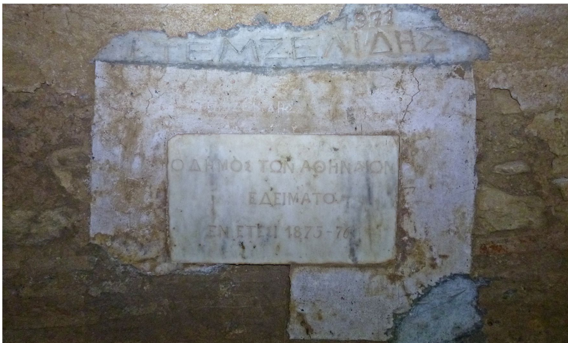
Εικόνα 17. Η μαρμάρινη επιγραφή, το λευκό κονίαμα της εποχής της, και η νεότερη επισκευή (1971)
