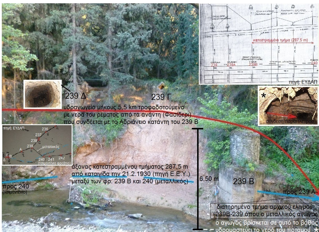
Εικόνα 25. Το ανάντη άκρο του κατεστραμμένου τμήματος στο πέρασμα από την κοίτη του Κηφισού
