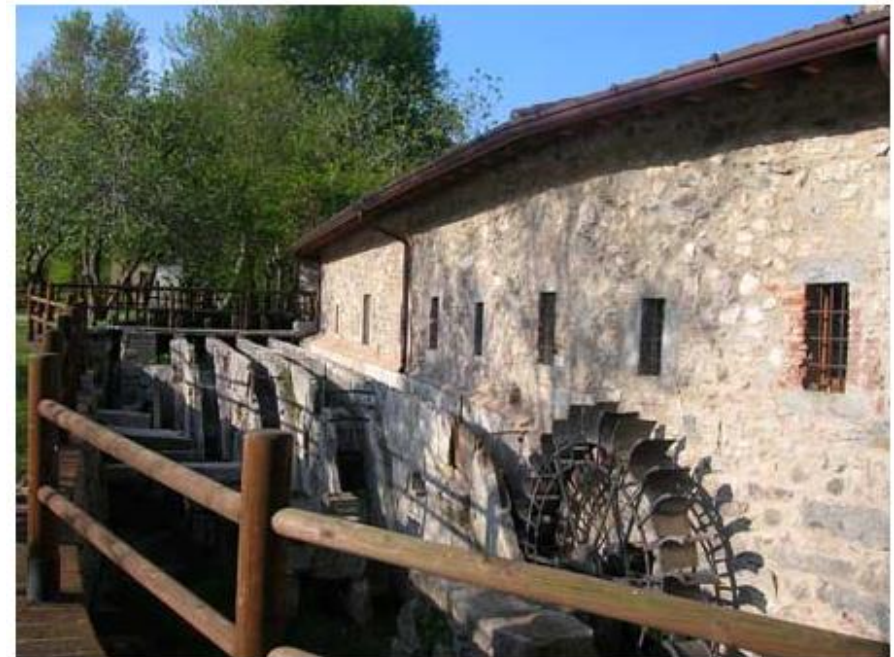
Οριζόντιος υδροτροχός
