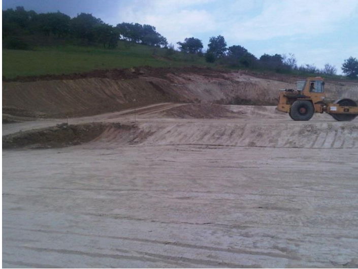
Καθαρισμός & διαμόρφωση περιβάλλοντος χώρου
