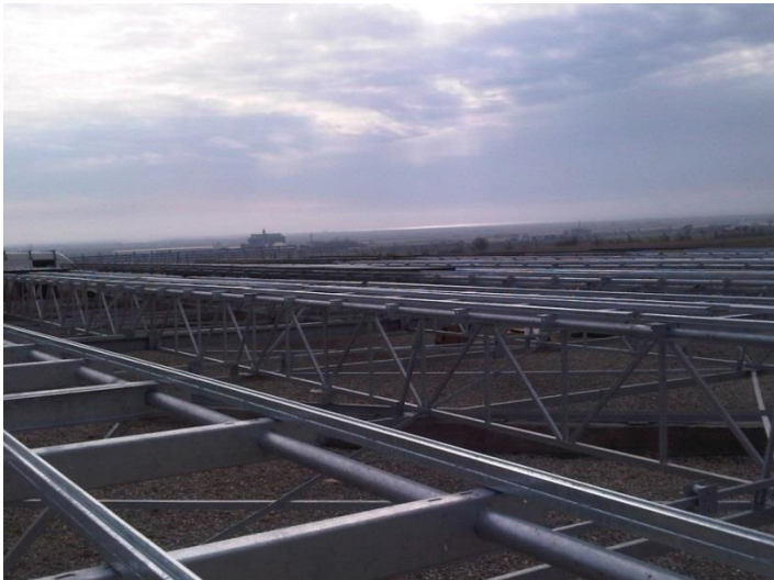
Συναρμολόγηση μεταλλικού σκελετού βάσεων
