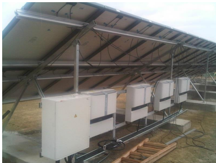
Σύνδεση ηλεκτρολογικού εξοπλισμού
