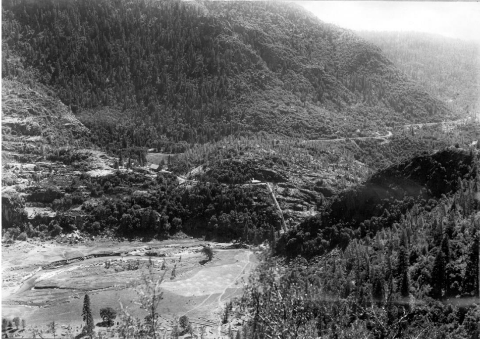
Εικόνα 2-5: Φωτογραφία από το εργοτάξιο του Hetch Hetchy Dam 1914 (πηγή: library.usgs.gov , ανάκτηση 2018)
