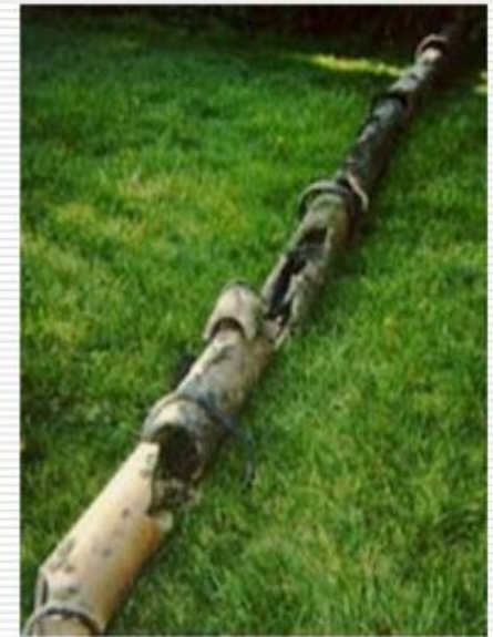
Διαβρωμένος αγωγός αποχέτευσης
