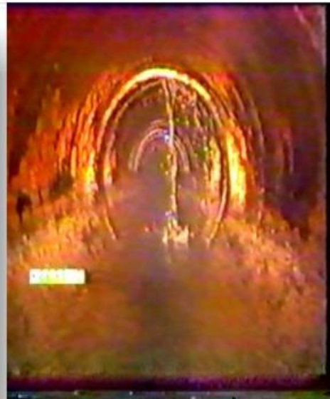
Αρμοί και ρωγμές σε αποχετευτικό αγωγό
