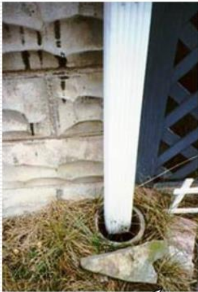
Παράνομη σύνδεση υδρορροής στο δίκτυο ακαθάρτων
