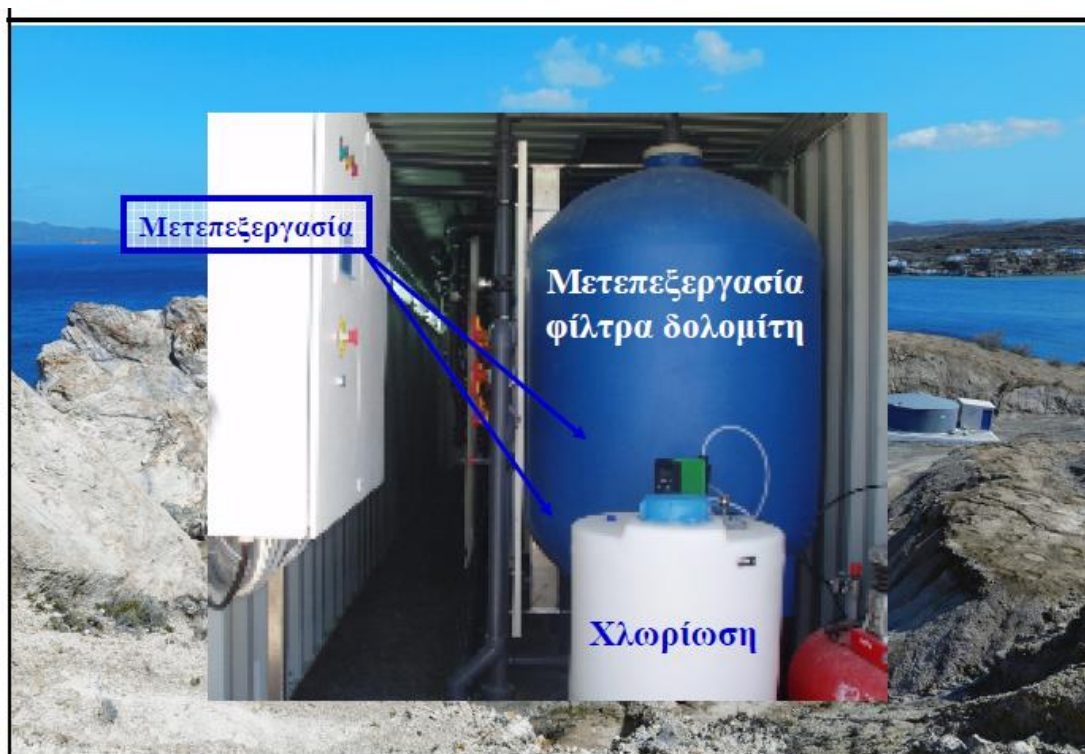
Εικόνα 3.13 Η μετεπεξεργασία του αφαλατωμένου νερού (Όμιλος ΙΤΑ, 2010).
