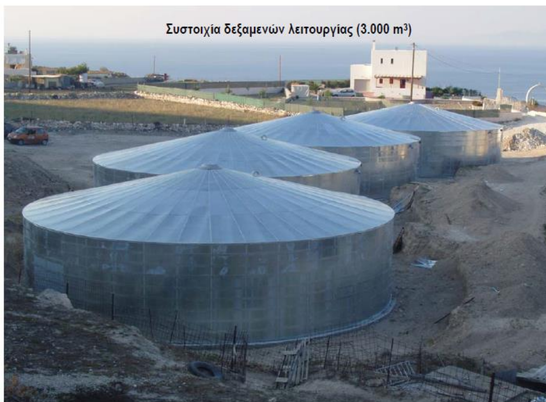
Εικόνα 3.15 Δεξαμενές αποθήκευσης νερού (Ομιλος ΙΤΑ, 2010).
