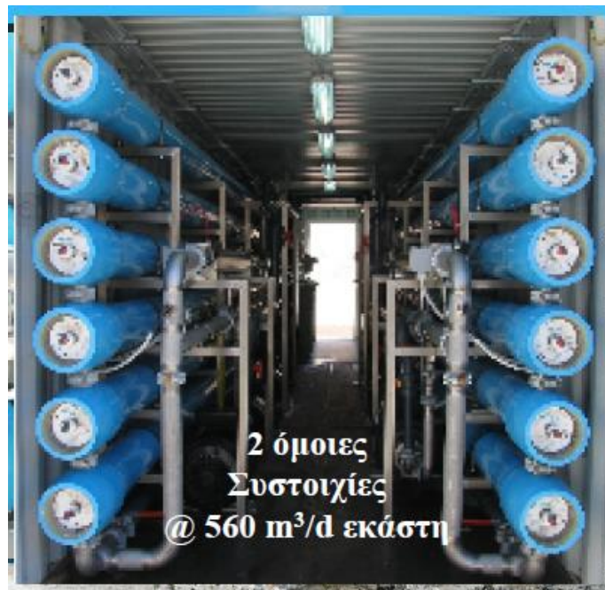
Εικόνα 3.12 Οι δύο συστοιχίες κάθε υπομονάδας αφαλάτωσης (Όμιλος ΙΤΑ, 2010).
