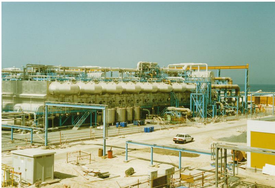
Εικόνα 2.1 Μονάδα αφαλάτωσης με τη μέθοδο MSF στο Ντουμπάι ( https://commons.wikimedia.org/ ).
