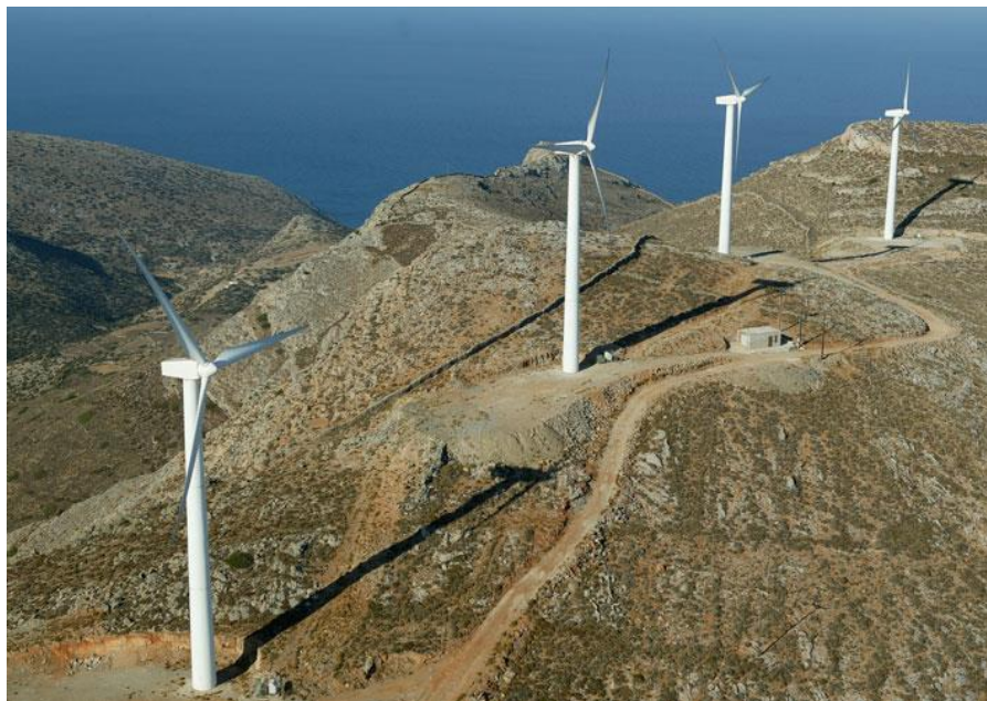
Εικόνα 2.7 Αιολικό πάρκο στη Σύρο ( https://ita-sa.gr/ ).
