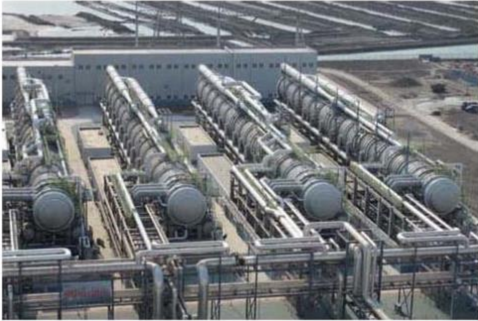
Εικόνα 2.2 Μονάδα αφαλάτωσης με τη μέθοδο MED στην Κίνα (Semiat, 2010).
