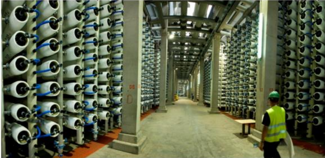
Εικόνα 2.4 Μονάδα αφαλάτωσης με τη μέθοδο RO στο Ισραήλ (Cohen-Tanugi, 2015).
