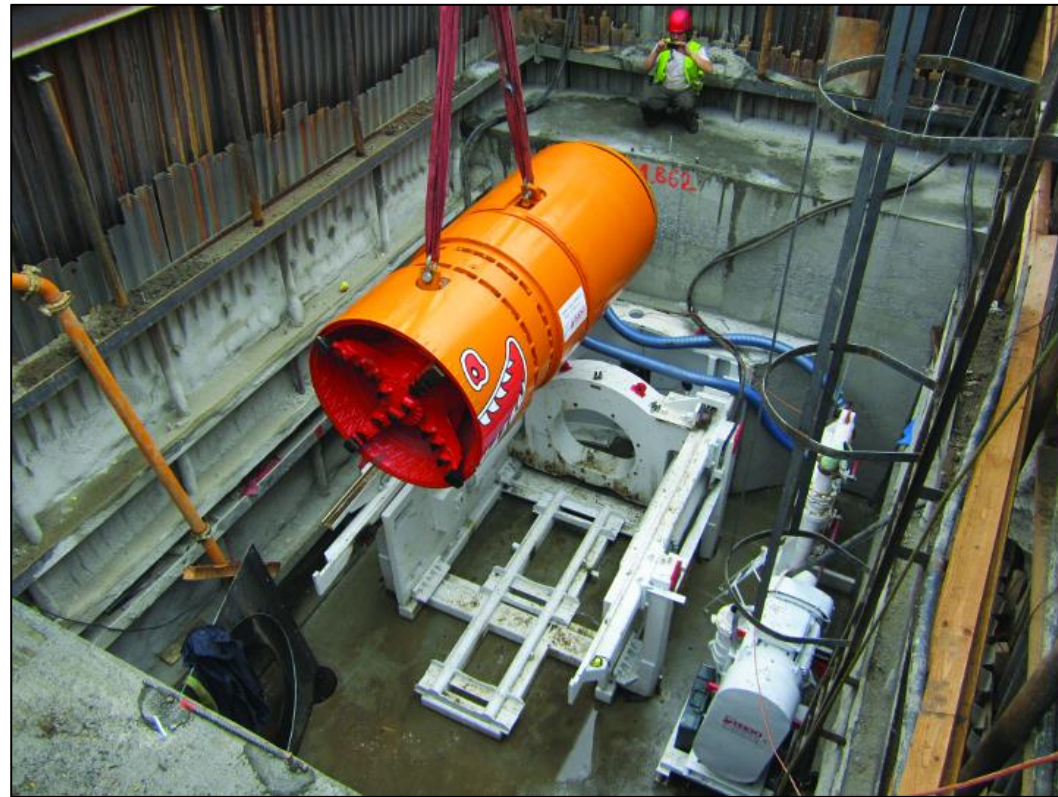
Εικόνα 7.1: Κεφαλή μηχανήματος Microtunneling κατά την τοποθέτηση
