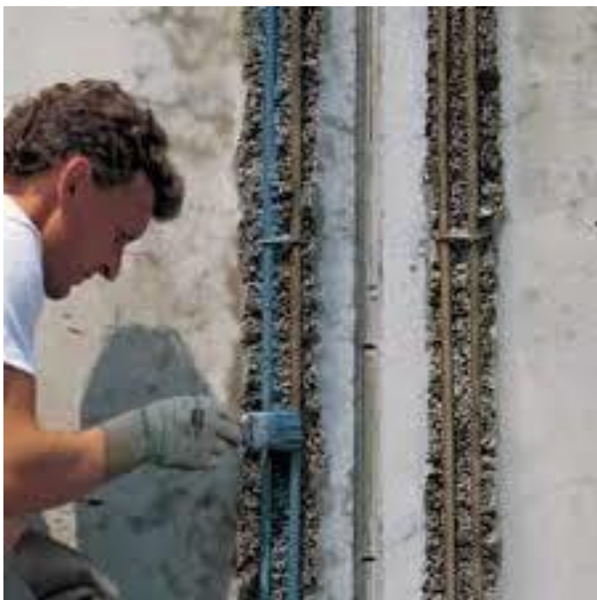
Εικόνα 9.8: Επάλειψη με αναστολέα διάβρωσης
