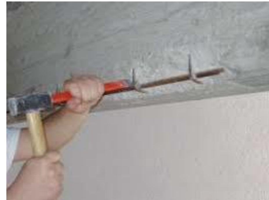
Εικόνα 9.7: Απομάκρυνση του σαθρού σκυροδέματος γύρω από τον οπλισμό
