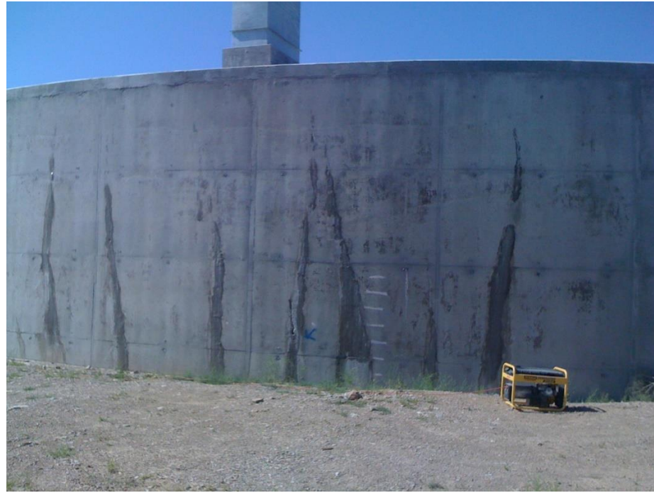
Εικόνα 9.10: Τελικό αποτέλεσμα μετά την επικάλυψη του σπλισμού
