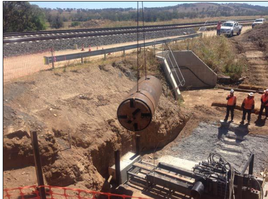
Εικόνα 7.9: Κεφαλή μηχανήματος Microtunnelling με ατέρμονα κοχλία, κατά την τοποθέτηση
