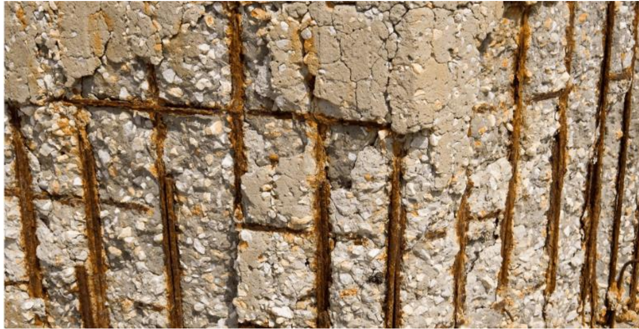
Εικόνα 9.3: Ρηγμάτωση σκυροδέματος
