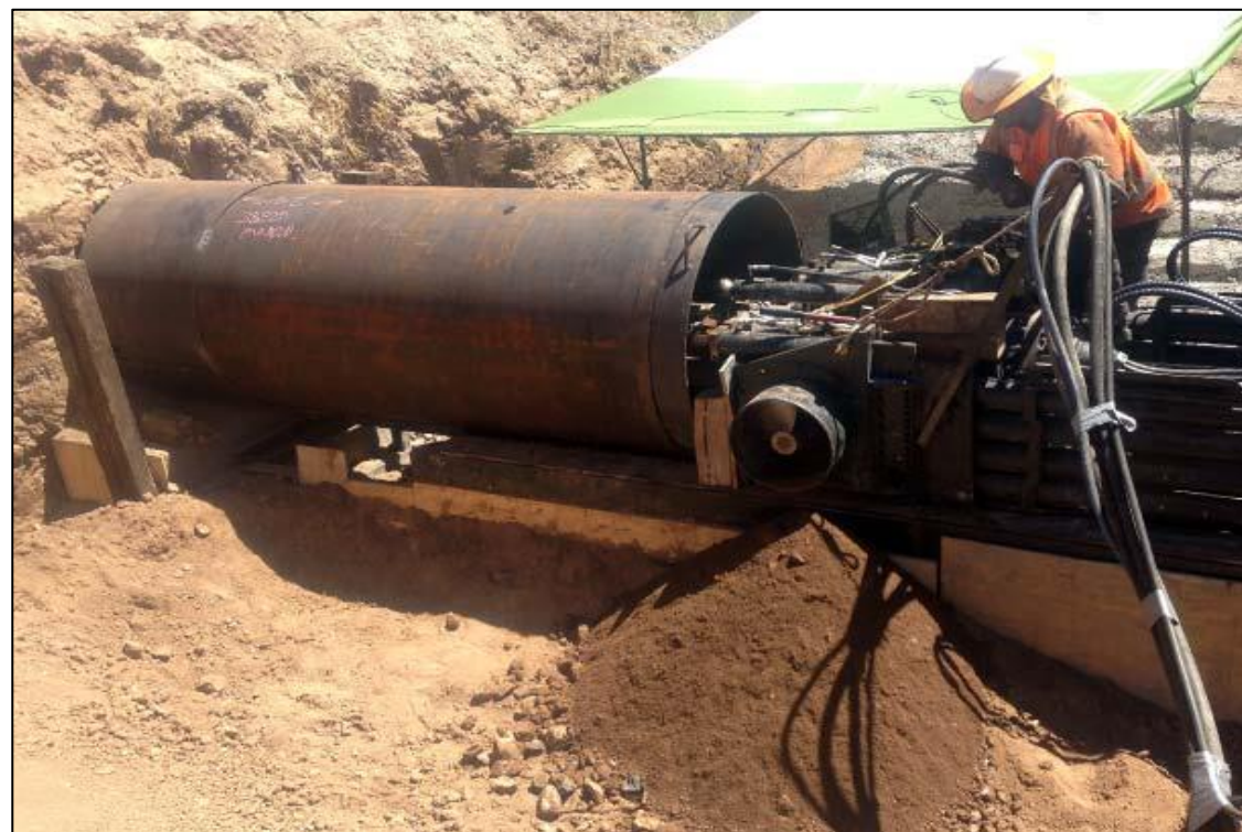
Εικόνα 7.10: Κεφαλή μηχανήματος Microtunnelling με ατέρμονα κοχλία κατά την εγκατάσταση
