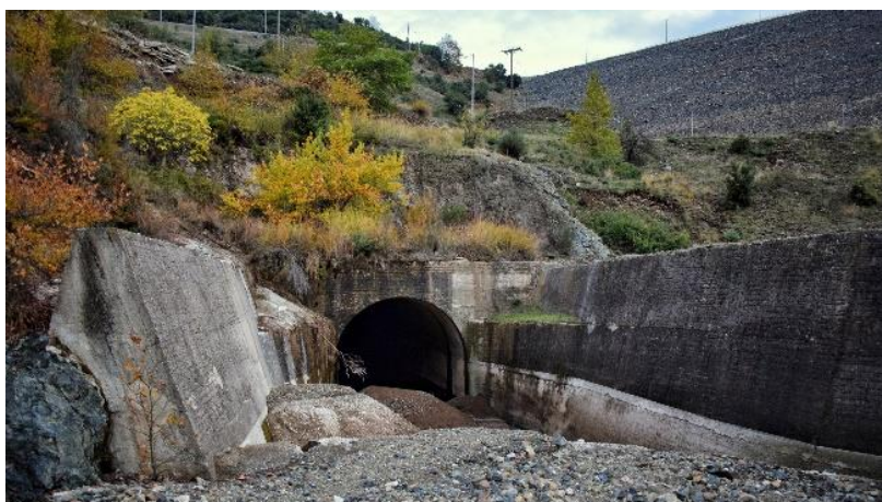
Εικόνες 2.13: Η έξοδος του εκκενωτή πυθμένα. Τα φερτά στη φωτογραφία προέρχονται από πρόσφατη καταιγίδα (Πηγή: Προσωπικό αρχείο, 30.10.2020)
