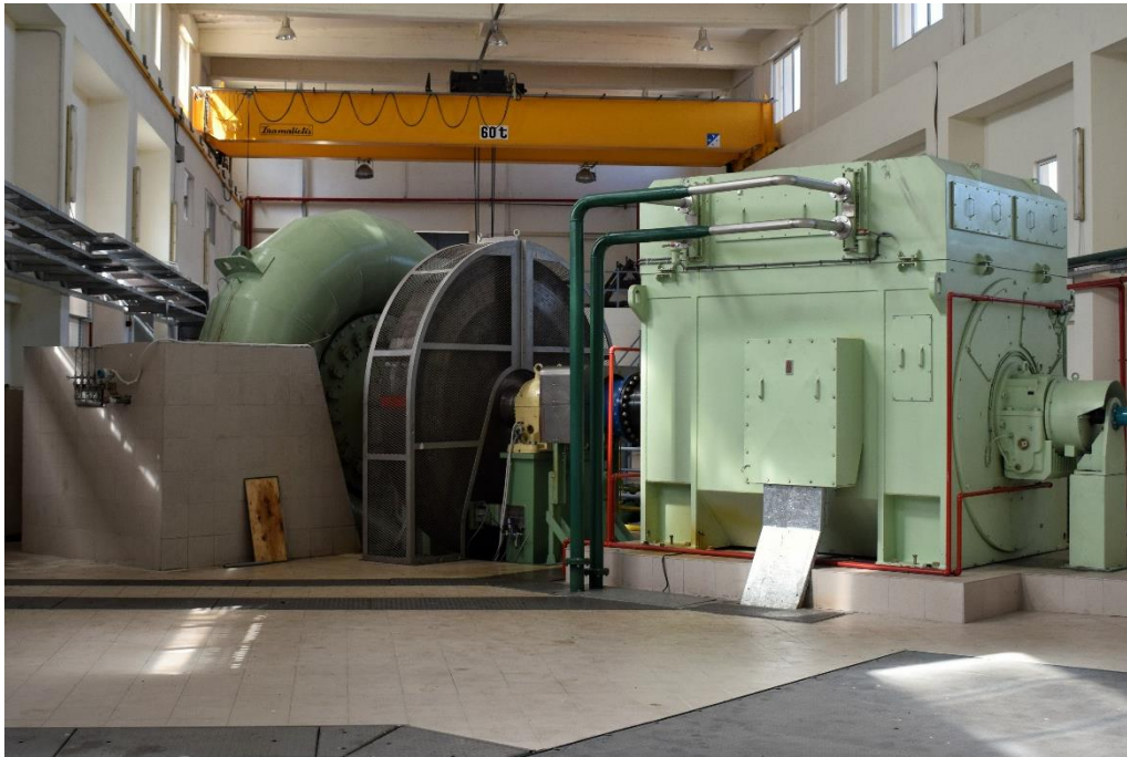
Εικόνα Α.1: Η πίσω πλευρά της Μονάδας 2 του Σμόκοβο-1. Διακρίνονται η θεμελίωση του στροβίλου, ο δίσκος σταθεροποίησης και η γεννήτρια. (Πηγή: Προσωπικό Αρχείο, 13.03.2020)
