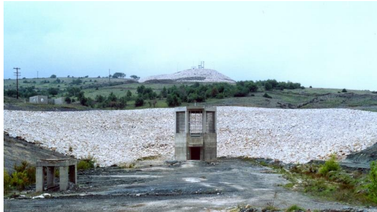
Εικόνα 2.16: Ο πύργος υδροληψίας πριν την πλήρωση του ταμιευτήρα (Πηγή: Σπυριδώνης, 2002)
