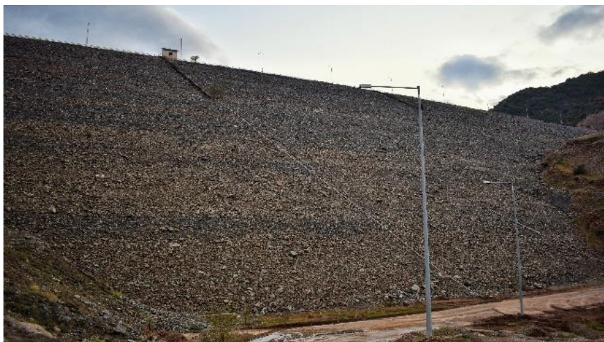
Εικόνα 2.6: Κατάντη όψη του φράγματος Σμοκόβου (Πηγή: Προσωπικό αρχείο, 30.10.2020)
