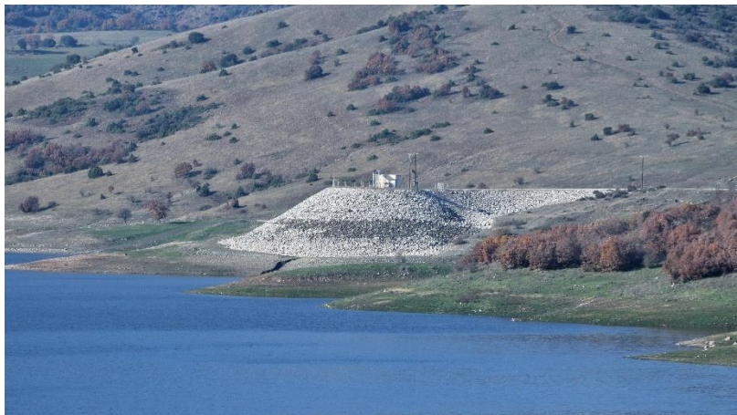
Εικόνα 2.17: Η κορυφή του φρέατος θυροφραγμάτων με το κτίριο ελέγχου (Πηγή: Προσωπικό αρχείο, 16.12.2020)
