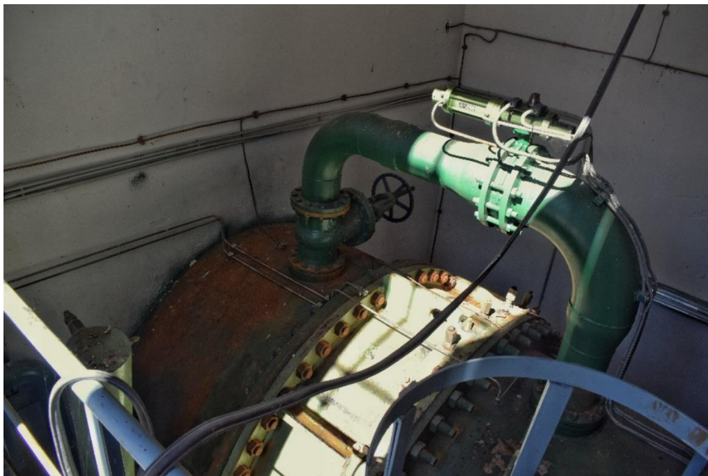
Εικόνα Α.4: Η βαλβίδα τύπου πεταλούδας που ρυθμίζει την παροχή νερού στο Σμόκοβο-1. (Πηγή: Προσωπικό Αρχείο, 13.03.2020)
