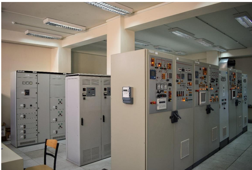
Εικόνα Α.2: Το ηλεκτρονικό σύστημα παρακολούθησης, καταγραφής δεδομένων και λειτουργίας του σταθμού (SCADA). (Πηγή: Προσωπικό Αρχείο, 13.03.2020)
