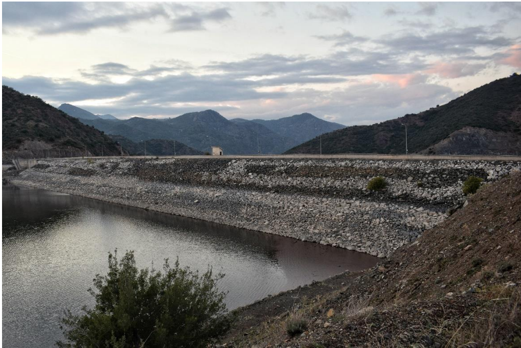
Εικόνα Α.7: Η ανάντη όψη του φράγματος Σμοκόβου. (Πηγή: Προσωπικό Αρχείο, 30.10.2020)
