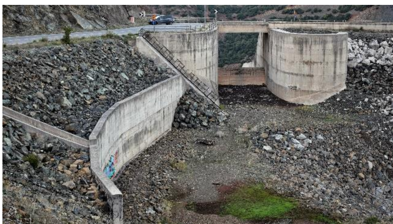
Εικόνα 2.8: Ο υπερχειλιστής και θέση του σε σχέση με το φράγμα. Η στέψη της υπερχείλισης βρίσκεται στα +375.0 m (Πηγή: Προσωπικό αρχείο, 30.10.2020)
