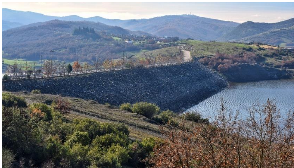
Εικόνα 2.29: Το ανάχωμα αποκατάστασης επικοινωνίας της Κτιμένης (Πηγή: Προσωπικό αρχείο, 16.12.2020)
