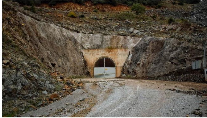
Εικόνα 2.14: Η έξοδος της σήραγγας προσπέλασης των θυροφραγμάτων (Πηγή: Προσωπικό αρχείο, 30.10.2020)
