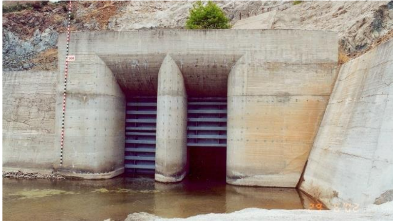
Εικόνα 2.12: Τα θυροφράγματα έμφραξης της σήραγγας εκτροπής (Πηγή: Σπυριδώνης, 2002)
