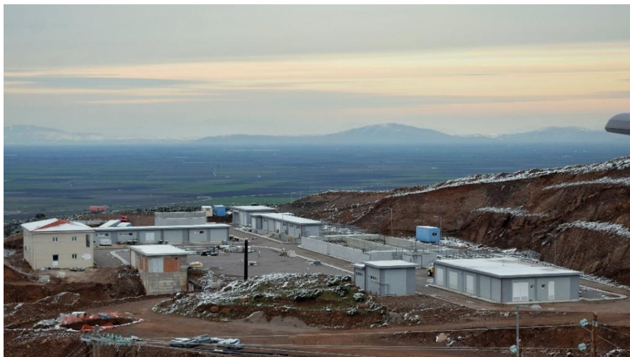
Εικόνα 2.28: Το Δωλιστήριο Πόσιμου Νερού, με την κατασκευή του να έχει σχεδόν ολοκληρωθεί (Πηγή: Προσωπικό αρχείο, 17.01.2021)
