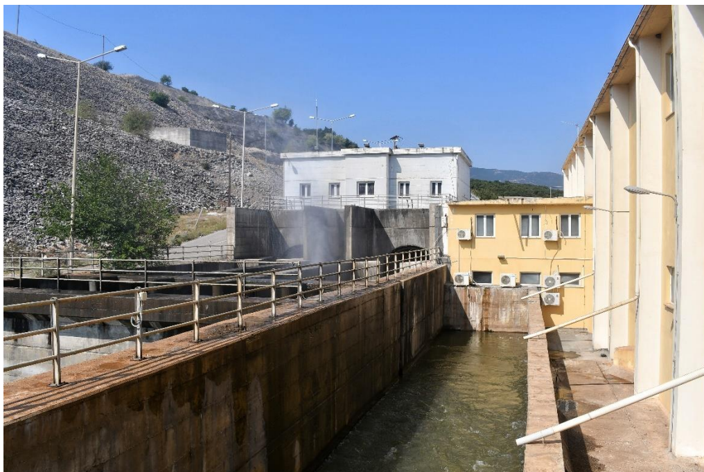
Εικόνα Α.6: Η διώρυγα φυγής των υδροστροβίλων εν ώρα λειτουργίας. Στο βάθος διακρίνεται νέφος νερού από τη μεσαία βαλβίδα του Έργου Καταστροφής Ενέργειας. (Πηγή: Προσωπικό Αρχείο, 25.08.2021)
