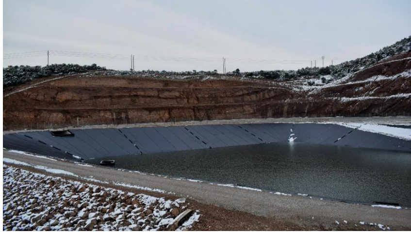
Εικόνα 2.27: Η λιμνοδεξαμενή χωρητικότητας 81 279 m 3 . Διακρίνεται το φρεάτιο στο εσωτερικό της και ο υπερχειλιστής (Πηγή: Προσωπικό αρχείο, 17.01.2021)
