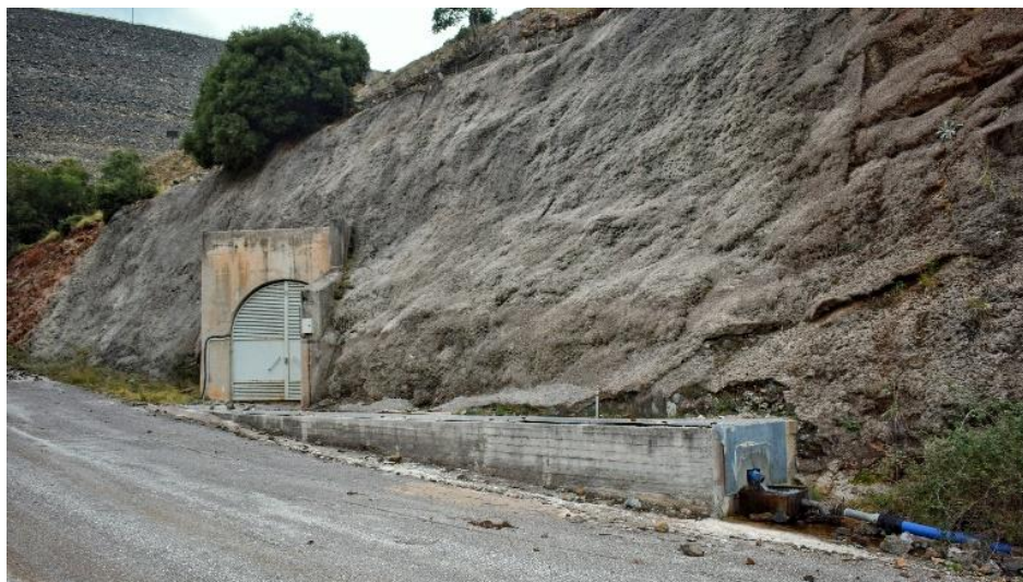
Εικόνα 2.10: Έξοδος της σήραγγας αποστράγγισης, τα νερά από τα στραγγιστήρια συνεισφέρουν στην οικολογική παροχή (Πηγή: Προσωπικό αρχείο, 30.10.2020)
