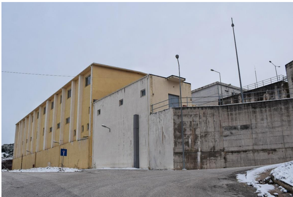
Εικόνα Α.5: Η βόρεια όψη του υδροηλεκτρικού σταθμού Σμόκοβο-1. (Πηγή: Προσωπικό Αρχείο, 17.01.2021)
