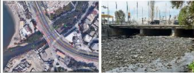
RI-P3-G: Γέφυρα Λεωφόρου Ποσειδώνιας στο ρέμα Πικροδάφνης
