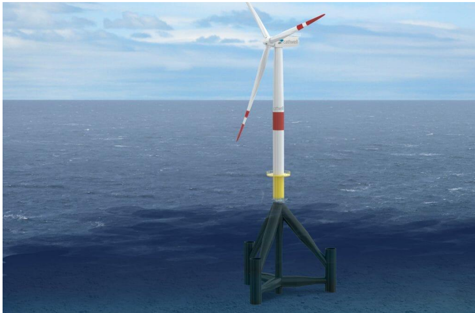
Εικόνα 3.8: Διάταξη τριπόδου
