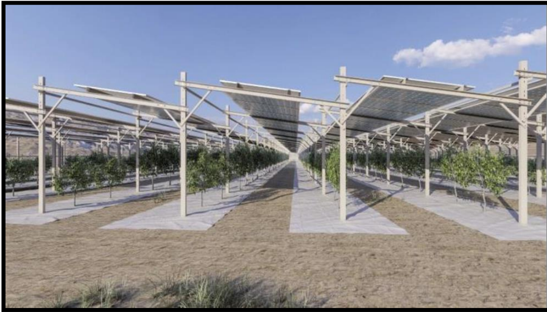
Εικόνα 4.2 : Φωτοβολταϊκά πάνελ διπλής όψης σε δενδρώδη καλλιέργεια στο Ισραήλ
