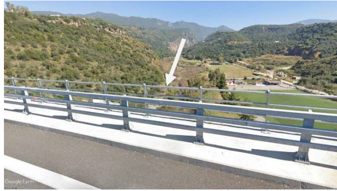
Σχήμα 12. Νέδων ανάντη της Περιμετρικής Οδού
