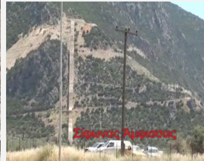
Σίφωνας Άμφισσας: Τμήμα του υδραγωγείου Μόρνου, δίδυμοι χαλύβδινοι αγωγοί επενδυμένοι με σπλισμένο σκυρόδεμα (μήκος 2410 m, διάμετρος 2x2.55 m, παροχή 23 m 3 /s, μέγιστο φορτίο 240 m)
