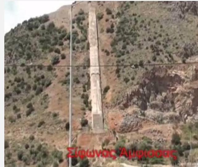
Σίφωνας Άμφισσας: Τμήμα του υδραγωγείου Μόρνου, δίδυμοι χαλύβδινοι αγωγοί επενδυμένοι με σπλισμένο σκυρόδεμα (μήκος 2410 m, διάμετρος 2x2.55 m, παροχή 23 m 3 /s, μέγιστο φορτίο 240 m)
