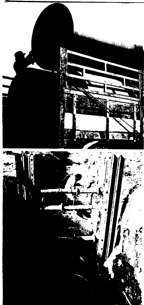
Σχήμα 2.3. Σωλήνες υπονόμων helidur-spiral μεγάλων διαμέτρων από σκλήρο PVC από την ΑΓ. ΠΕΤΖΕΤΑΚΙΣ Α.Ε.
