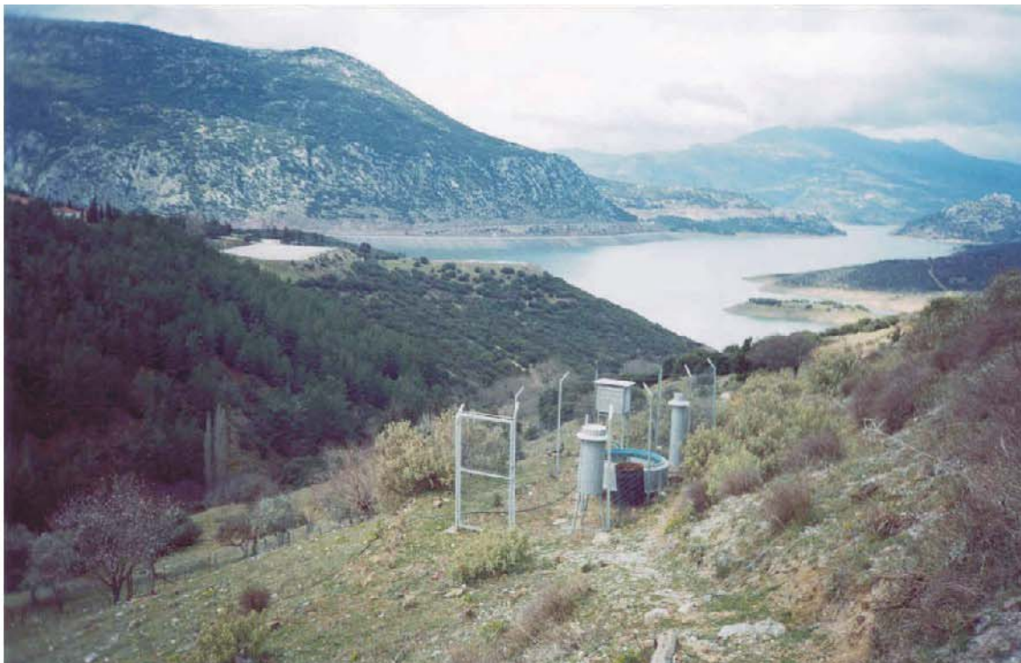
Φωτο 3.3.5-2 Αποψη του σταθμού Λιδωρικού στη σημερινή του θέση. Στο βάθος διακρίνεται ο ταμιευτήρας καθώς και το έργο στεγανοποίησης του Πύρνου
