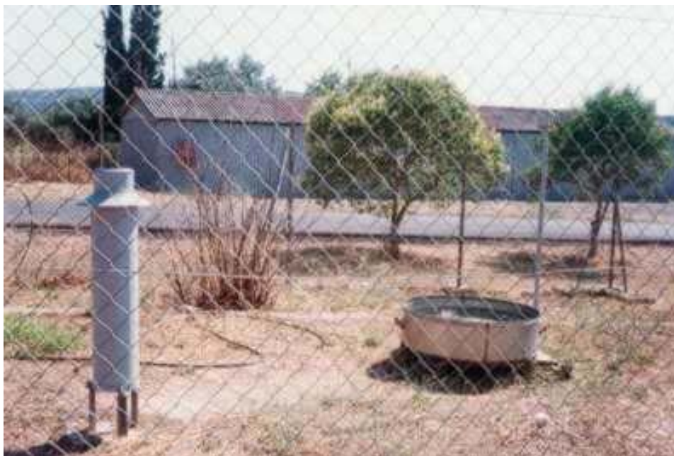
Φωτο 3.3.1-1 Άποψη του μετεωρολογικού σταθμού Πουρναρίου
