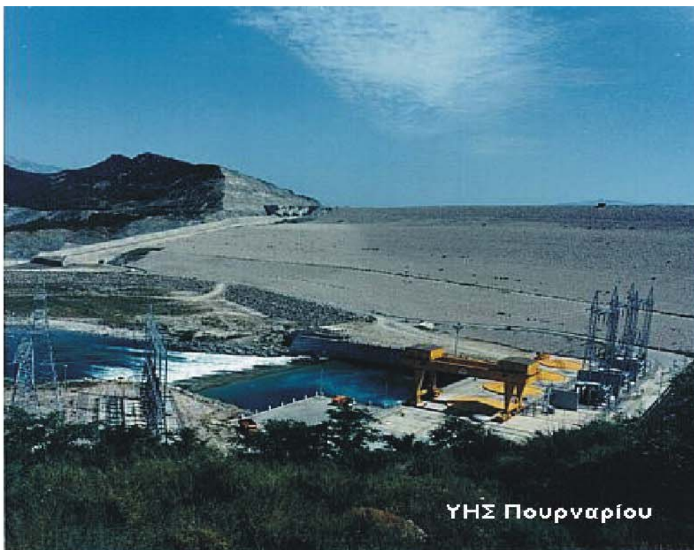
Φωτο 3.2.1-1 Η στέψη και ο υδροηλεκτρικός σταθμός του φράγματος Πουρναρίου
