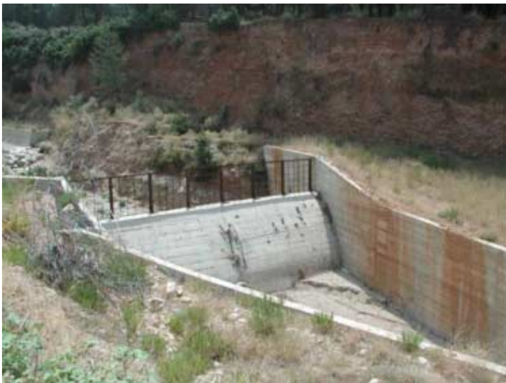
Φωτ. 4 Η είσοδος του τεχνικού έργου διάβασης του Διακονιάρη κάτω από τον κόμβο της Ε. Π. Π.
