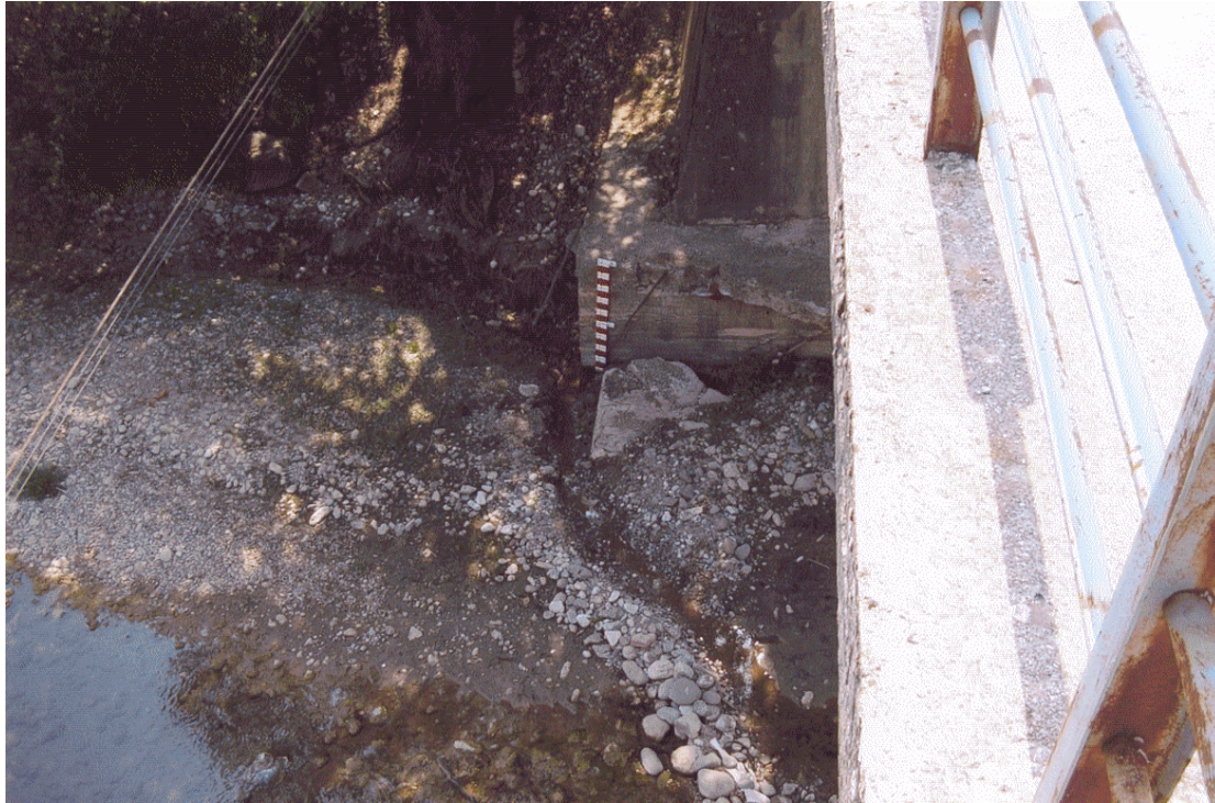
Φωτογραφία 8. Γέφυρα Καραϊσκάκη (Μουζάκι) και υδρομετρικός σταθμός (Λήψη Τέλη Αυγούστου)
