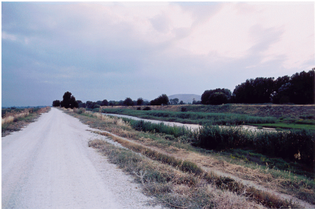
Φωτογραφία 7. Αποστραγγιστικό κανάλι Κρούπι αμέσως ανάντη του Αλή Εφέντη. Μέσω αυτού του καναλιού διοδεύονται οι χειμερινές απορροές του Πλαστήρα στη θέση του υδρομετρικού σταθμού Αλή Εφέντη. (Λήψη τέλη Ιουνίου)
