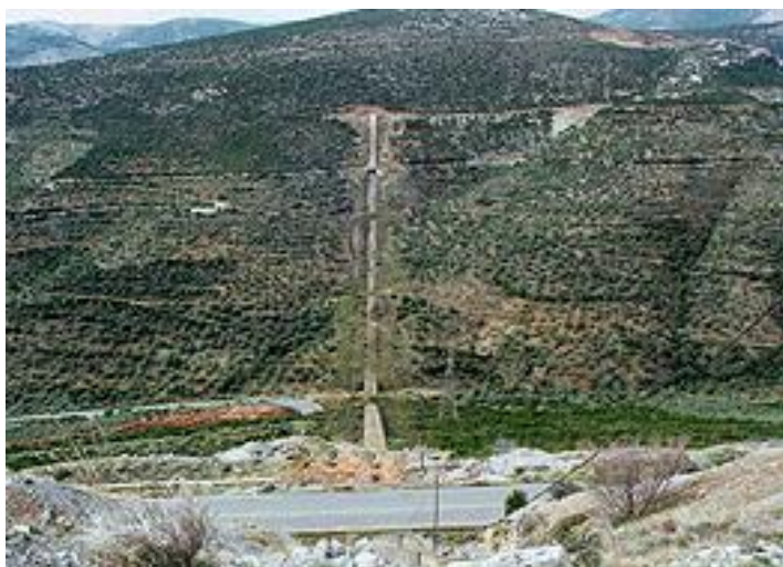
Φράγμα & ταμιευτήρας Μόρνου
