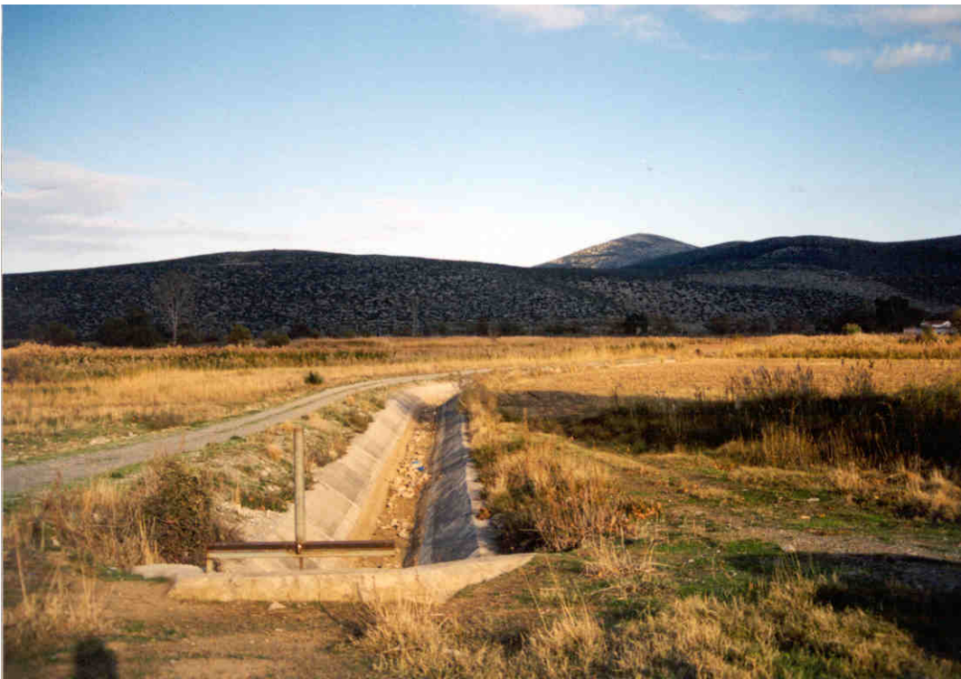
Φωτογραφία 9: Αρδευτικό κανάλι που τροφοδοτείται από το ρέμα Μαυρονερίου μέσω θυροφράγματος, λίγο πριν τις ομώνυμες πηγές.
