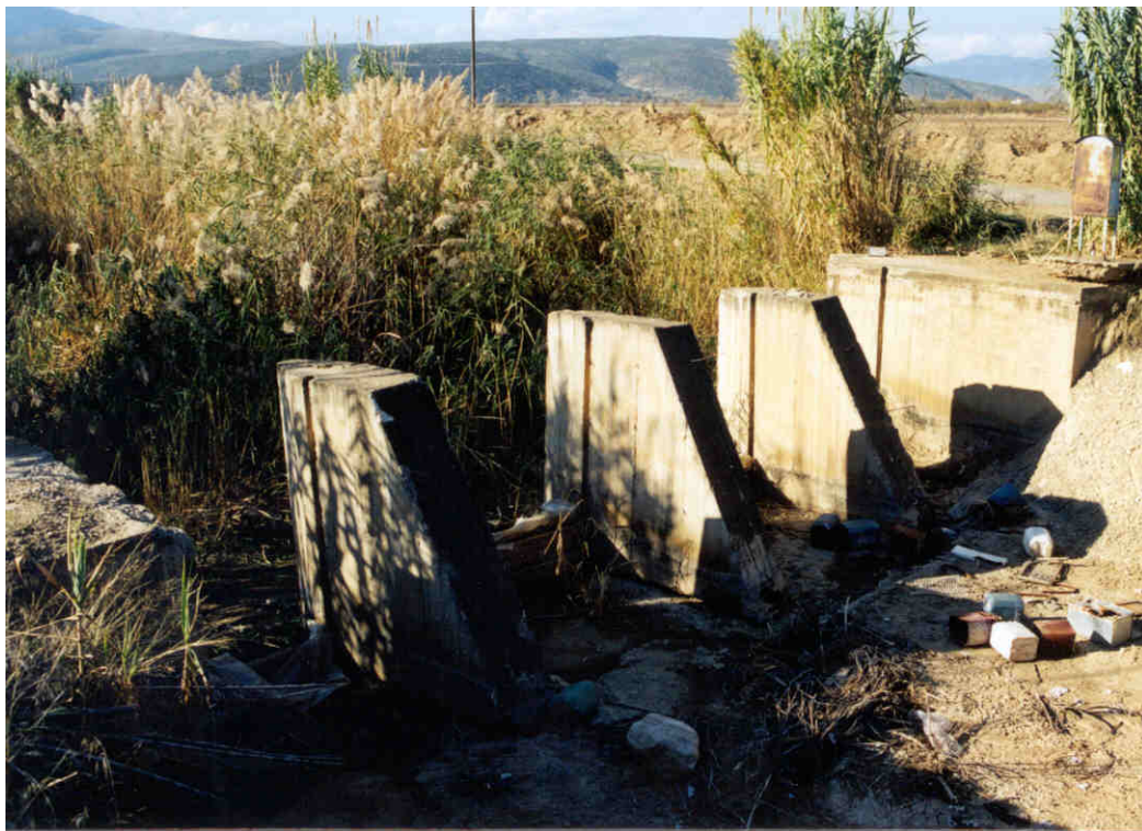
Φωτογραφία 7: Άποψη της κοίτης του ρέματος Μαυρονερίου από την άλλη πλευρά της γέφυρας, όπου υπάρχει ειδική διάταξη για την τοποθέτηση θυροφραγμάτων.
