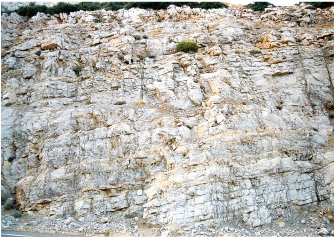
Φωτογραφία 11: Κατακόρυφο μέτωπο καρστικού ασβεστόλιθου στην περιοχή των πηγών Μαυρονερίου. Το ασβεστολιθικό πέτρωμα αναπτύσσεται σε οριζόντιες και κατακόρυφες στρώσεις και είναι έντονα τεκτονισμένο.
