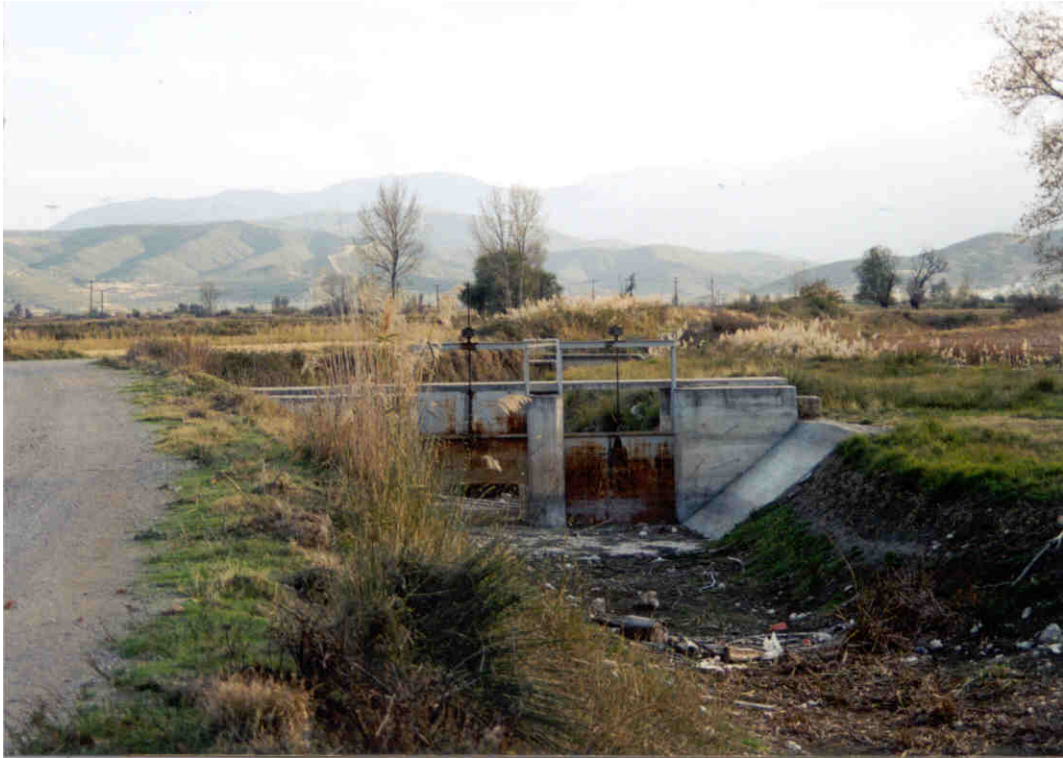
Φωτογραφία 8: Άποψη της κοίτης του ρέματος Μαυρονερίου από τον δρόμο που οδηγεί στις ομώνυμες πηγές (πίσω). Μέσω των θυροφραγμάτων, τα νερά των πηγών συλλέγονται ανάντη και χρησιμοποιούνται για άρδευση.
