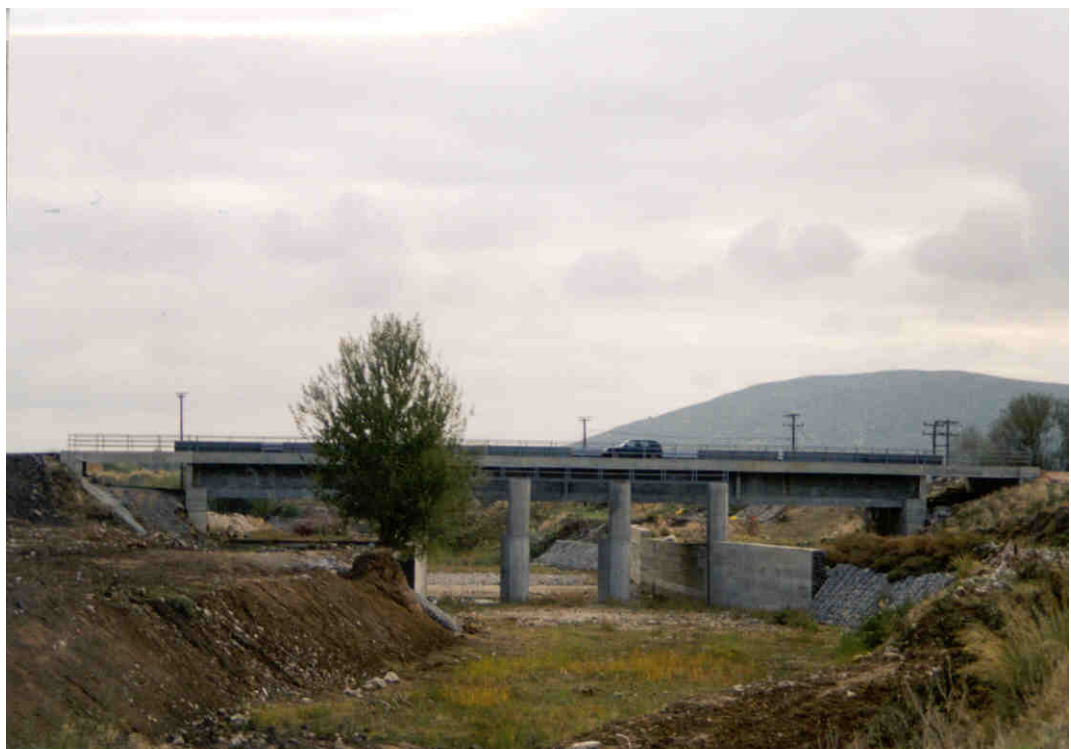
Φωτογραφία 13: Άποψη της κοίτης του Βοιωτικού Κηφισού κοντά στη θέση υδρομέτρησης Άγιος Βασίλειος Χαιρώνειας. Διακρίνεται η νέα γέφυρα και ο δρόμος που συνδέει τη Χαιρώνεια με τους οικισμούς του Ακόντιου όρους.
