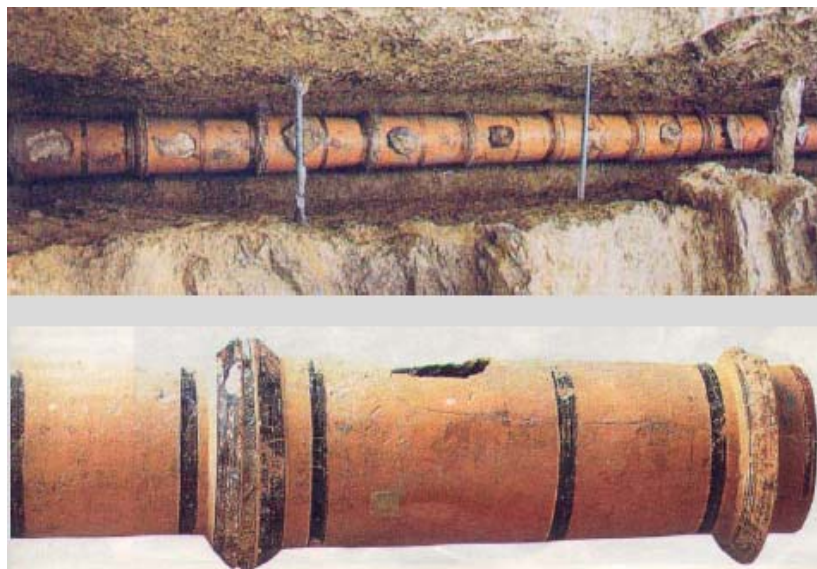
Εικόνα 29. Μέρος του Πεισιστράτειου υδραγωγείου (πάνω) και λεπτομέρεια του αγωγού (κάτω)
