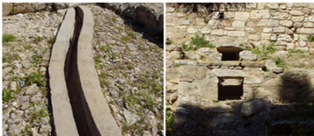
Εικόνα 13. Τμήματα του συστήματος αποχέτευσης στο ανάκτορο της Κνωσού, εντός του ανακτόρου (αριστερά) και στην έξοδο του κεντρικού αποχετευτικού αγωγού (δεξιά).
