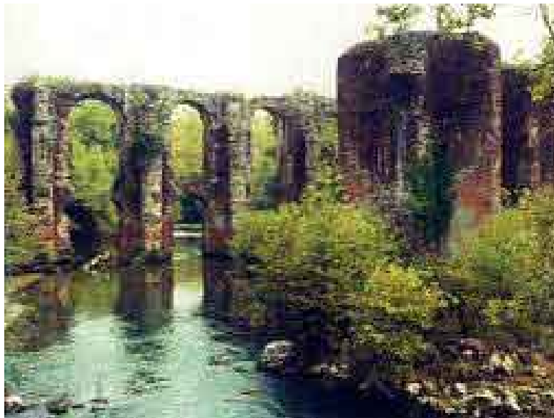
Εικόνα 21. Το ρωμαϊκό υδραγωγείο της Νικόπολης
