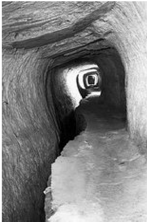
Εικόνα 27. Στο εσωτερικό της σήραγγας στη Σάμο
