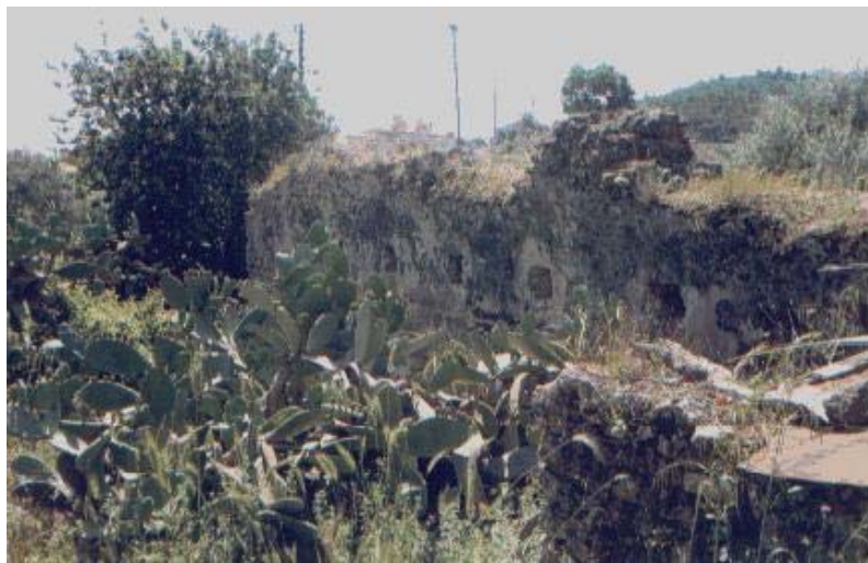
Εικόνα 16. Η ΒΑ όψη του υδραγωγείου
