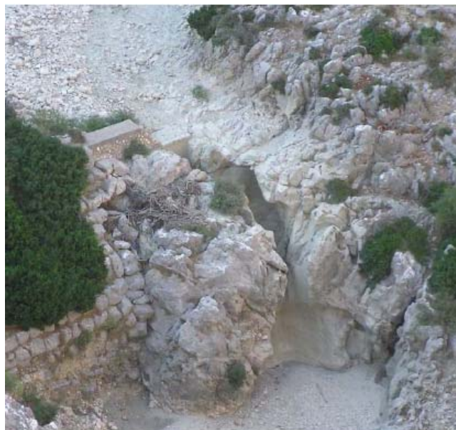
Εικόνα 2. Φυσικός υπερχειλιστής στο αριστερό αντέρεισμα (08/2004)
