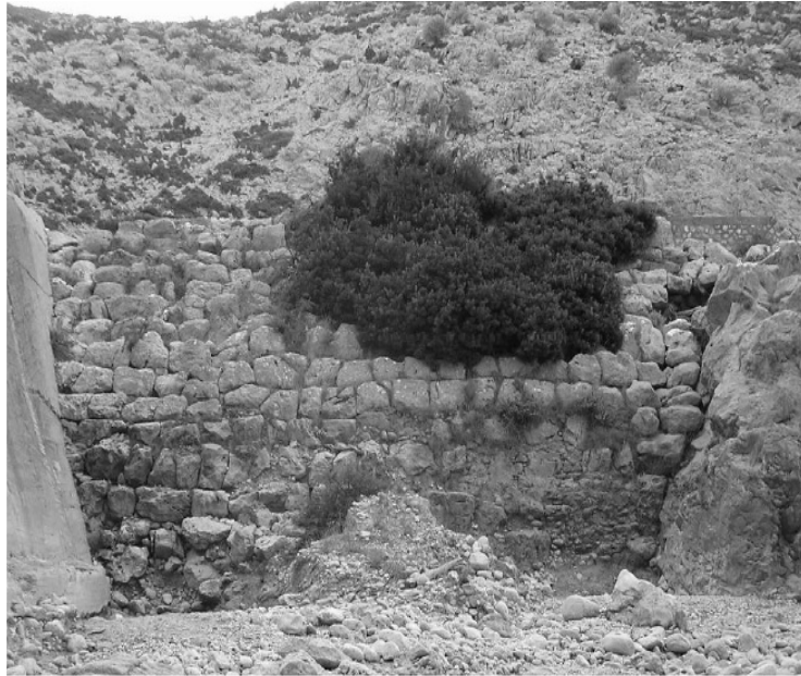
Εικόνα 1. Κατάντη παρειά του φράγματος (08/2004)
