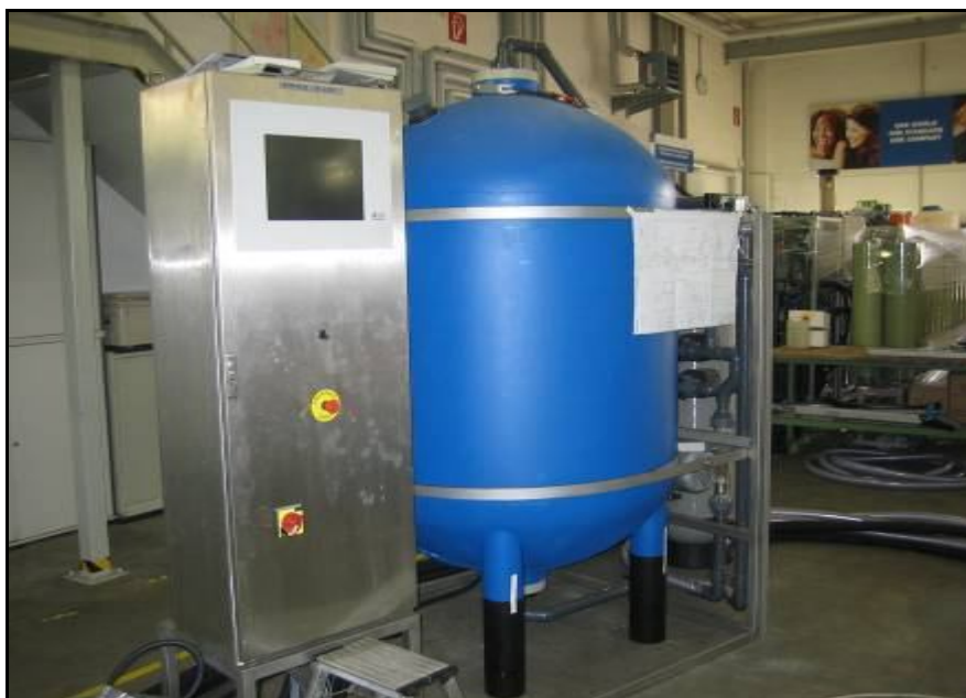
Εικόνα 5.8 – Δεξαμενή αποθήκευσης πόσιμου νερού
