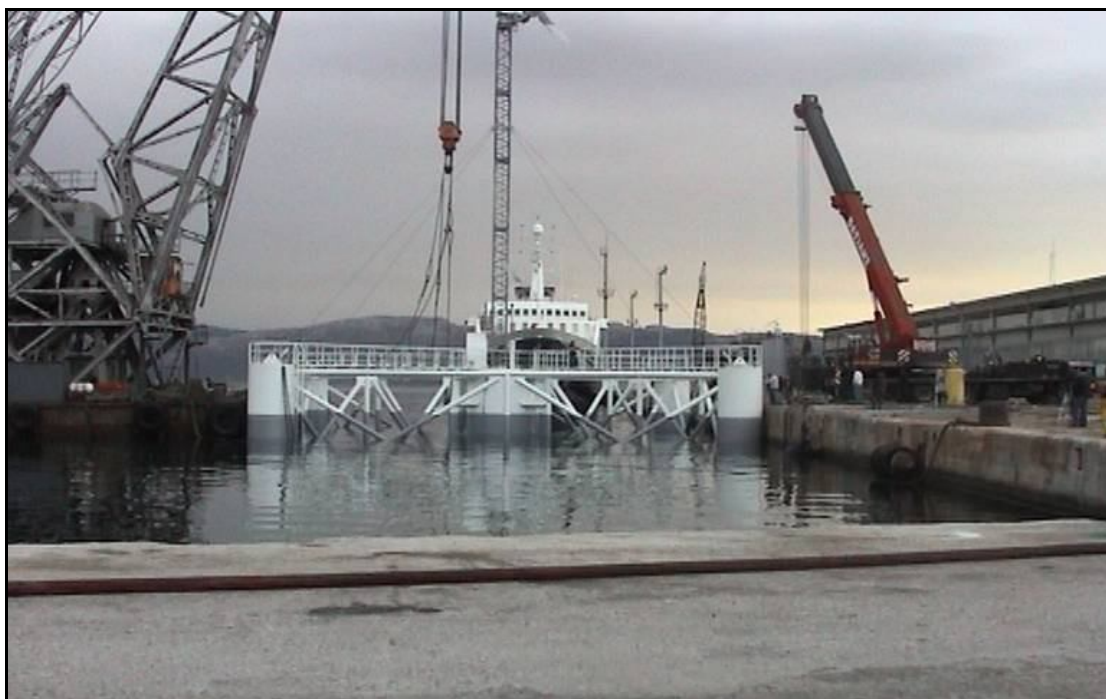
Εικόνα 5.10 – Μεταφορά της μονάδας αφαλάτωσης με ρυμουλκό
