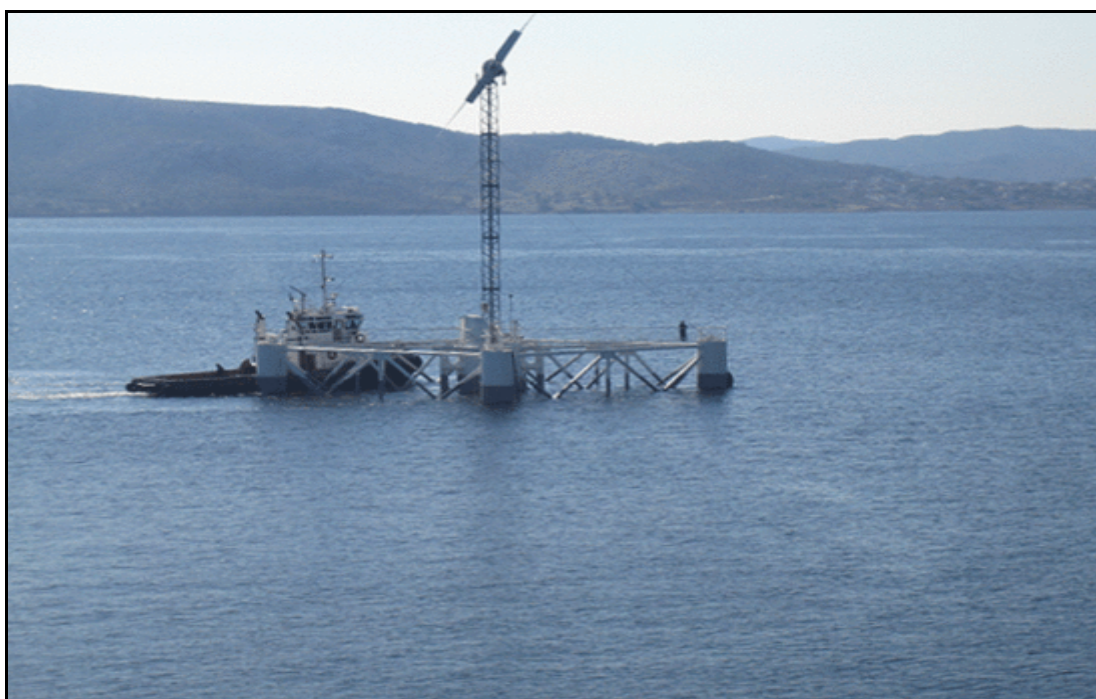
Εικόνα 5.6 – Πλωτή μονάδα αφαλάτωσης με χρήση ανανεώσιμων πηγών ενέργειας «ΥΔΡΙΑΔΑ»
