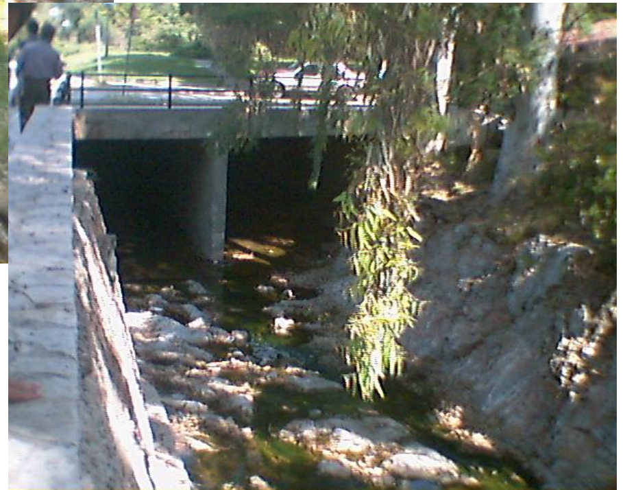
Κλειστό ρέμα: Ποδονίφτης στη Νέα Ιωνία (καθώς και ανάντη της Λ. Κηφισίας)
