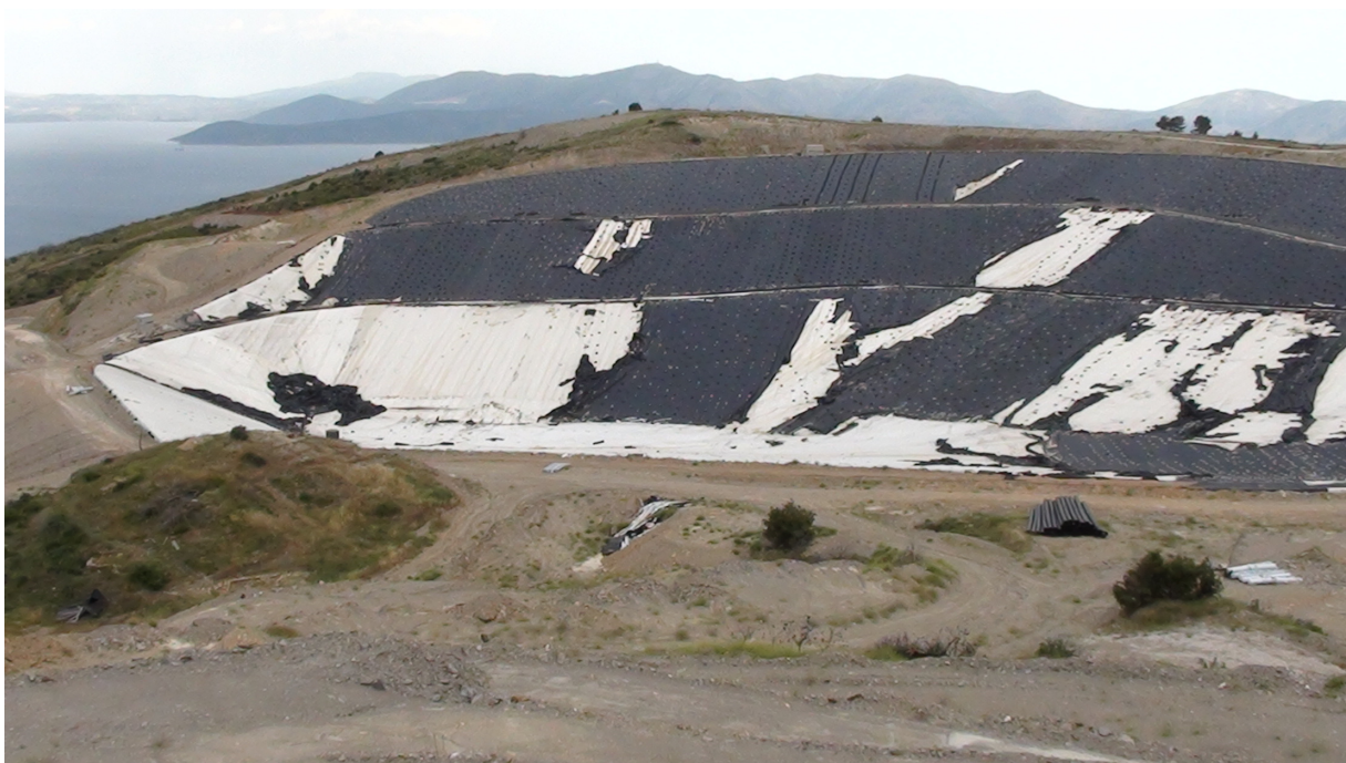
Φωτογραφία Φ4 Γενική άποψη ΧΥΤΑ 1 με κατεστραμμένη τη στεγάνωση
