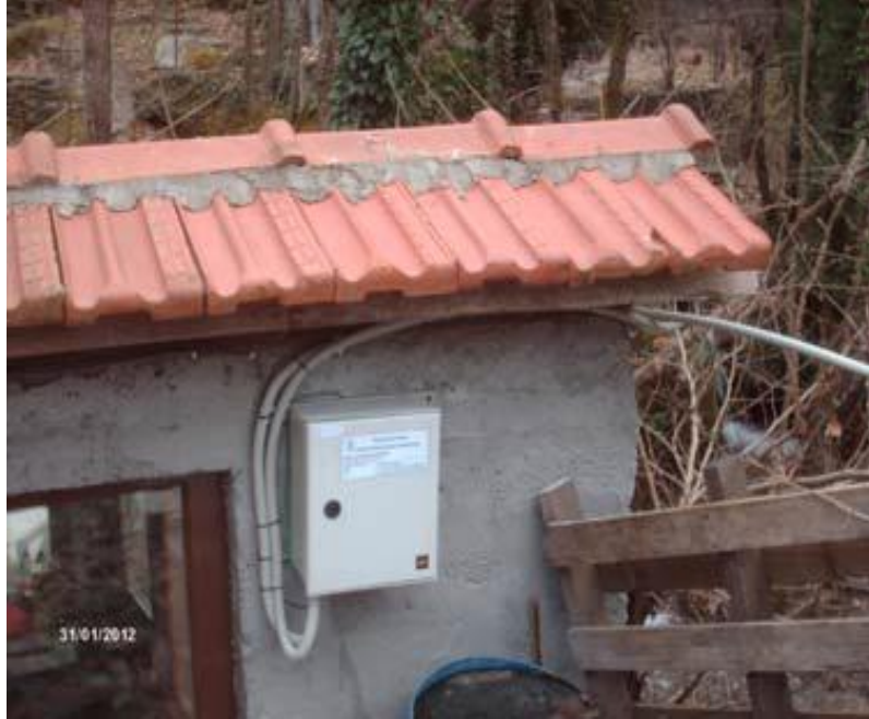
Φωτογραφία 4.3: Σύστημα τηλεμετρίας στον σταθμημετρικό σταθμό Αλαγονίας
