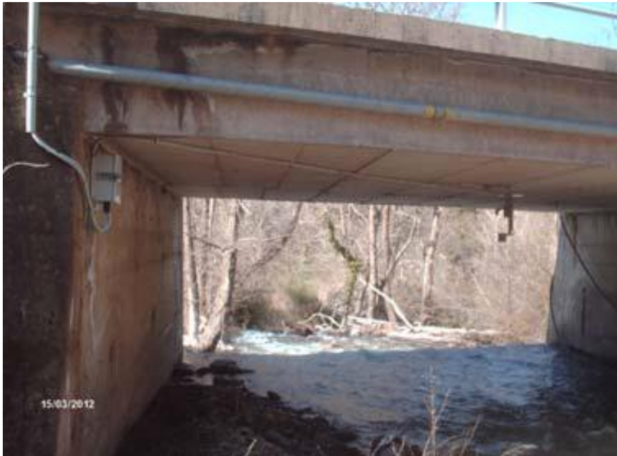
Φωτογραφία 4.5: Σταθμημετρικός σταθμός Γέφυρας Καρβελιώτη
