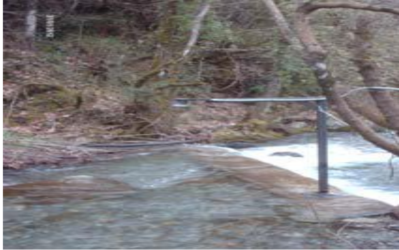
Φωτογραφία 4.6: Σταθμημετρικός σταθμός Αλαγονίας (Νερόμυλος Ρεντίφη).
