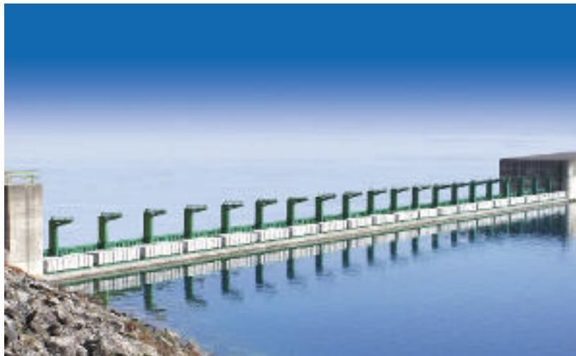
Εικόνα 5.31: Ανατρεπόμενα θυροφράγματα στον ταμιευτήρα Καστρακίου (Πηγή: Raycap , http://www.raygates.com/#!greece-kastraki-ppc/cw99 ).
