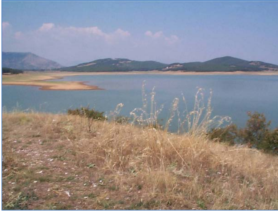
Εικόνα 5.16 : Η εμφάνιση της νεκρής ζώνης μειώνει την καλαισθησία του τοπίου, οπότε κρίνεται αναγκαία η τήρηση ελάχιστης στάθμης στον ταμιευτήρα. (Πηγή: Σαργέντης και Χριστοφίδης, 2002).
