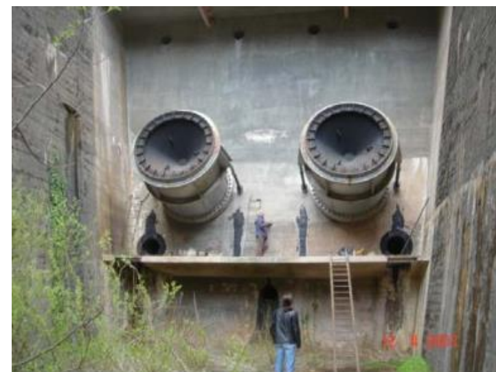
Έξοδος εκκενωτή φράγματος Ταυρωπού
