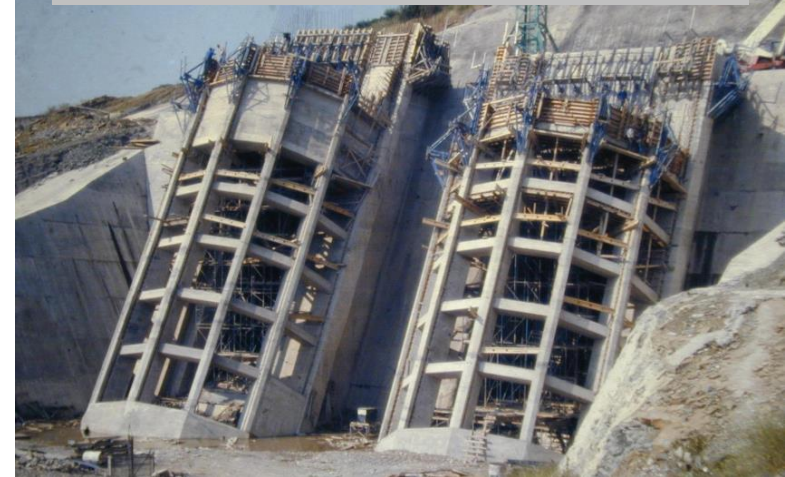
Κατασκευή υδροληψίας ΥΗΕ Στράτου
