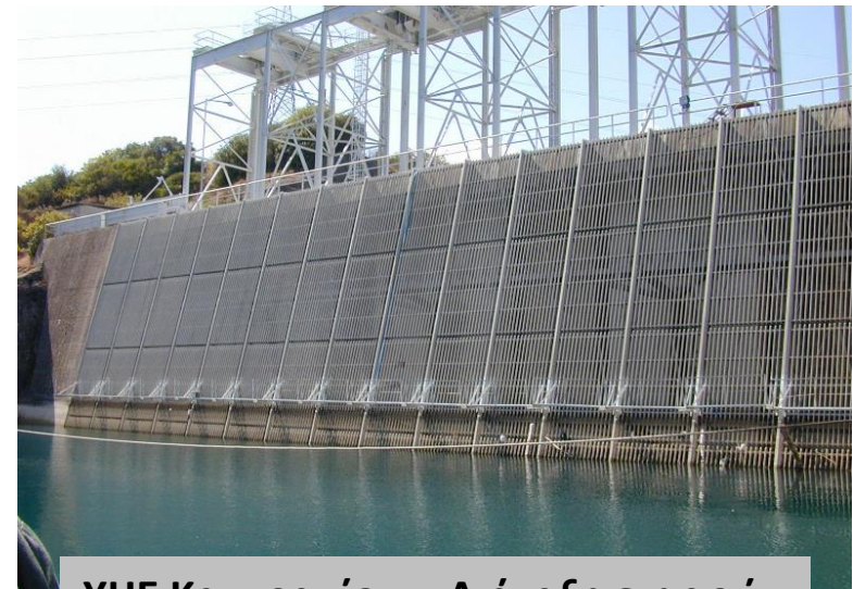
ΥΗΕ Καστρακίου – Διάταξη εσχάρων και μηχανισμοί θυροφραγμάτων
