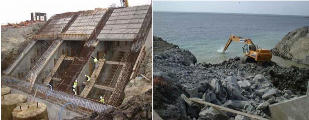
Εικόνα 2.8 Έργα πριν την λειτουργία του σταθμού (Πηγή: Queen’s University of Belfast, 2002)
