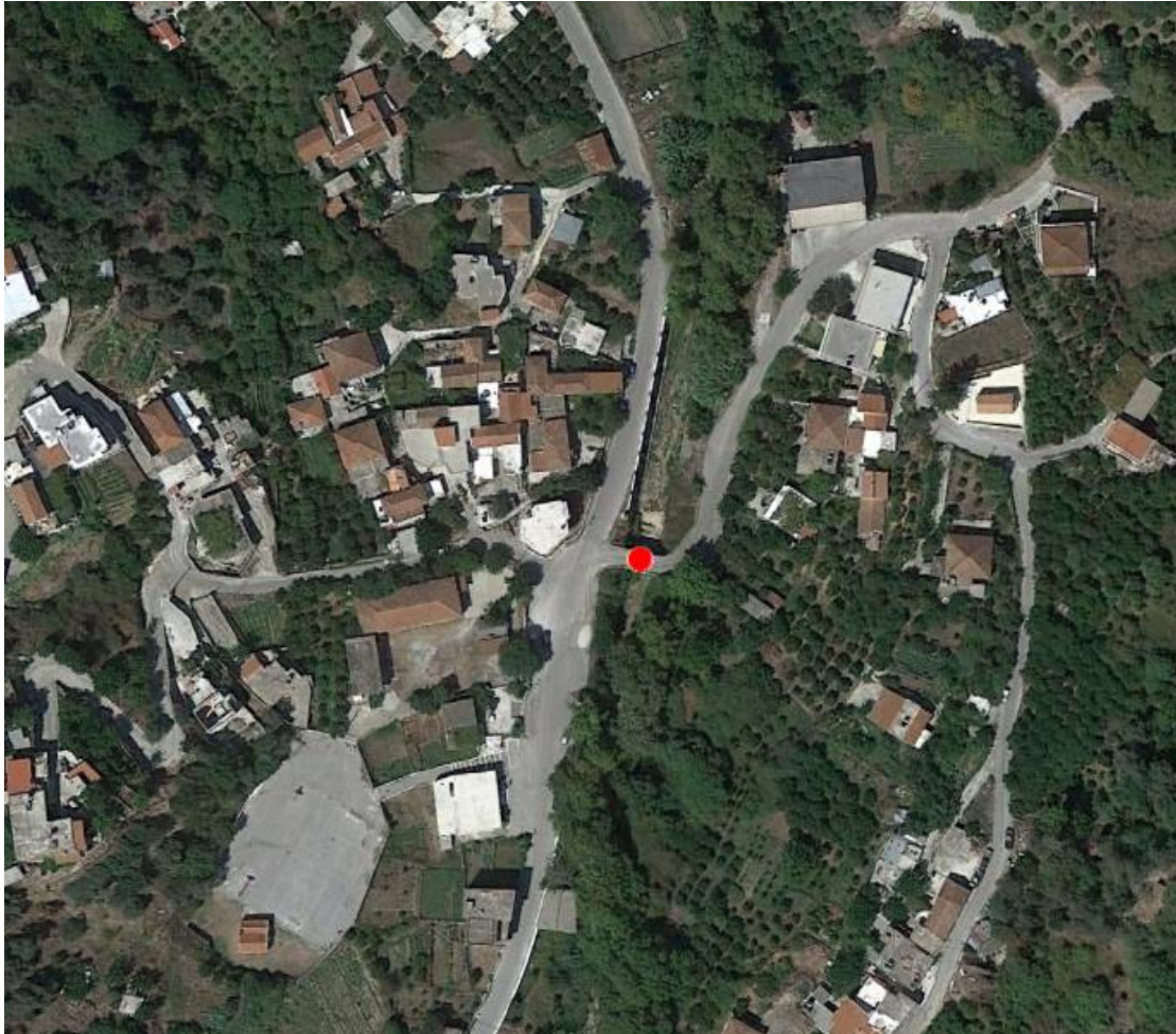
Εικόνα 2.2: Δορυφορική απεικόνιση περιοχής του υδρομετρικού σταθμού γέφυρα Μεσκλών.
