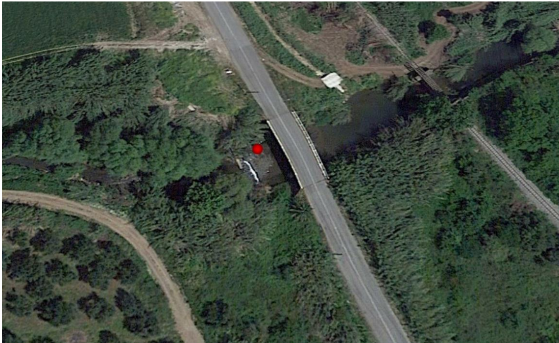
Εικόνα 2.31: Δορυφορική απεικόνιση περιοχής υδρομετρικών σταθμών Γέφυρας Μαγούλας
