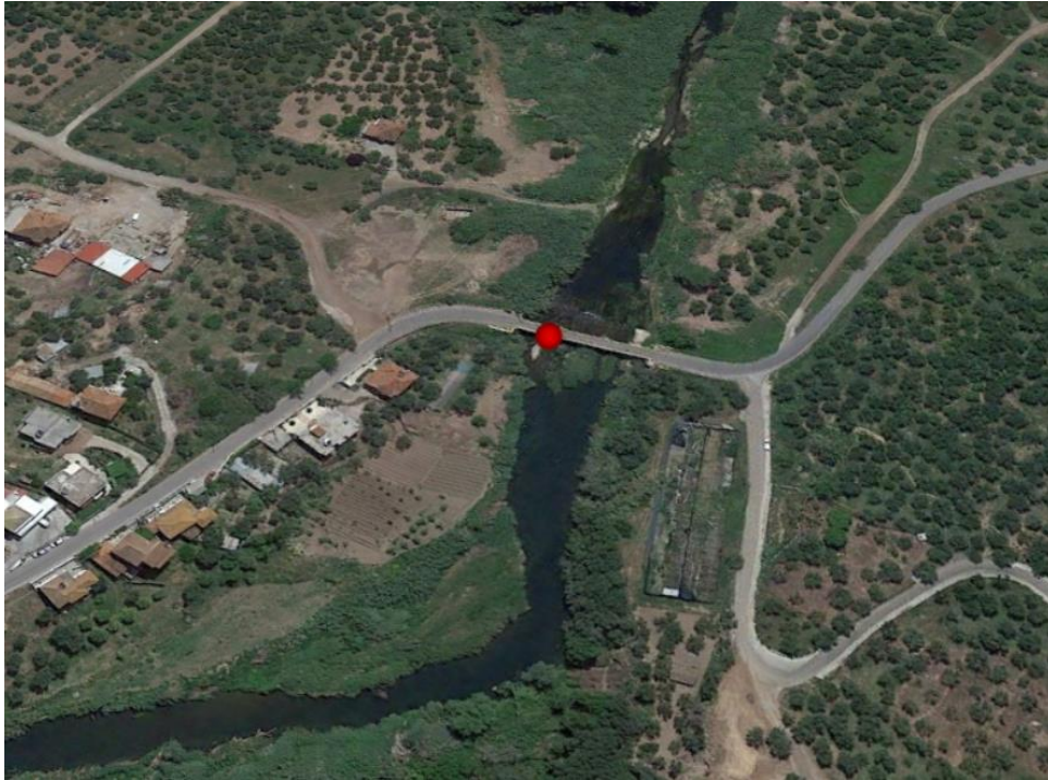
Εικόνα 2.33: Δορυφορική απεικόνιση περιοχής υδρομετρικών σταθμών Γέφυρας Βαλύρας
