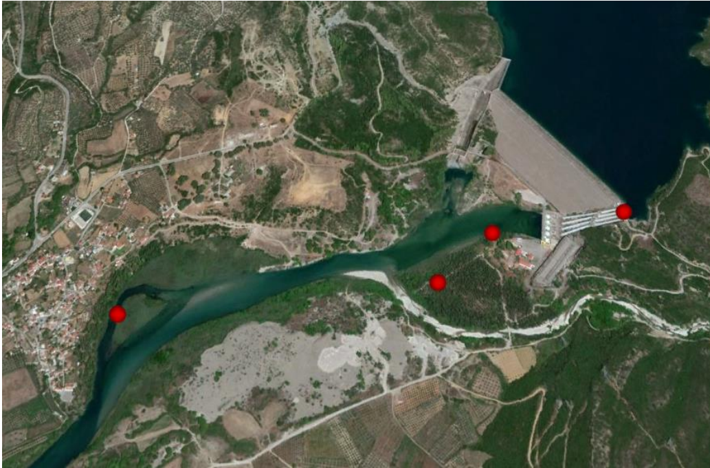
Εικόνα 2.8: Δορυφορική απεικόνιση περιοχής φράγματος Καστρακίου, όπου είχαν λειτουργήσει τέσσερις υδρομετρικοί σταθμοί
