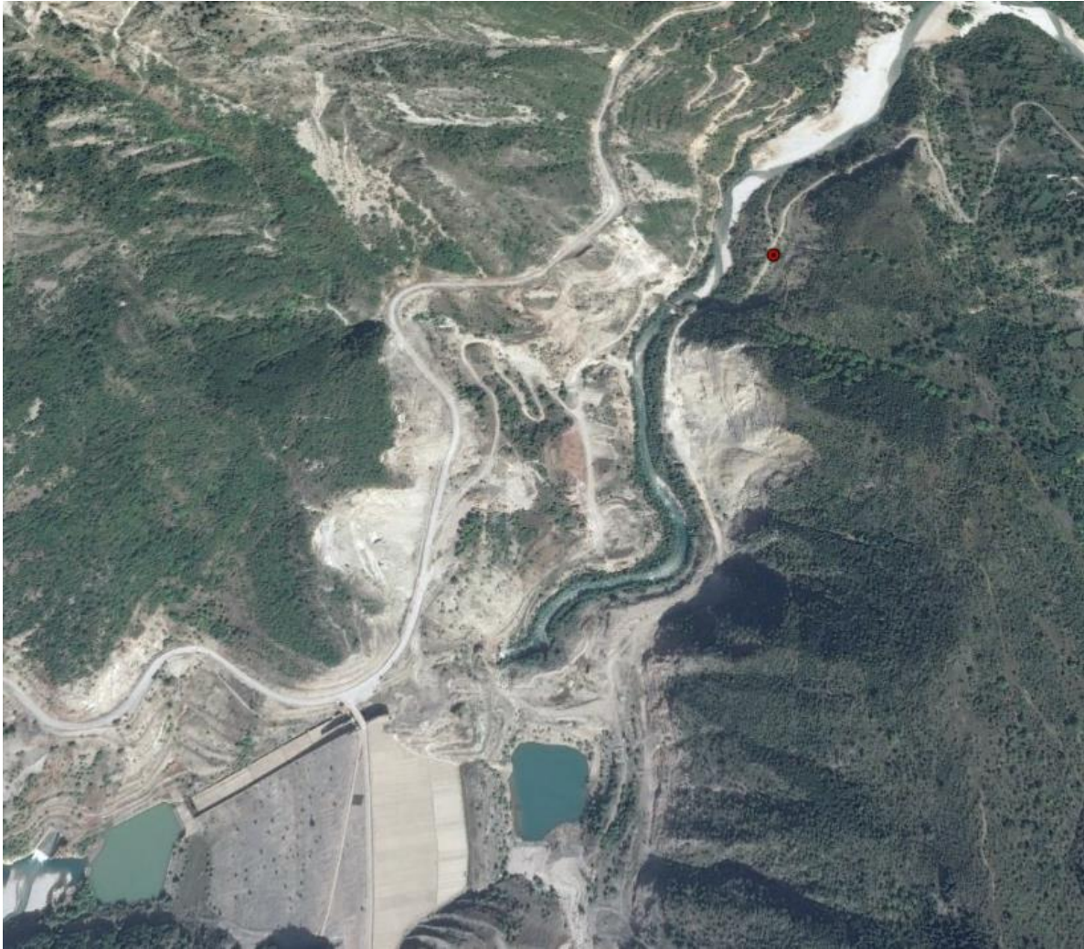
Εικόνα 2.3: Δορυφορική απεικόνιση περιοχής περιοχής υδρομετρικού σταθμού Μεσοχώρας και γενική άποψη των έργων του φράγματος
