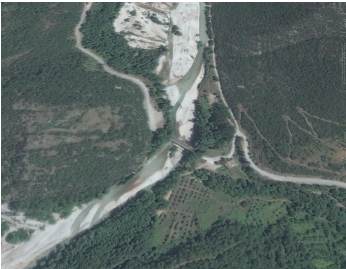
Εικόνα 2.16: Δορυφορική απεικόνιση περιοχής υδρομετρικού σταθμού Γέφυρας Μαρκοπούλου, επί του ποταμού Ταυρωπού
