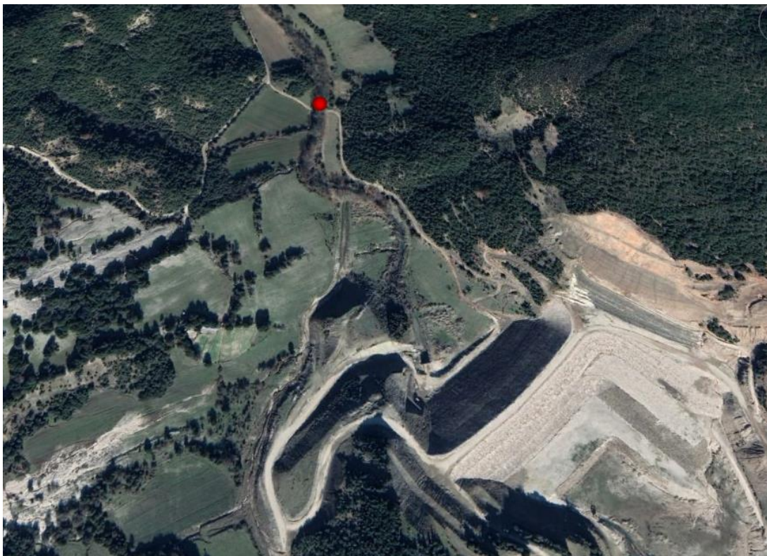
Εικόνα 2.23: Δορυφορική απεικόνιση περιοχής υδρομετρικού σταθμού Αχυρών στον ποταμό Νήσσα, και του υπό κατασκευή φράγματος
