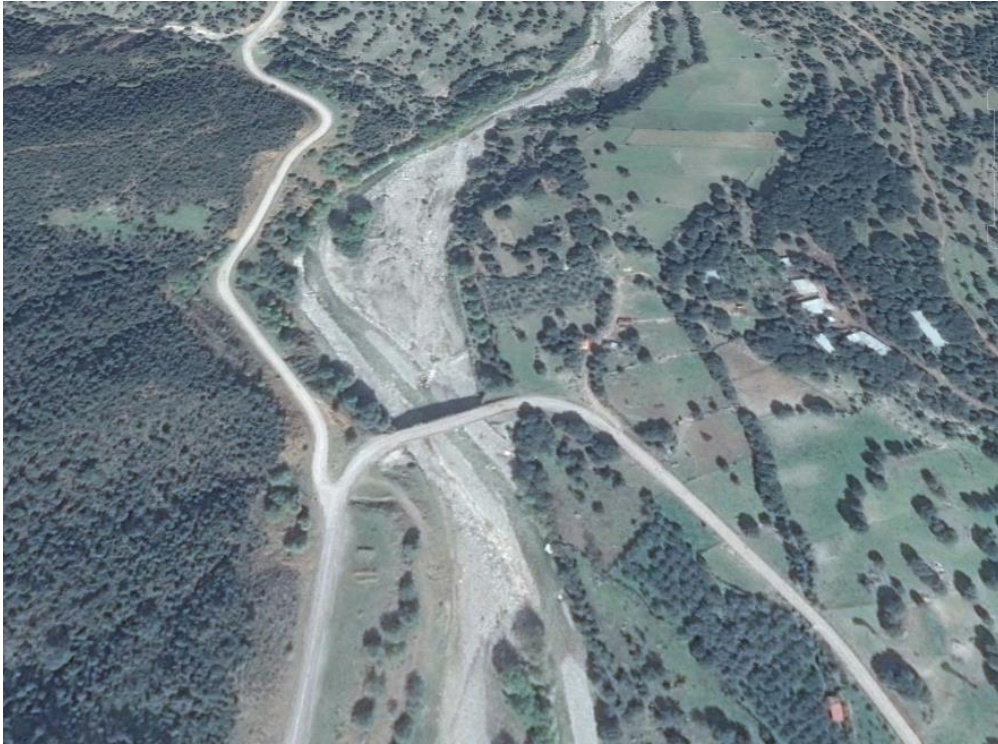
Εικόνα 2.35: Δορυφορική απεικόνιση περιοχής αυτόματου τηλεμετρικού σταθμού νέας Γέφυρας Λευκαδιτίου
