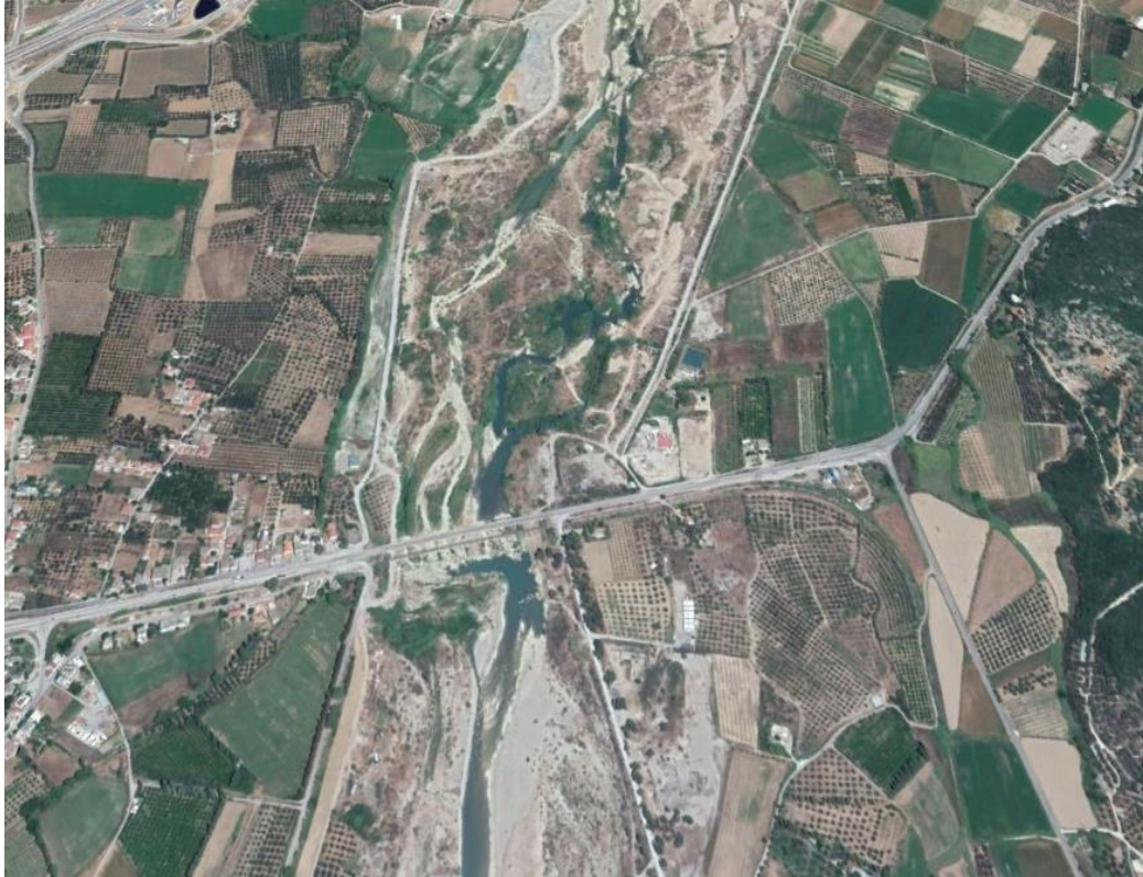
Εικόνα 2.31: Δορυφορική απεικόνιση περιοχής υδρομετρικού σταθμού Γέφυρας Ευηνοχωρίου
