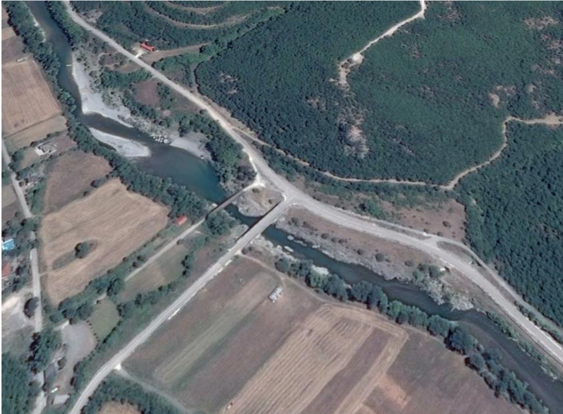
Εικόνα 2.5: Δορυφορική απεικόνιση περιοχής υδρομετρικού σταθμού Γέφυρας Μπουραζανίου.
